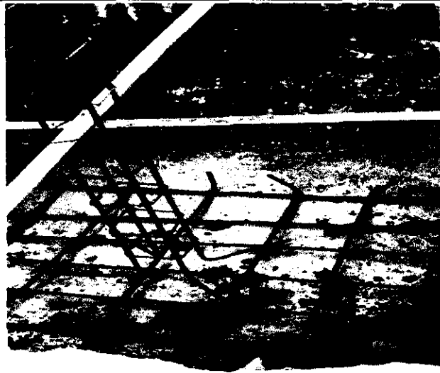
MONTAGEM DAS FERRAGENS PARA SAPATAS E PILARES
