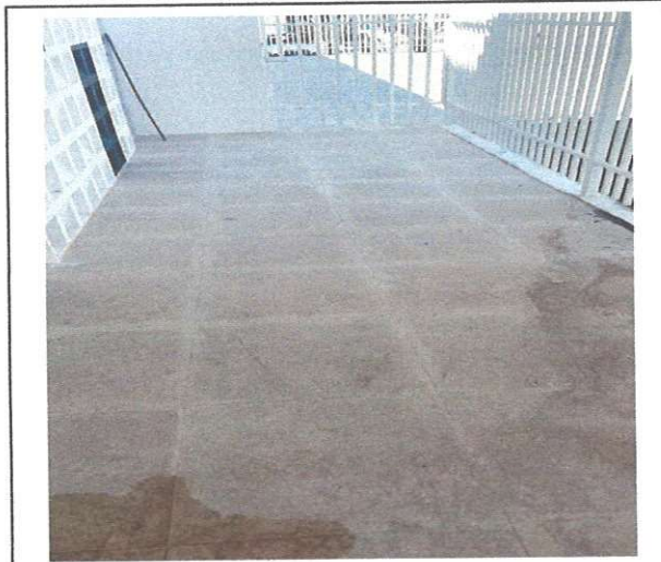
FOTO179: Assentamento piso cerâmico 60x60
