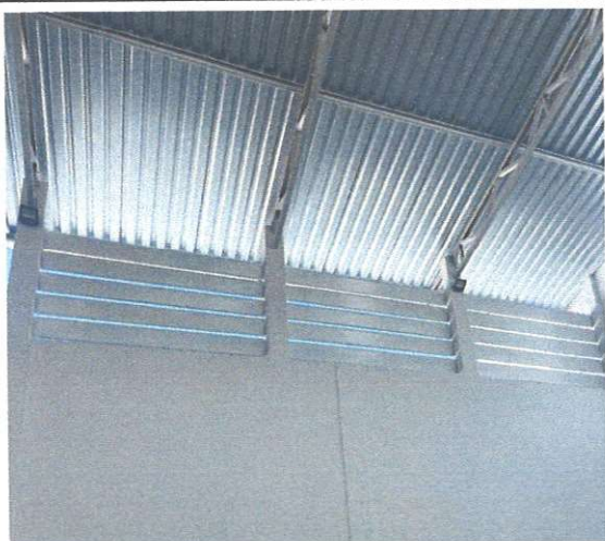
FOTO185: Instalação e pintura dos brises
