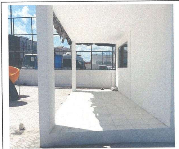
FOTO181: Assentamento piso cerâmico 60x60
