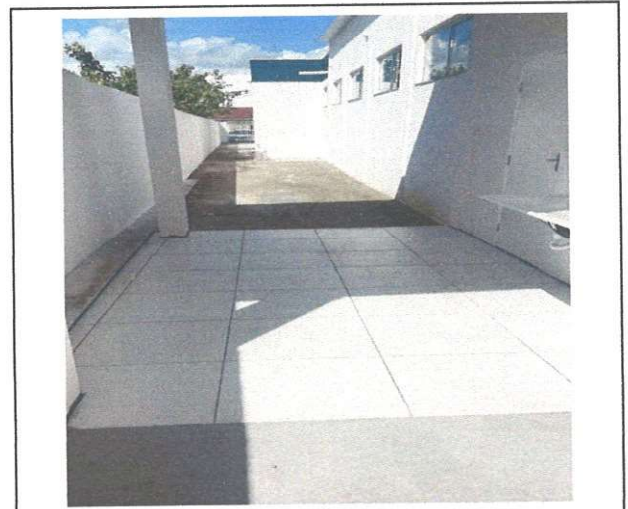
FOTO 180: Assentamento piso cerâmico 60x60
