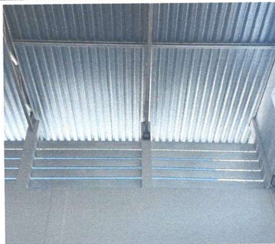
FOTO 184: Instalação e pintura dos brises
