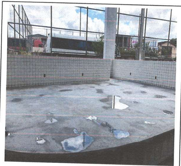
FOTO127: Piso de alta resistência
