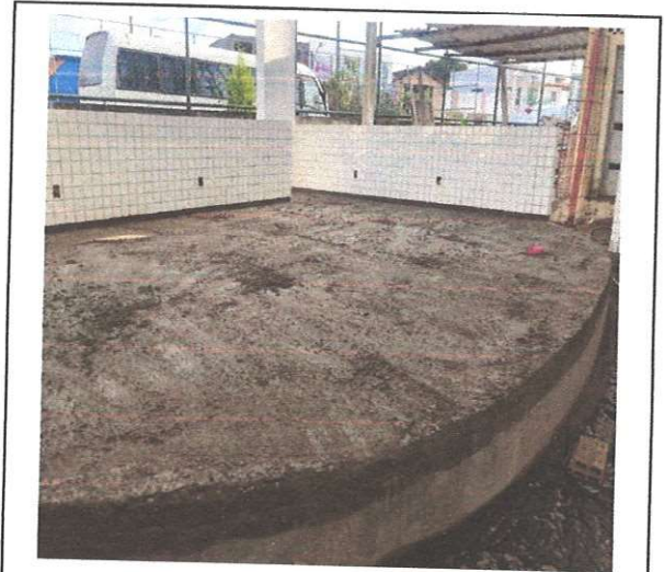
FOTO 126: Laje concreto
