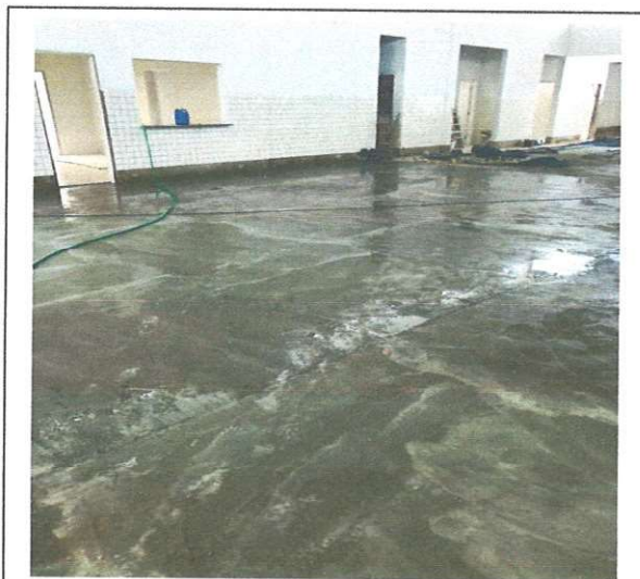
FOTO 107: Piso de alta resistência
