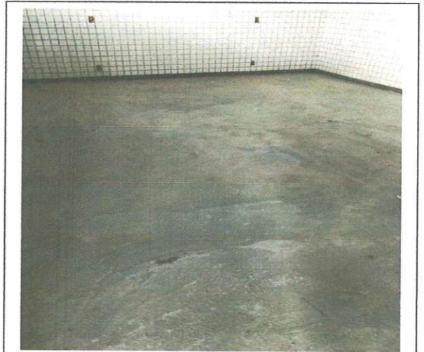
FOTO 106: Piso de alta resistência
