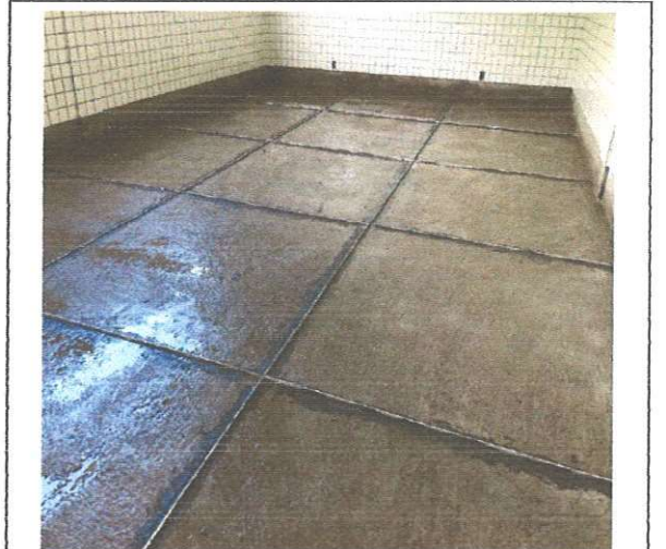
FOTO 114: Piso de alta resistência
