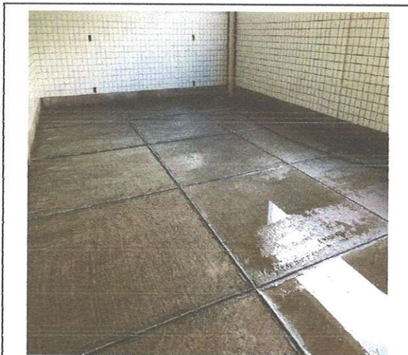
FOTO 115: Piso de alta resistência
