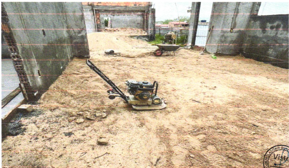
FOTO 04 – ATERRO MANUAL DE VALAS COM SOLO ARGILO-ARENOSO E COMPACTAÇÃO MECANIZADA. AF_05/2016
