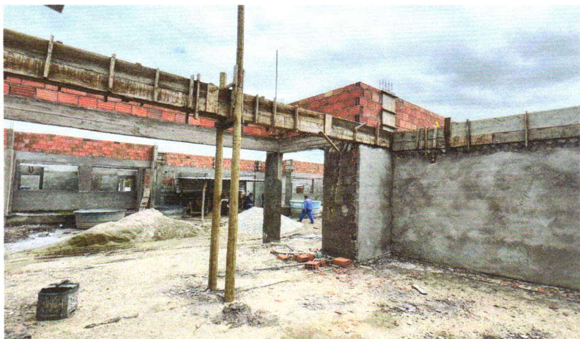
FOTO 02 - MONTAGEM E DESMONTAGEM DE FÔRMA DE VIGA, ESCORAMENTO COM GARFO DE MADEIRA, PÉ-DIREITO SIMPLES, EM CHAPA DE MADEIRA PLASTIFICADA, 12 UTILIZAÇÕES. AF_09/2020
