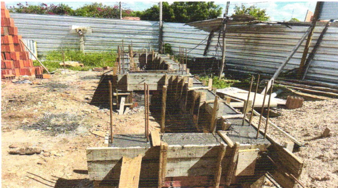
FOTO 13 - Concreto Bombeado fck= 25MPa; incluindo preparo, lançamento e adensamento
