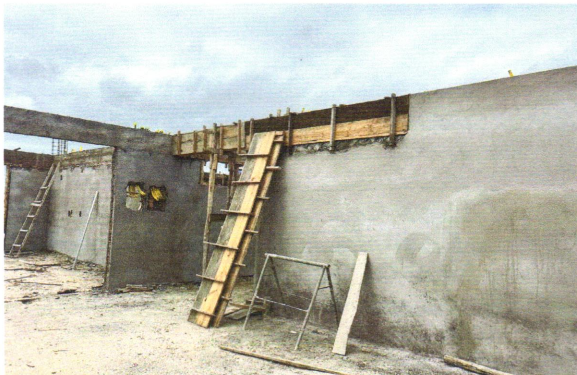
FOTO 06 – Concreto Bombeado fck= 25MPa; incluindo preparo, lançamento e adensamento
