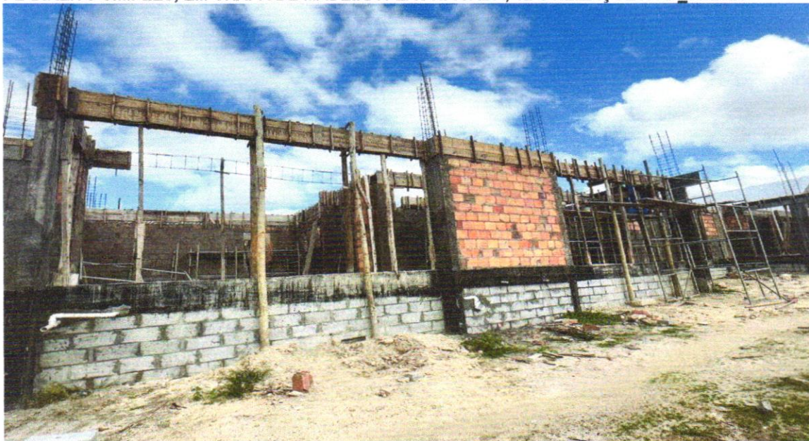
FOTO 02 - MONTAGEM E DESMONTAGEM DE FÔRMA DE VIGA, ESCORAMENTO COM GARFO DE MADEIRA, PÉ-DIREITO SIMPLES, EM CHAPA DE MADEIRA PLASTIFICADA, 12 UTILIZAÇÕES. AF_09/2020
