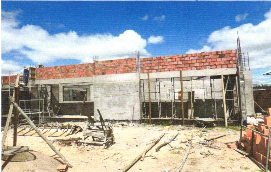
FOTO 16 – ALVENARIA DE VEDAÇÃO DE BLOCOS CERÂMICOS FURADOS NA VERTICAL DE 14X19X39CM (ESPESSURA 14CM) DE PAREDES COM ÁREA LÍQUIDA MAIOR OU IGUAL A 6M 2 COM VÃOS E ARGAMASSA DE ASSENTAMENTO COM PREPARO EM BETONEIRA. AF_06/2014
