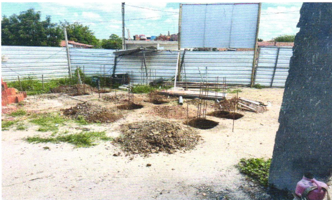
FOTO 08 – Regularização e compactação do fundo de valas
