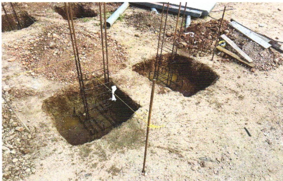
FOTO 08 – Regularização e compactação do fundo de valas
