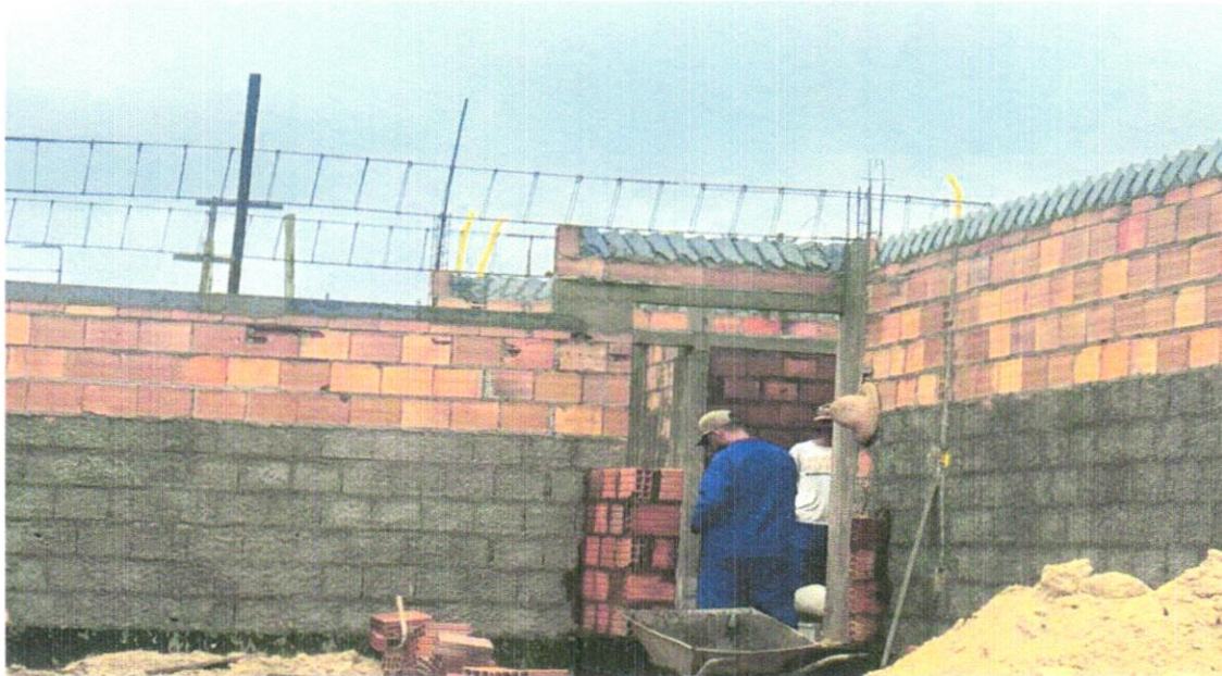
FOTO 13 - Armação de aço CA-60 Ø 5,0mm; incluso fornecimento, corte, dobra e colocação
