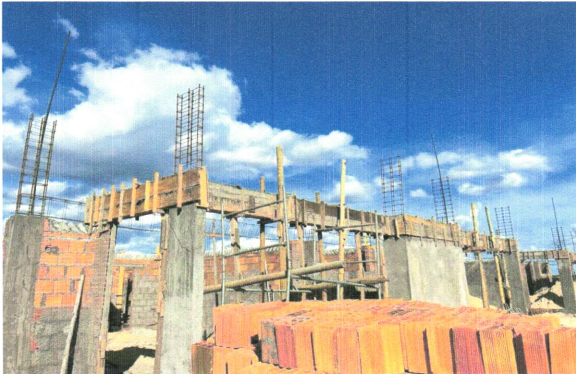
FOTO 08 – Armação de aço CA-50 Ø 8mm; incluso fornecimento, corte, dobra e colocação
