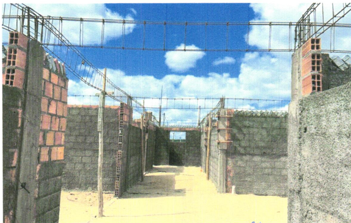
FOTO 08 – Armação de aço CA-50 Ø 8mm; incluso fornecimento, corte, dobra e colocação
