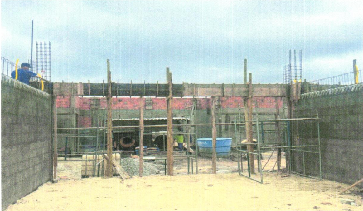
FOTO 06 - MONTAGEM E DESMONTAGEM DE FÔRMA DE VIGA, ESCORAMENTO COM GARFO DE MADEIRA, PÉ-DIREITO SIMPLES, EM CHAPA DE MADEIRA PLASTIFICADA, 12 UTILIZAÇÕES. AF_09/2020
