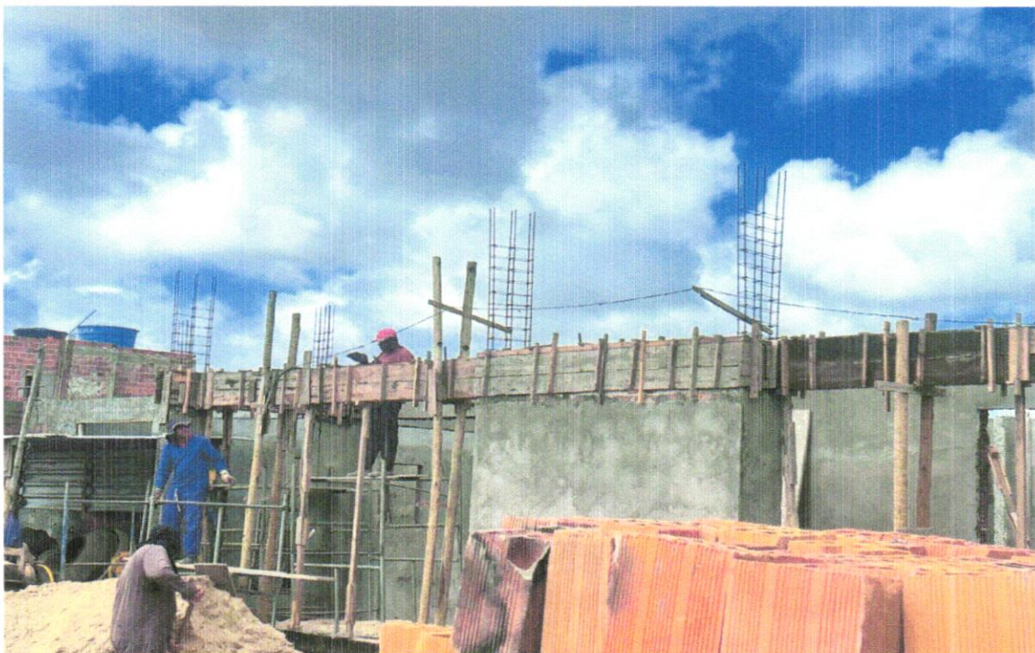
FOTO 22 – Concreto Bombeado fck= 25MPa; incluindo preparo, lançamento e adensamento
