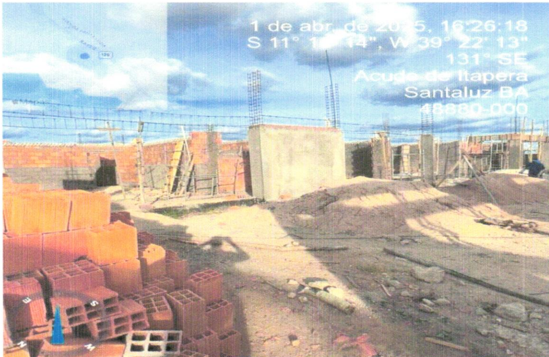
FOTO 18 - Armação de aço CA-50 Ø 10mm; incluso fornecimento, corte, dobra e colocação
