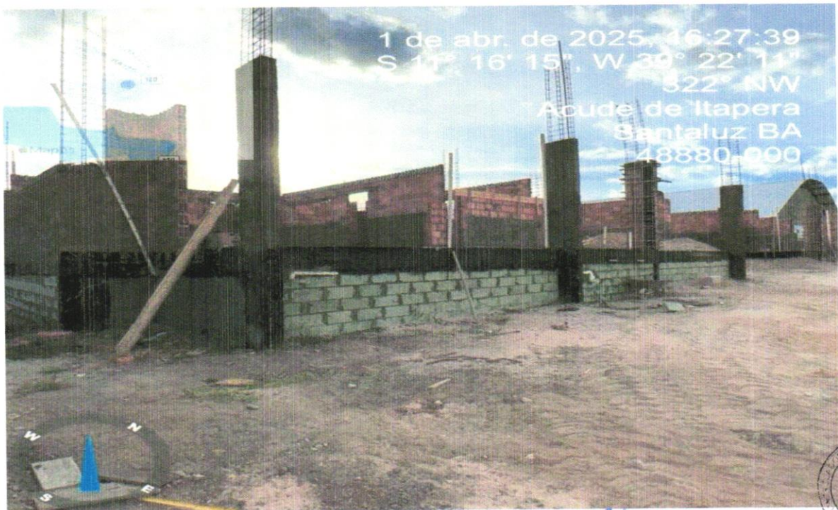
FOTO 12 - Concreto Bombeado fck= 25MPa; incluindo preparo, lançamento e adensamento
