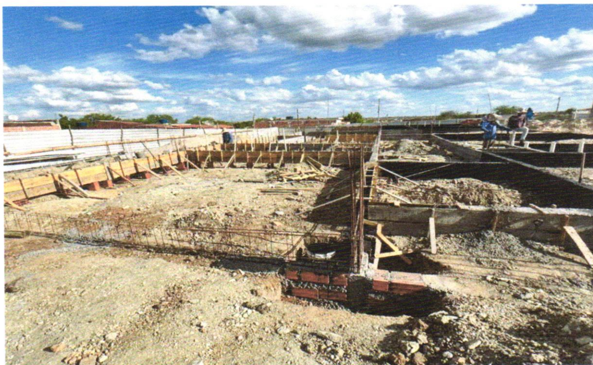
FOTO 16 – Armação de aço CA-60 Ø 5,0mm; incluso fornecimento, corte, dobra e colocação
