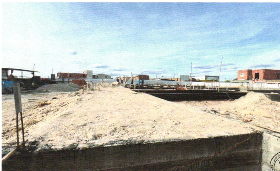
FOTO 08 – REATERRO MANUAL DE VALAS COM COMPACTAÇÃO MECANIZADA. AF_04/2016
