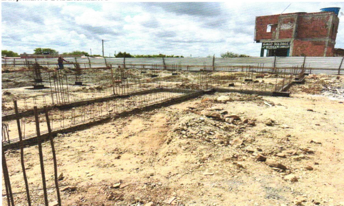
FOTO 12 - LASTRO DE CONCRETO, PREPARO MECÂNICO, INCLUSOS ADITIVO IMPERMEABILIZANTE, LANÇAMENTO E ADENSAMENTO
