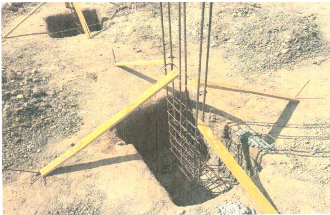
FOTO 22 – Armação de aço CA-50 Ø 12,5mm; incluso fornecimento, corte, dobra e colocação
