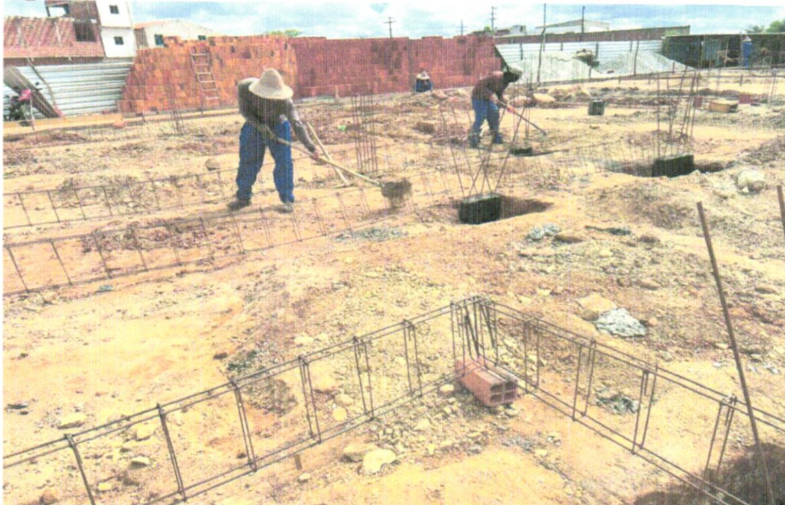
FOTO 08 – ATERRO MANUAL DE VALAS COM SOLO ARGILLO-ARENOSO E COMPACTAÇÃO MECANIZADA. AF_05/2016
