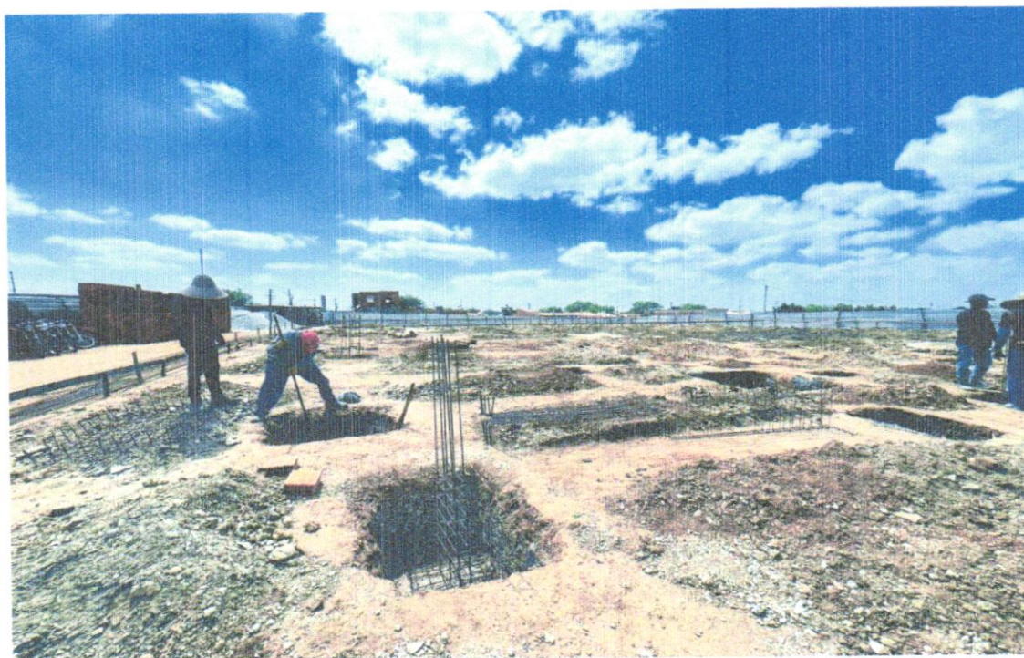
FOTO 22 – Armação de aço CA-50 Ø 12,5mm; incluso fornecimento, corte, dobra e colocação
