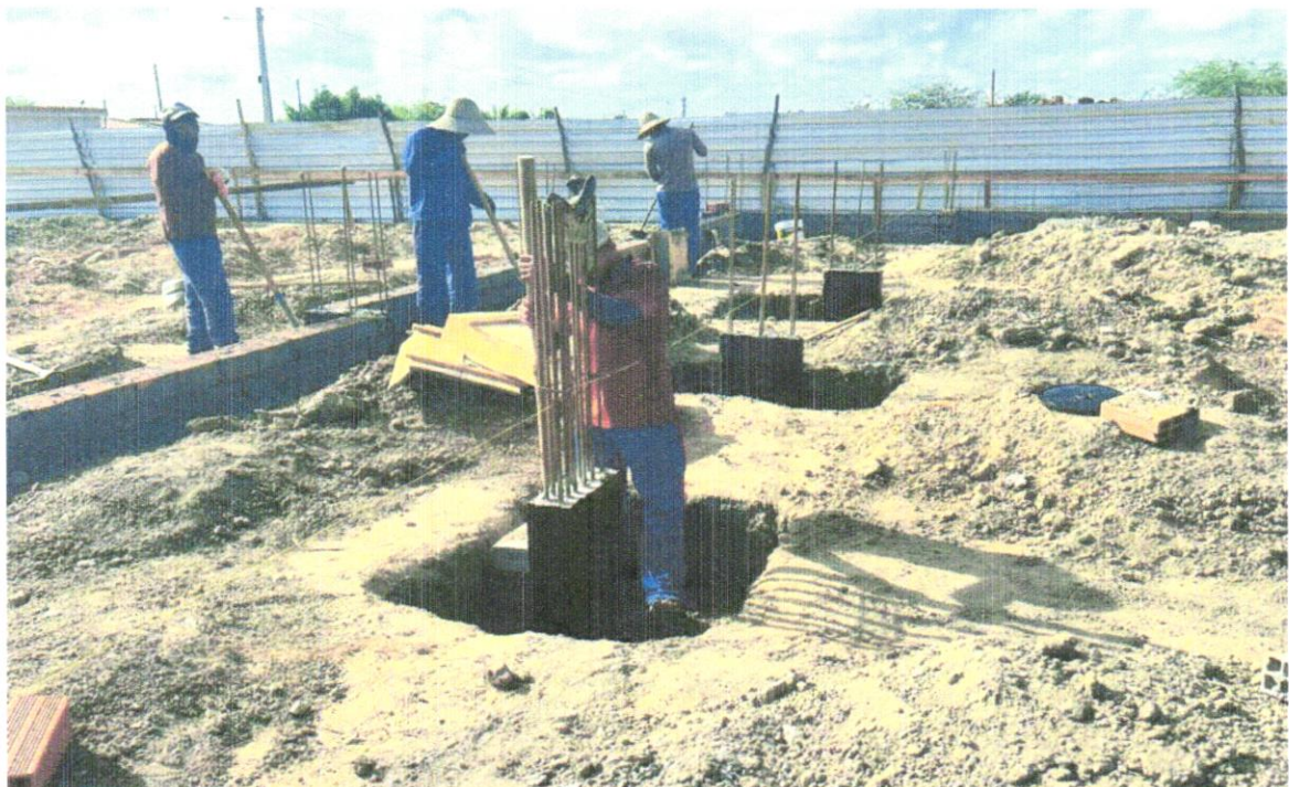
FOTO 12 – Regularização e compactação do fundo de valas
