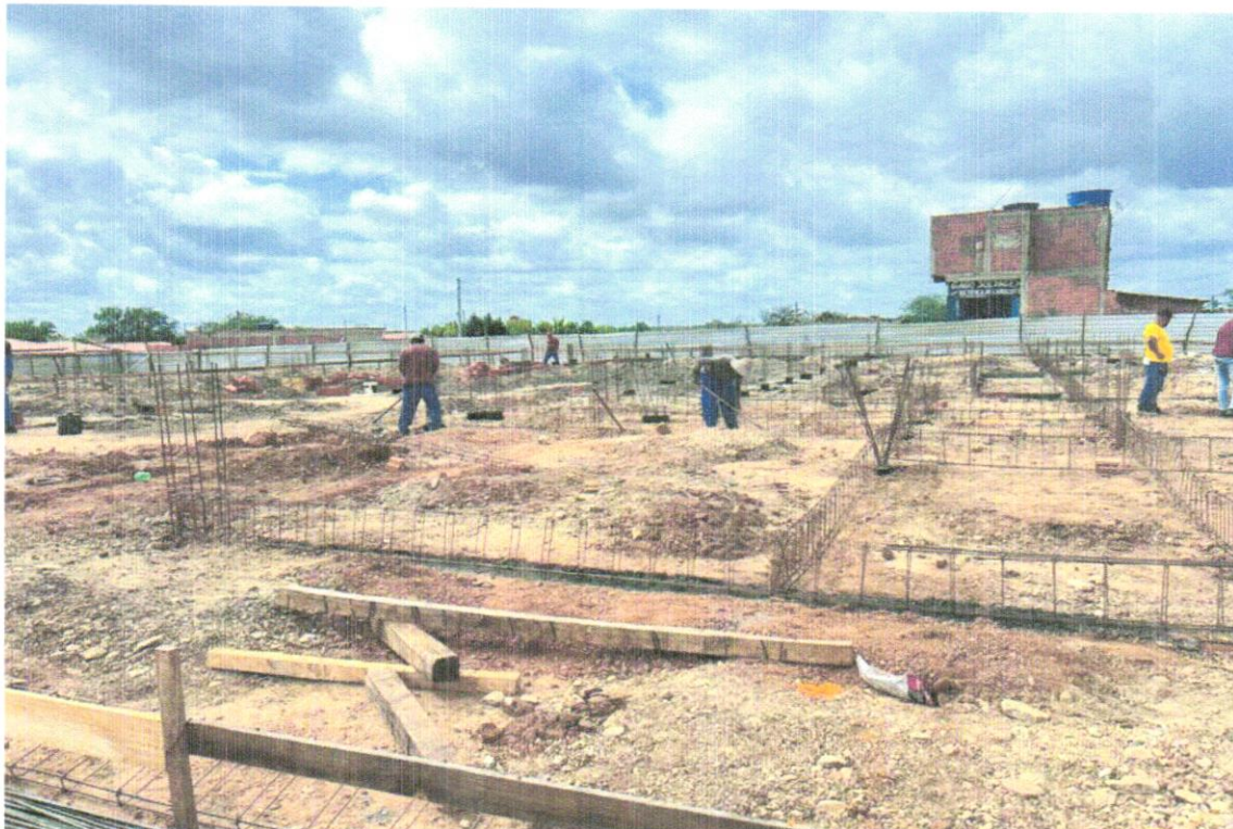
FOTO 10 – Regularização e compactação do fundo de valas
