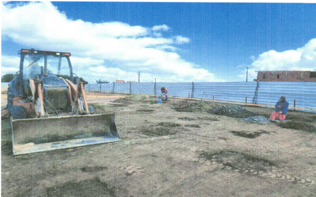
FOTO 04 – LIMPEZA MECANIZADA DE CAMADA VEGETAL, VEGETAÇÃO E PEQUENAS ÁRVORES (DIÂMETRO DE TRONCO MENOR QUE 0,20 M), COM TRATOR DE ESTEIRAS.AF_05/2018
