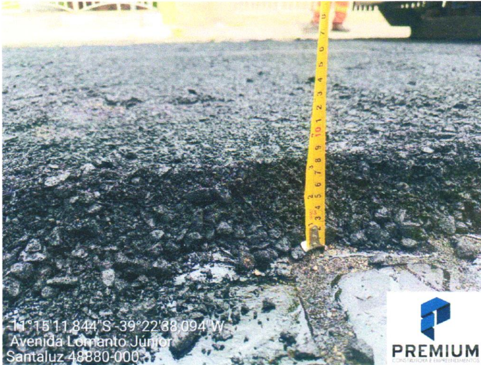
Foto 03- Espessura da massa asfáltica.
