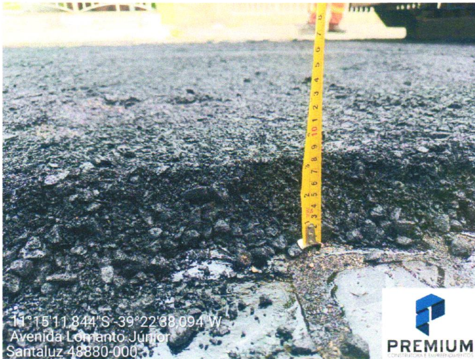
Foto 04- Espessura da massa asfáltica.
