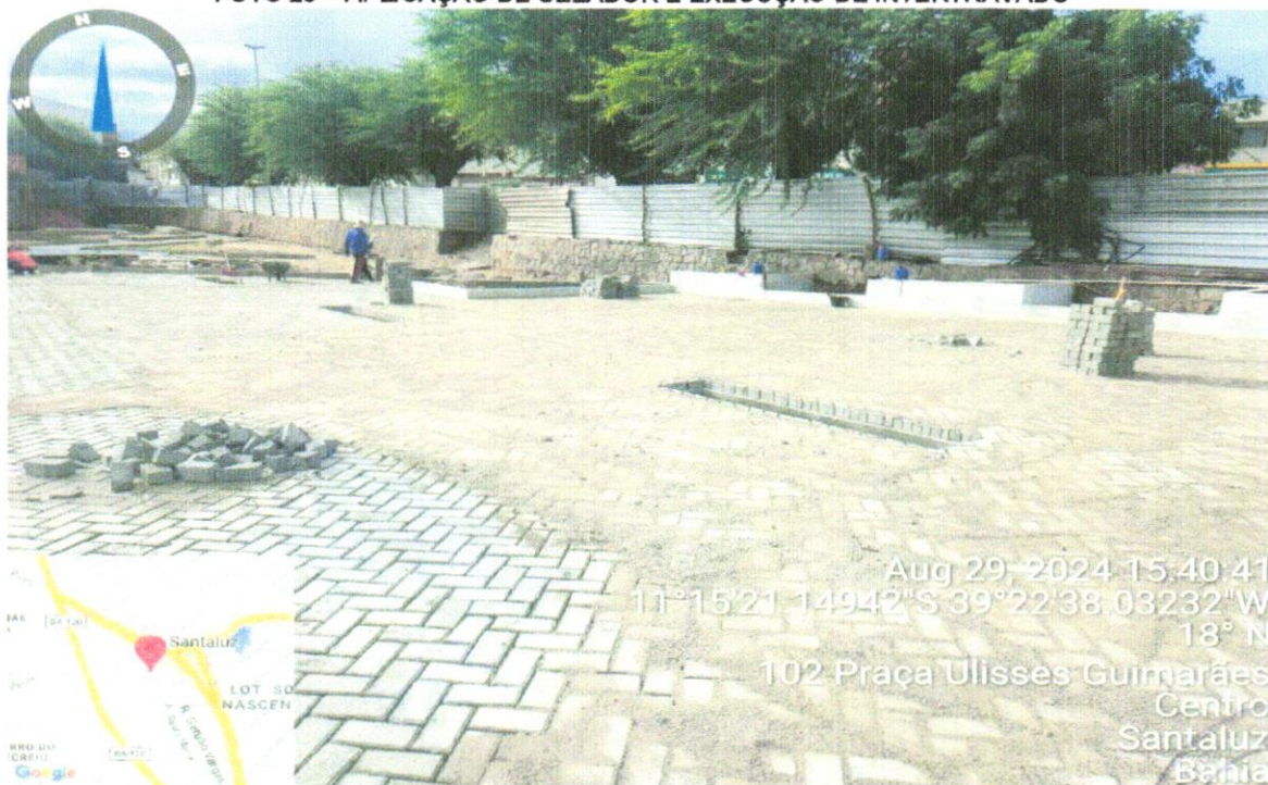
FOTO 28 – APLICAÇÃO DE SELADOR E EXECUÇÃO DE INTERTRAVADO
