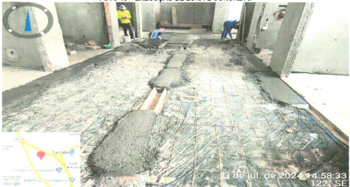
FOTO 18 – EXECUÇÃO DE LONA E CONCRETO
