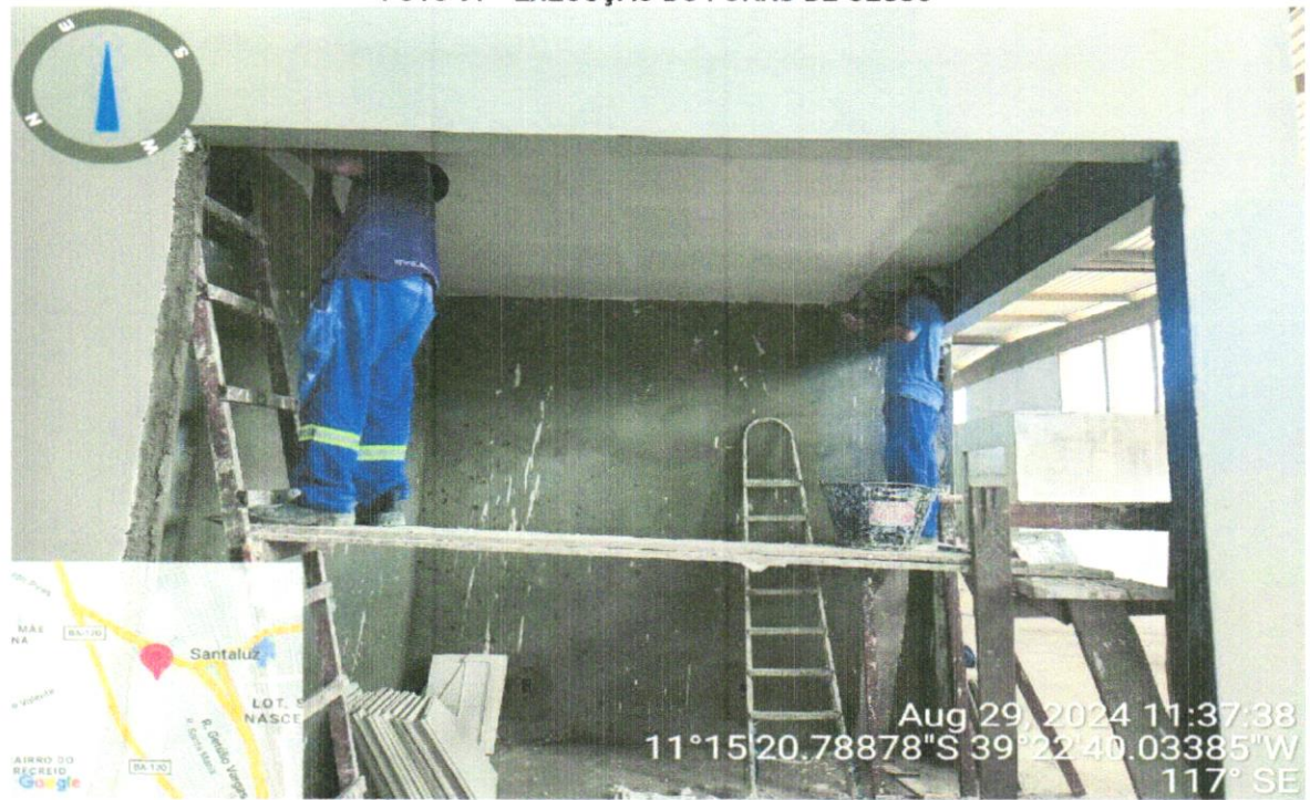
FOTO 02 – EXECUÇÃO DO FORRO DE GESSO
