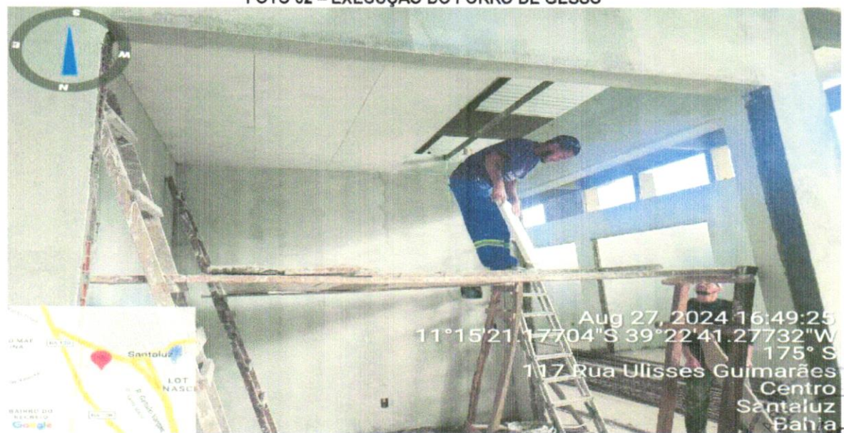
FOTO 02 – EXECUÇÃO DO FORRO DE GESSO
