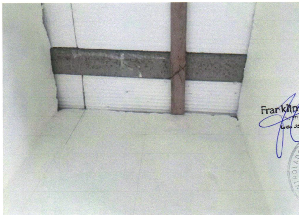
Foto 16 - Laje pré-fabricada treliçada para piso ou cobertura, intereixo 38cm, h=12cm, el. enchimento em EPS h=8cm, inclusive escoramento em madeira e capeamento 4cm.
