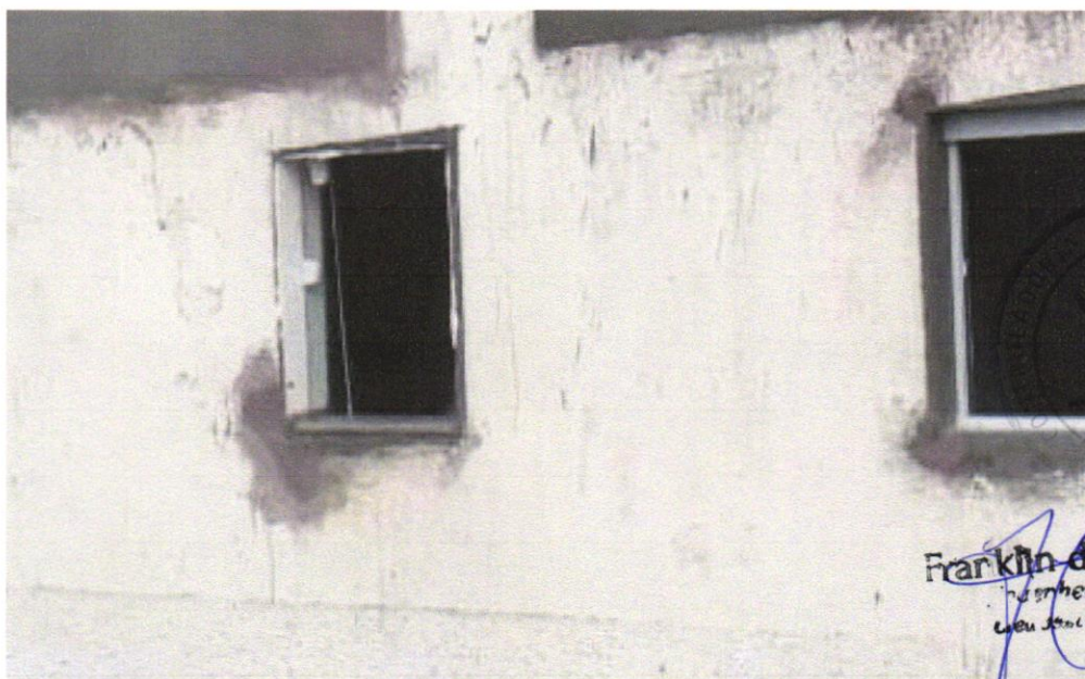
Foto 26 - JANELA DE ALUMÍNIO TIPO MAXIM-AR, COM VIDROS, BATENTE E FERRAGENS. EXCLUSIVE ALIZAR, ACABAMENTO E CONTRAMARCO. FORNECIMENTO E INSTALAÇÃO. AF_12/2019
