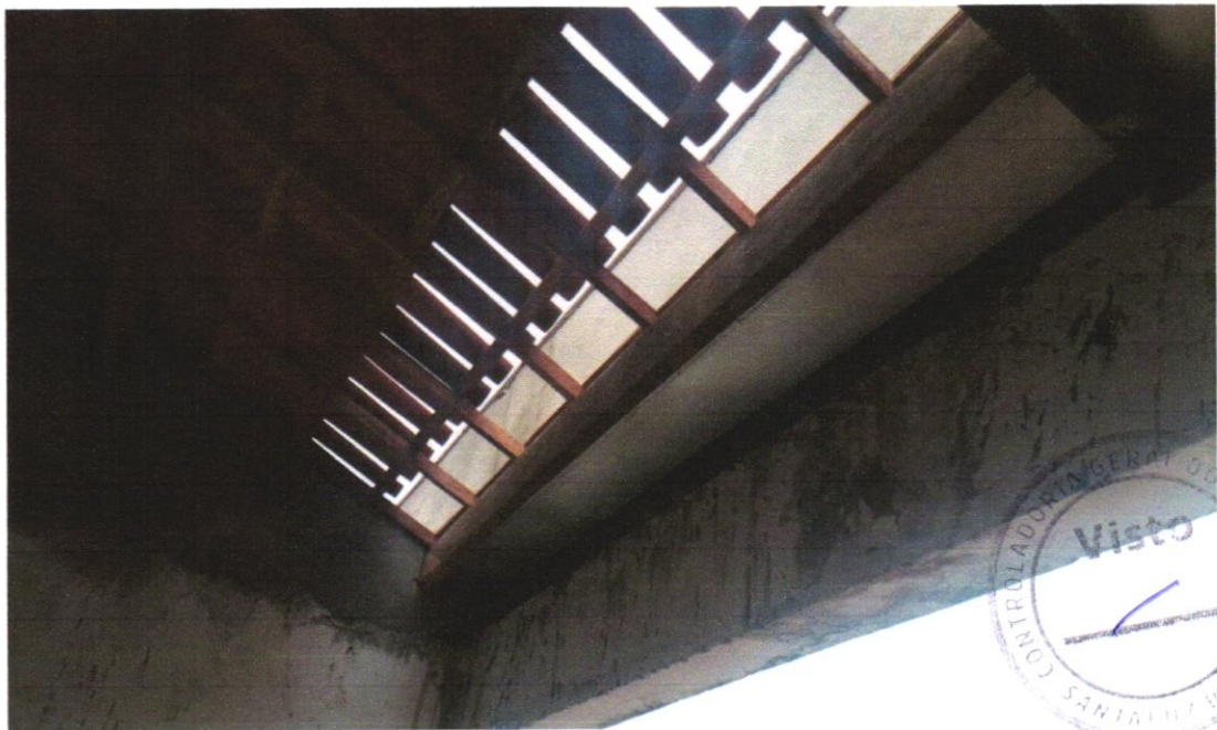
Foto 10 - CALHA EM CHAPA DE AÇO GALVANIZADO NÚMERO 24, DESENVOLVIMENTO DE 33 CM, INCLUSO TRANSPORTE VERTICAL. AF_07/2019
