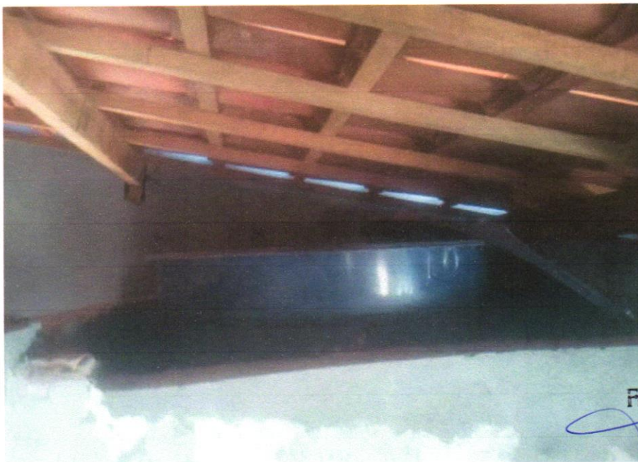
Foto 18 - CAIXA D'ÁGUA EM POLIÉSTER REFORÇADO COM FIBRA DE VIDRO, 500 LITROS - FORNECIMENTO E INSTALAÇÃO. AF_06/2021
