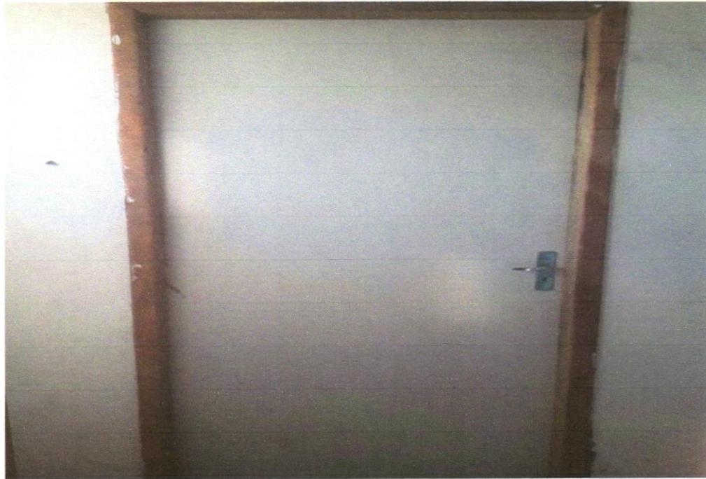
Foto 15 - KIT DE PORTA-PRONTA DE MADEIRA EM ACABAMENTO MELAMÍNICO BRANCO, FOLHA LEVE OU MÉDIA, 80X210CM, EXCLUSIVE FECHADURA, FIXAÇÃO COM PREENCHIMENTO PARCIAL DE ESPUMA EXPANSIVA - FORNECIMENTO E INSTALAÇÃO. AF_12/2019
