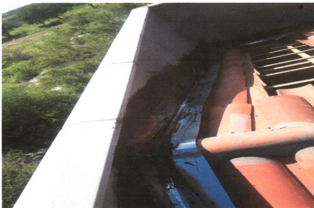
Foto 11 - Rufo em chapa aço galvanizado nº24 com desenvolvimento 16cm
