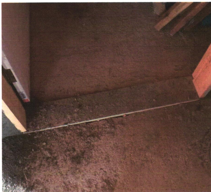
Foto 08 - SOLEIRA EM MÁRMORE. LARGURA 15 CM. ESPESSURA 2.0 CM. AF 09/2020
