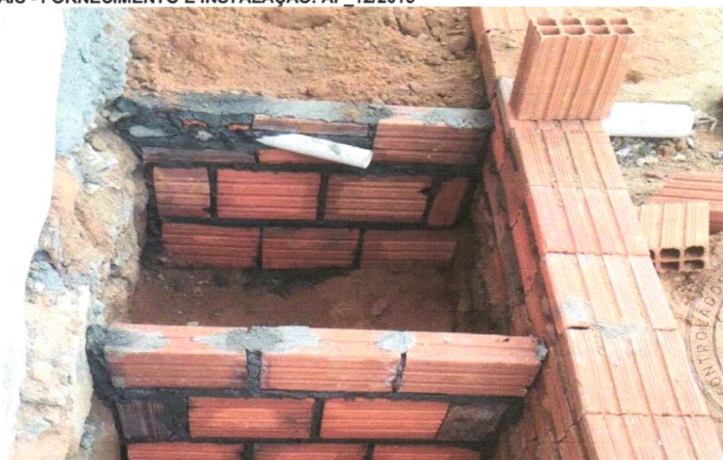
Foto 20 --ALVENARIA DE VEDAÇÃO DE BLOCOS CERÂMICOS FURADOS NA HORIZONTAL DE 9X19X29 CM (ESPESSURA 9 CM) E ARGAMASSA DE ASSENTAMENTO COM PREPARO EM BETONEIRA. AF_12/2021
