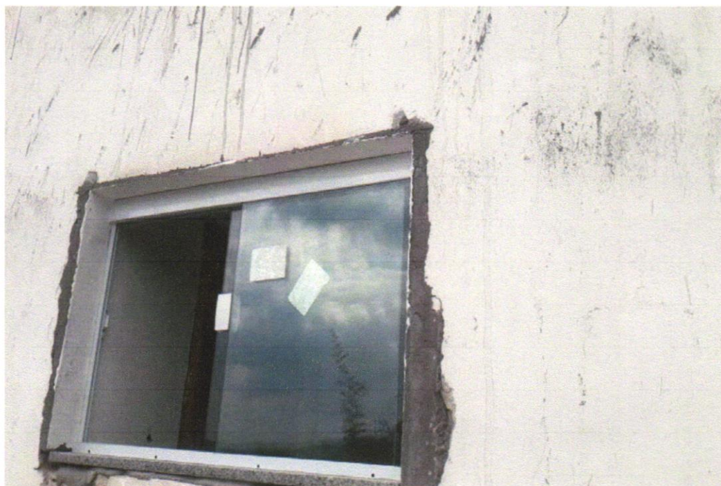
Foto 25 - JANELA DE ALUMÍNIO DE CORRER COM 2 FOLHAS PARA VIDROS, COM VIDROS, BATENTE, ACABAMENTO COM ACETATO OU BRILHANTE E FERRAGENS. EXCLUSIVE ALIZAR E CONTRAMARCO. FORNECIMENTO E INSTALAÇÃO. AF_12/2019
