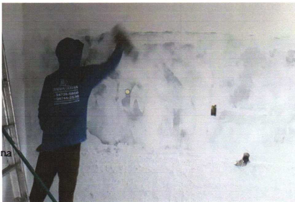
FOTO 01 – Preparo de superfície com lixamento de paredes e tetos
