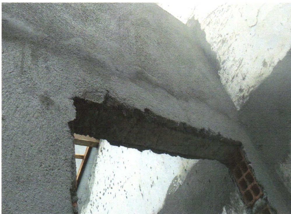
Foto 23 - VERGA PRÉ-MOLDADA PARA JANELAS COM ATÉ 1,5 M DE VÃO. AF_03/2016
