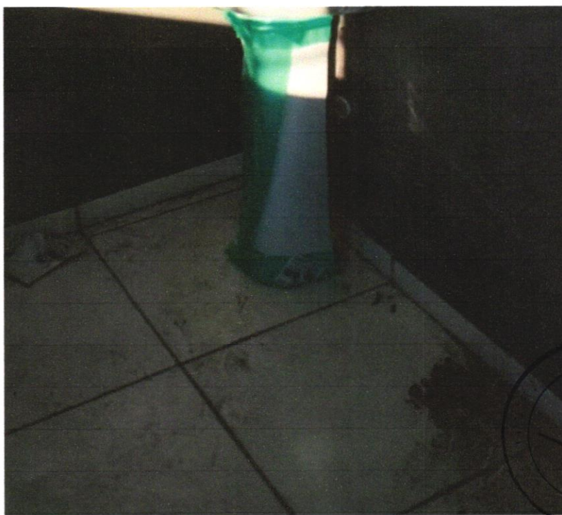
Foto 14 - RODAPÉ CERÂMICO DE 7CM DE ALTURA COM PLACAS TIPO ESMALTADA EXTRA DE DIMENSÕES 45X45CM. AF_06/2014
