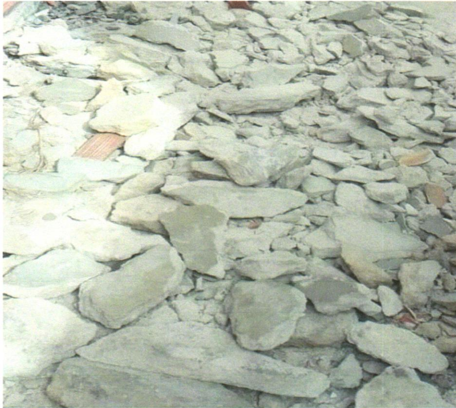
Foto 21 - Demolição manual de piso cimentado sobre lastro de concreto - Rev 01
