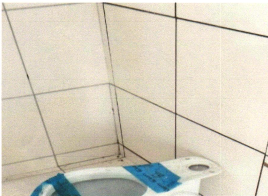
Foto 13 - REVESTIMENTO CERÂMICO PARA PAREDES INTERNAS COM PLACAS TIPO ESMALTADA EXTRA DE DIMENSÕES 33X45 CM APLICADAS EM AMBIENTES DE ÁREA MAIOR QUE 5 M 2 A MEIA ALTURA DAS PAREDES. AF_06/2014
