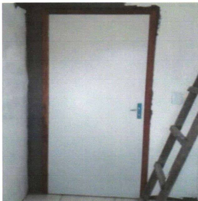
FOTO 04 – KIT DE PORTA-PRONTA DE MADEIRA EM ACABAMENTO MELAMÍNICO BRANCO, FOLHA LEVE OU MÉDIA, 60X210CM, EXCLUSIVE FECHADURA, FIXAÇÃO COM PREENCHIMENTO PARCIAL DE ESPUMA EXPANSIVA - FORNECIMENTO E INSTALAÇÃO
