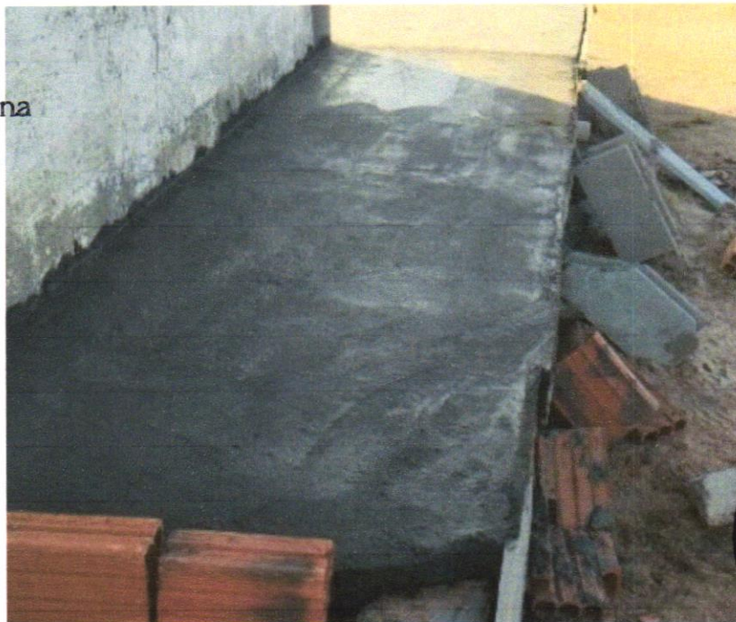
FOTO 12 – EXECUÇÃO DE PASSEIO (CALÇADA) OU PISO DE CONCRETO COM CONCRETO MOLDADO IN LOCO, USINADO, ACABAMENTO CONVENCIONAL, NÃO ARMADO. AF_07/2016
