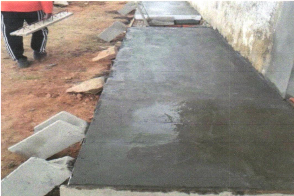
Foto 15 - EXECUÇÃO DE PASSEIO (CALÇADA) OU PISO DE CONCRETO COM CONCRETO MOLDADO IN LOCO, USINADO, ACABAMENTO CONVENCIONAL, NÃO ARMADO. AF_07/2016
