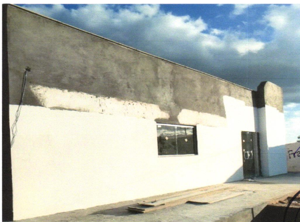
Foto 24- APLICAÇÃO E LIXAMENTO DE MASSA LÁTEX EM PAREDES, UMA DEMÃO. AF_06/2014
