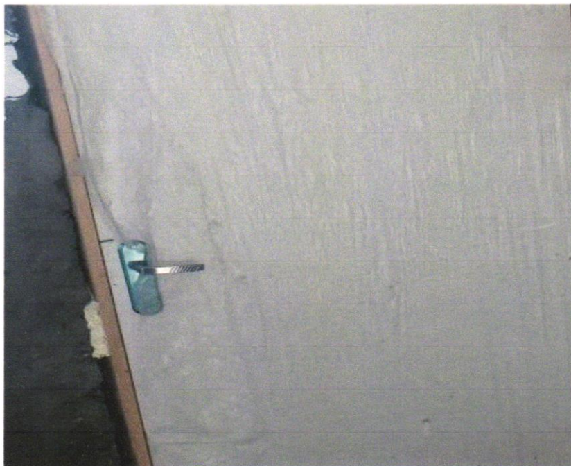
FOTO 25 - FECHADURA DE EMBUTIR PARA PORTAS INTERNAS, COMPLETA, ACABAMENTO PADRÃO MÉDIO, COM EXECUÇÃO DE FURO - FORNECIMENTO E INSTALAÇÃO. AF_12/2019
