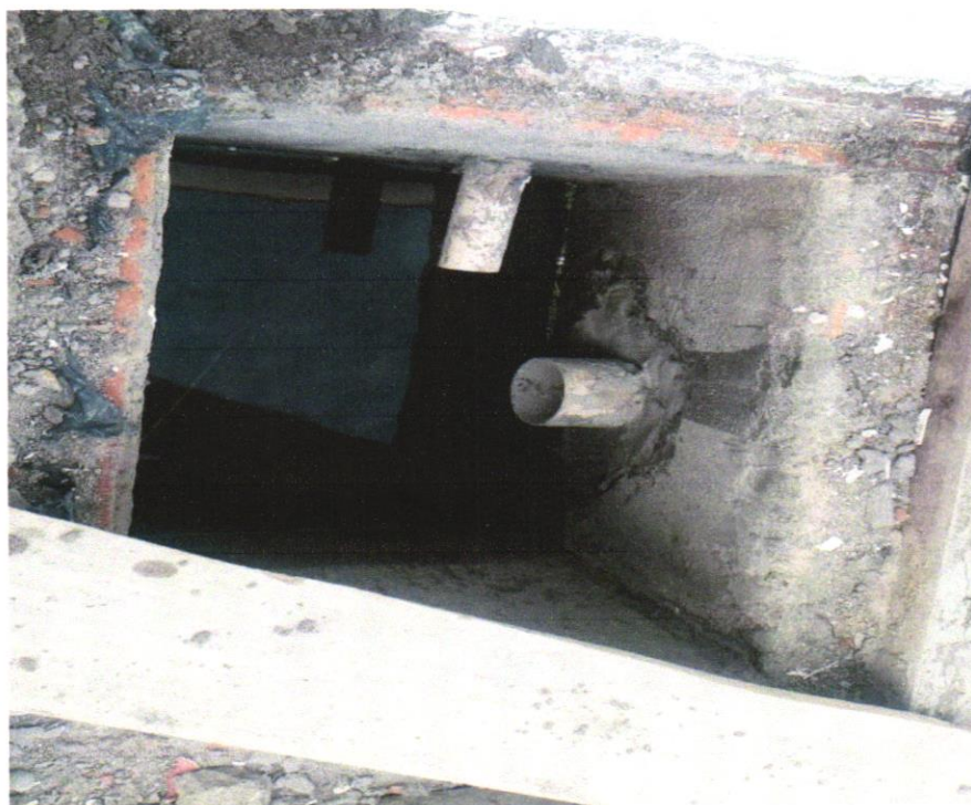
FOTO 22 - TUBO DE PVC BRANCO PARA REDE COLETORA DE ESGOTO CONDOMINIAL DE PAREDE MACIÇA, DN 100 MM, JUNTA ELÁSTICA - FORNECIMENTO E ASSENTAMENTO. AF_01/2021
