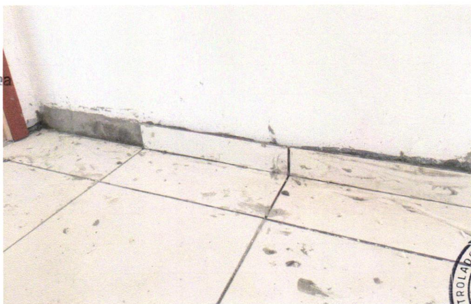
FOTO 30 - RODAPÉ CERÂMICO DE 7CM DE ALTURA COM PLACAS TIPO ESMALTADA COMERCIAL DE DIMENSÕES 35X35CM (PADRAO POPULAR). AF_06/2017
