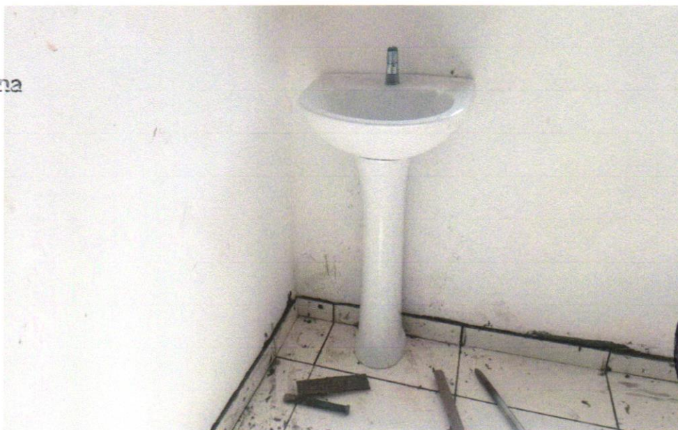
FOTO 24 - LAVATÓRIO LOUÇA BRANCA COM COLUNA, *44 X 35,5* CM, PADRÃO POPULAR, INCLUSO SIFÃO FLEXÍVEL EM PVC, VÁLVULA E ENGATE FLEXÍVEL 30CM EM PLÁSTICO E COM TORNEIRA CROMADA PADRÃO POPULAR - FORNECIMENTO E INSTALAÇÃO. AF_01/2020
