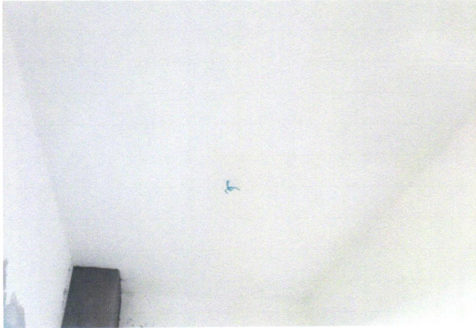
Foto 09 - Forro de gesso comum, em placas 60x60 cm, inclusive madeiramento com ripões 3,5cm x 5,5cm, instalado
