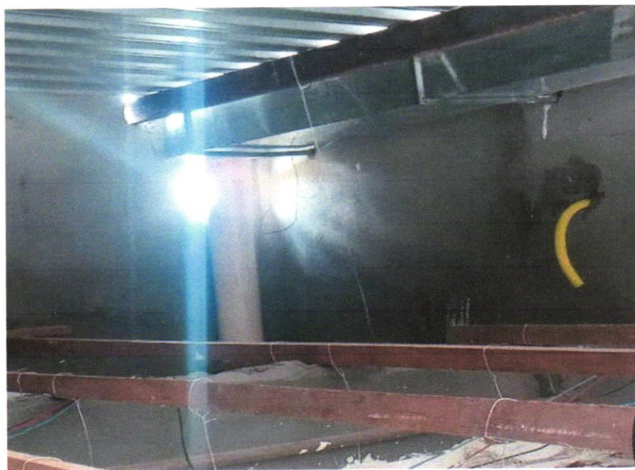
FOTO 06 – UBO PVC, SÉRIE R, ÁGUA PLUVIAL, DN 100 MM, FORNECIDO E INSTALADO EM RAMAL DE ENCAMINHAMENTO. AF_06/2022
