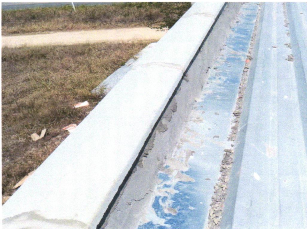
FOTO 15 - Rufo em chapa aço galvanizado nº24 com desenvolvimento 25cm
