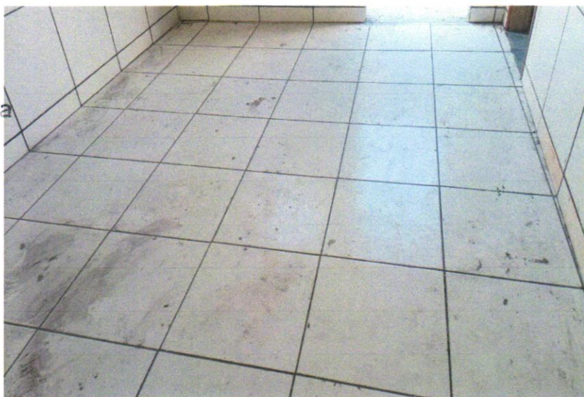
FOTO 26 - REVESTIMENTO CERÂMICO PARA PISO COM PLACAS TIPO ESMALTADA EXTRA DE DIMENSÕES 45X45 CM APLICADA EM AMBIENTES DE ÁREA ENTRE 5 M2 E 10 M2. AF_06/2014
