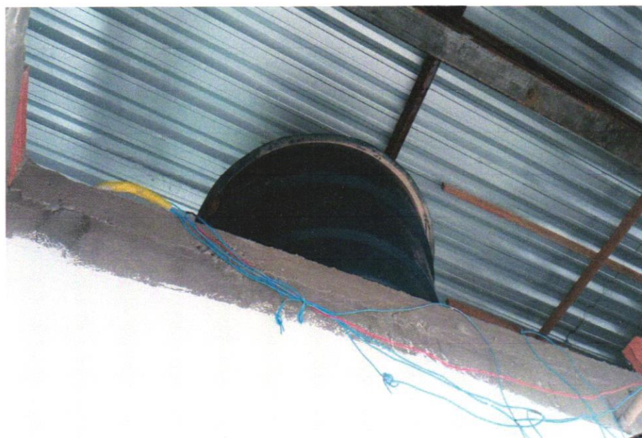
FOTO 20- CAIXA D'ÁGUA EM POLIETILENO, 500 LITROS - FORNECIMENTO E INSTALAÇÃO. AF_06/2021
