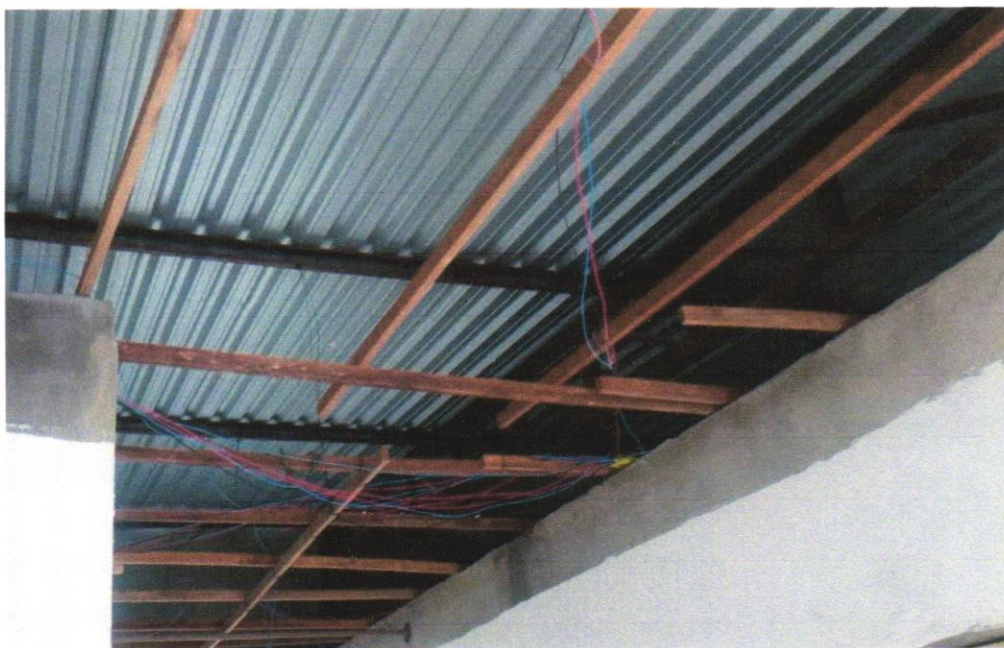
FOTO 13 - CABO DE COBRE FLEXÍVEL ISOLADO, 4 MM 2 , ANTI-CHAMA 450/750 V, PARA CIRCUITOS TERMINAIS - FORNECIMENTO E INSTALAÇÃO. AF_12/2015
