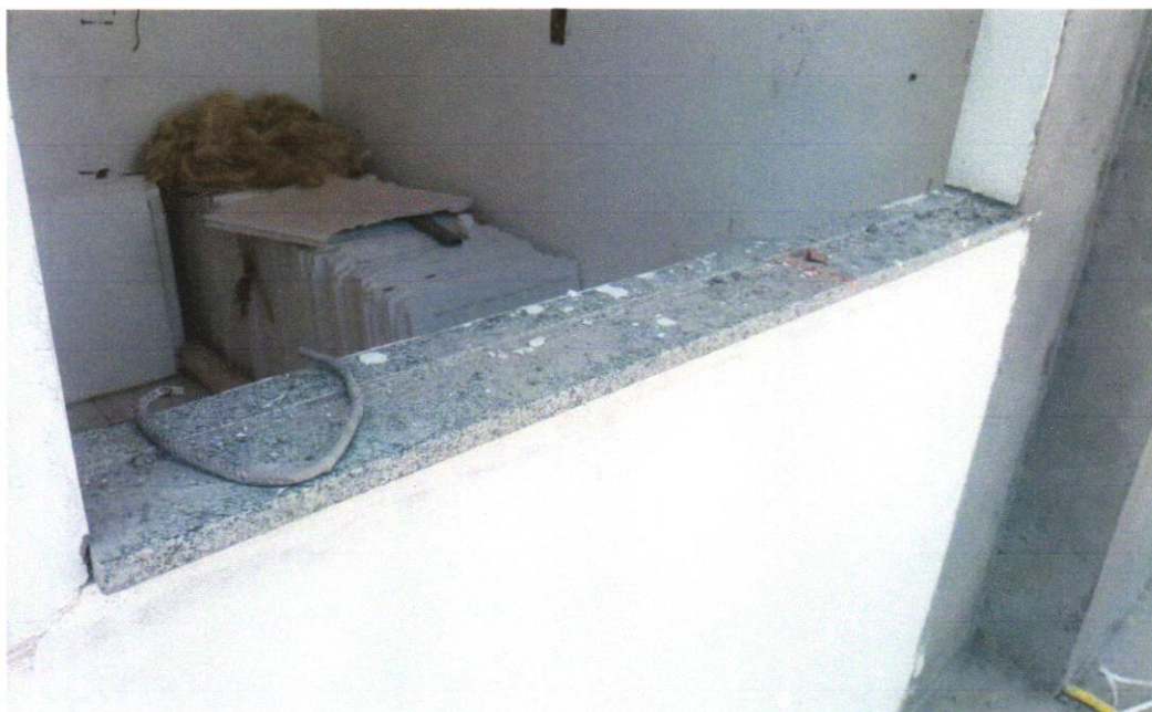
FOTO 33 - PEITORIL LINEAR EM GRANITO OU MÁRMORE, L = 15CM, COMPRIMENTO DE ATÉ 2M, ASSENTADO COM ARGAMASSA 1:6 COM ADITIVO. AF_11/2020
