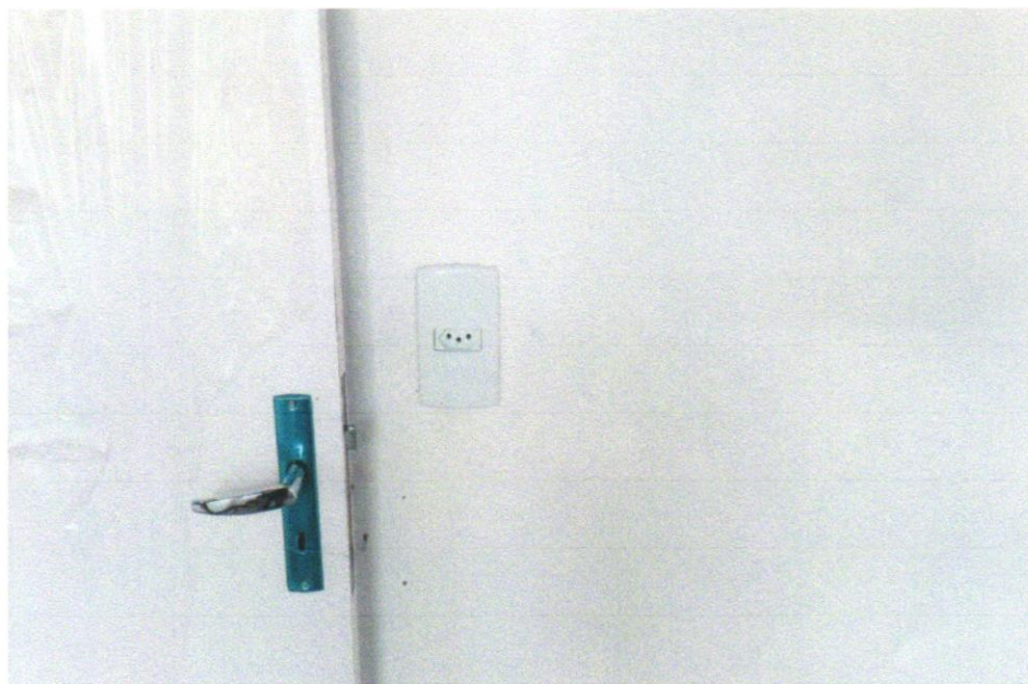
FOTO 19 - TOMADA MÉDIA DE EMBUTIR (1 MÓDULO), 2P+T 10 A, INCLUINDO SUPORTE E PLACA - FORNECIMENTO E INSTALAÇÃO. AF_12/2015
