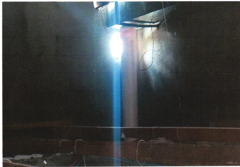
FOTO 05 – TUBO PVC, SÉRIE R, ÁGUA PLUVIAL, DN 100 MM, FORNECIDO E INSTALADO EM RAMAL DE ENCAMINHAMENTO. AF_06/2022
