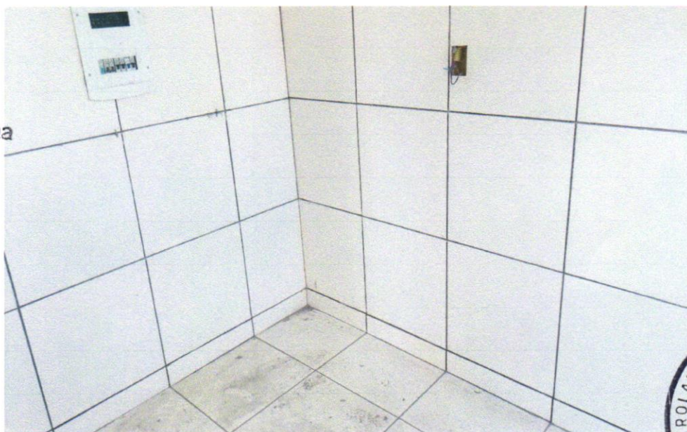
FOTO 28 - REVESTIMENTO CERÂMICO PARA PAREDES INTERNAS COM PLACAS TIPO ESMALTADA EXTRA DE DIMENSÕES 33X45 CM APLICADAS EM AMBIENTES DE ÁREA MAIOR QUE 5 M² A MEIA ALTURA DAS PAREDES. AF_06/2014
