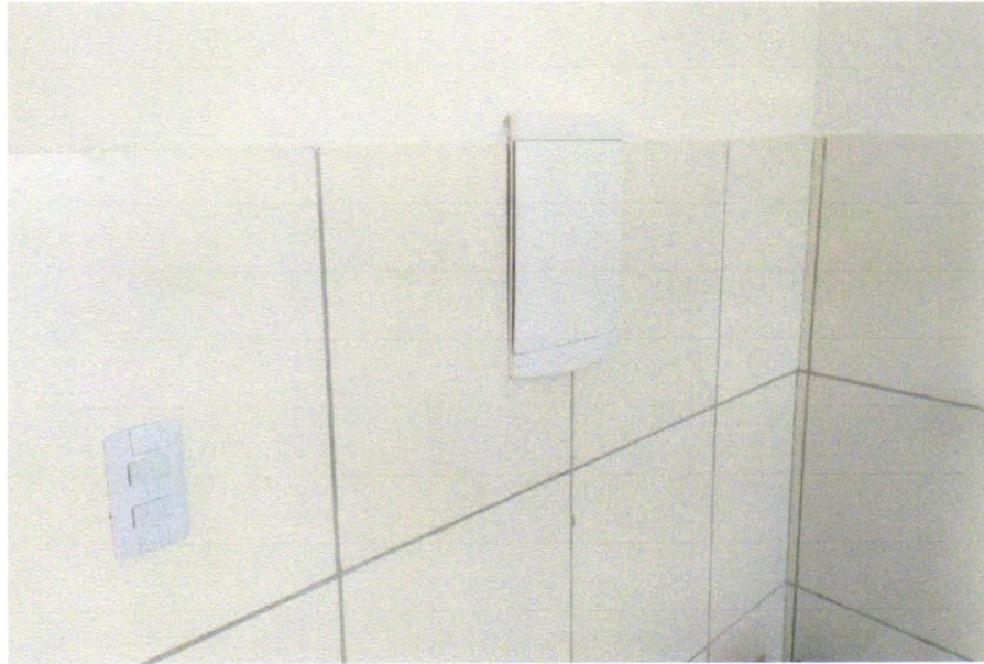
Foto 11 - Quadro de distribuição de embutir, em resina termoplástica, para até 32 disjuntores, SLIM, com barramento, padrão DIN, exclusive disjuntores
