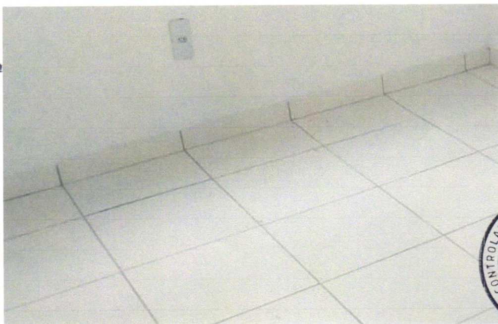
FOTO 16 - TOMADA BAIXA DE EMBUTIR (1 MÓDULO), 2P+T 10 A, INCLUINDO SUPORTE E PLACA - FORNECIMENTO E INSTALAÇÃO. AF_12/2015
