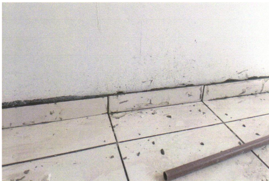
FOTO 31 - RODAPÉ CERÂMICO DE 7CM DE ALTURA COM PLACAS TIPO ESMALTADA COMERCIAL DE DIMENSÕES 35X35CM (PADRAO POPULAR). AF_06/2017
