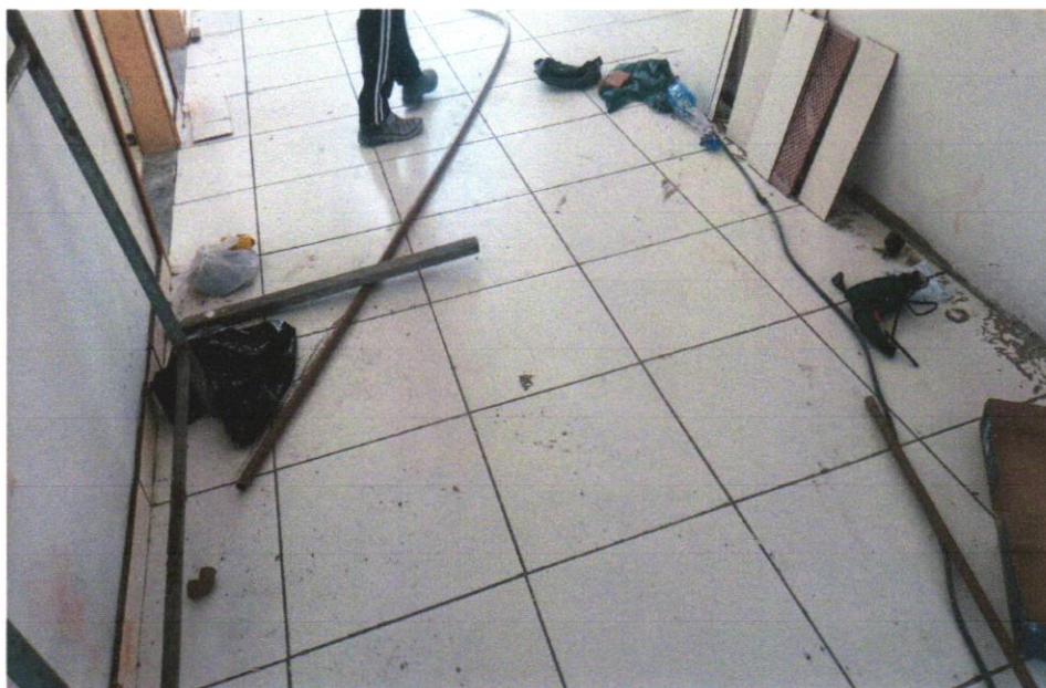
FOTO 27 - REVESTIMENTO CERÂMICO PARA PISO COM PLACAS TIPO ESMALTADA EXTRA DE DIMENSÕES 45X45 CM APLICADA EM AMBIENTES DE ÁREA ENTRE 5 M2 E 10 M2. AF_06/2014
