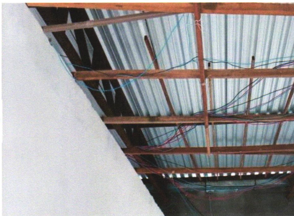
FOTO 05 - CABO DE COBRE FLEXÍVEL ISOLADO, 4 MM 2 , ANTI-CHAMA 450/750 V, PARA CIRCUITOS TERMINAIS - FORNECIMENTO E INSTALAÇÃO. AF_12/2015
