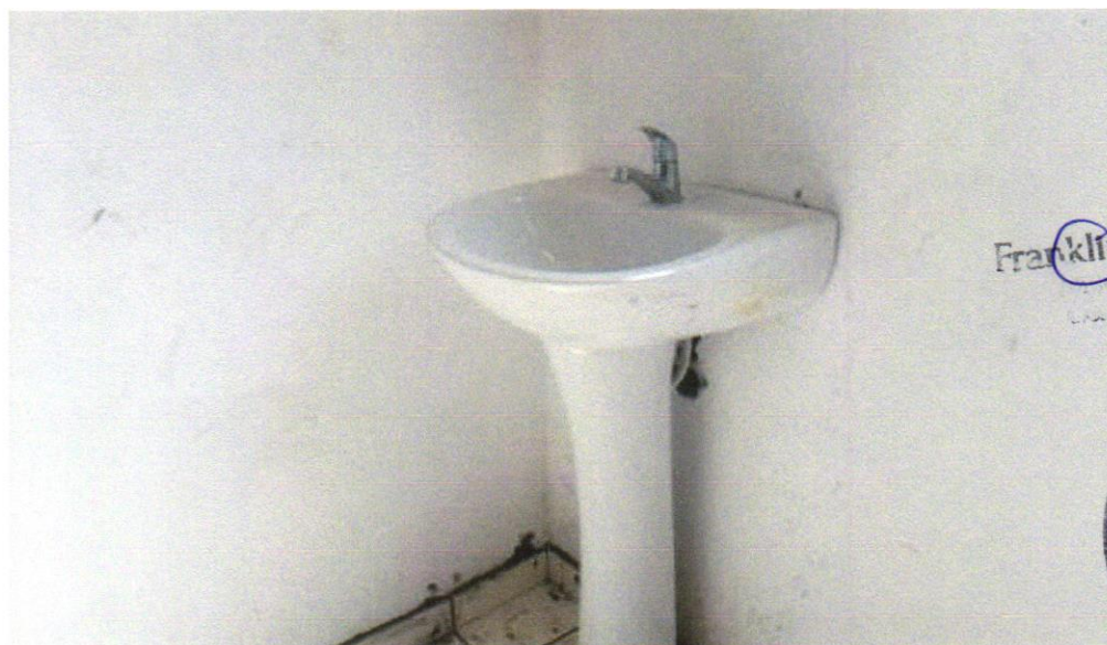
FOTO 16 - LAVATÓRIO LOUÇA BRANCA COM COLUNA, *44 X 35,5* CM, PADRÃO POPULAR, INCLUSO SIFÃO FLEXÍVEL EM PVC, VÁLVULA E ENGATE FLEXÍVEL 30CM EM PLÁSTICO E COM TORNEIRA CROMADA PADRÃO POPULAR - FORNECIMENTO E INSTALAÇÃO. AF_01/2020
