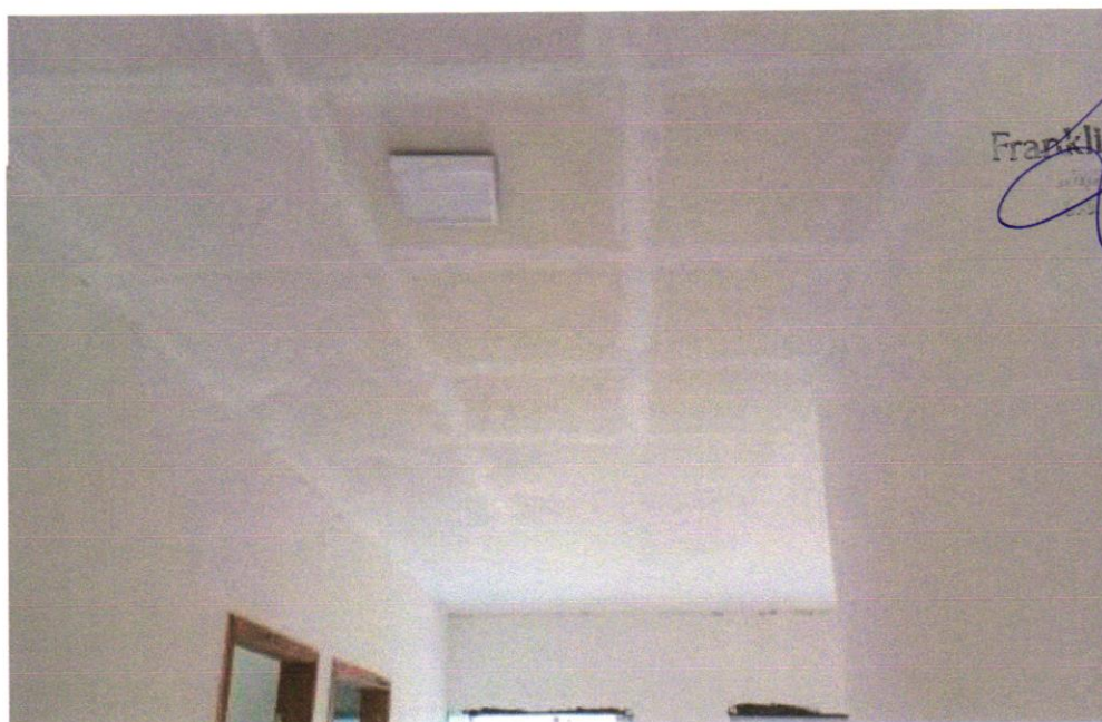
FOTO 10 - Luminária sobrepôr quadrada Led 24W*, 6500K G- Light ou similar
