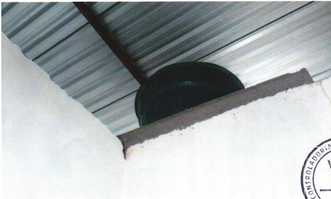
FOTO 12 - CAIXA D'ÁGUA EM POLIETILENO, 500 LITROS - FORNECIMENTO E INSTALAÇÃO. AF_06/2021
