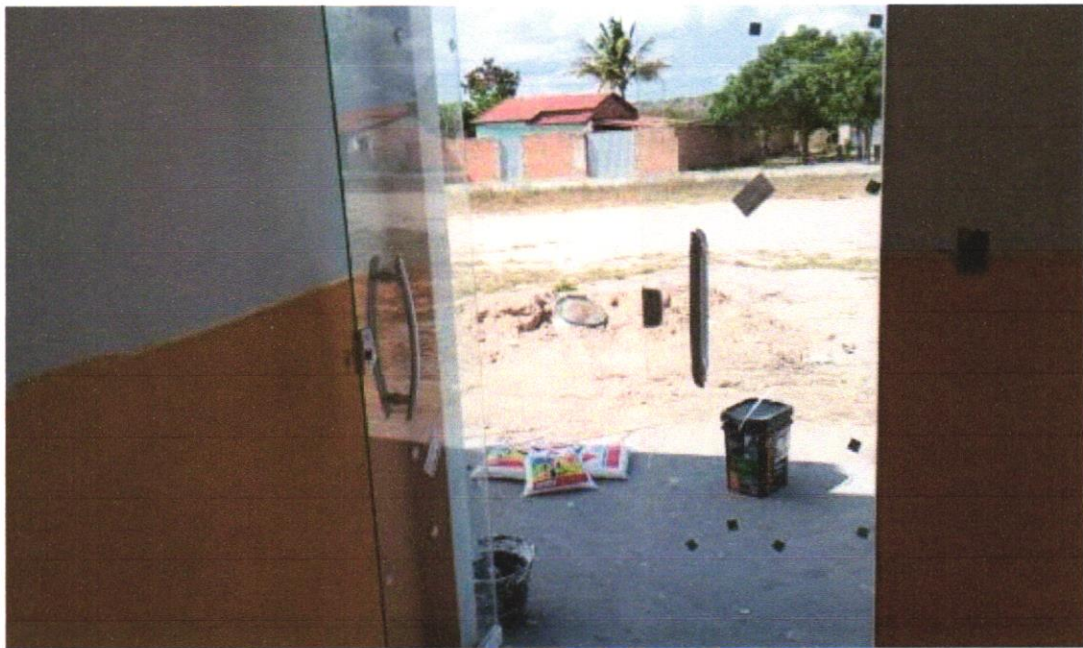
FOTO 28 - Porta em vidro temperado 10mm, incolor, inclusive ferragens de fixação e instalação, exclusive puxador - Rev 01_10/2021
