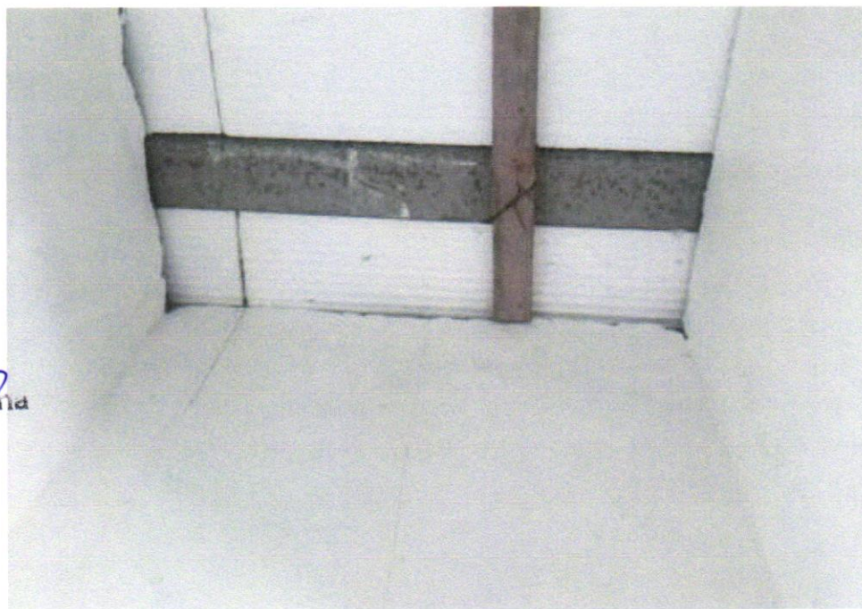
FOTO 01 – Laje pré-fabricada treliçada para piso ou cobertura, intereixo 38cm, h=12cm, el. enchimento em EPS h=8cm, inclusive escoramento em madeira e capeamento 4cm.
