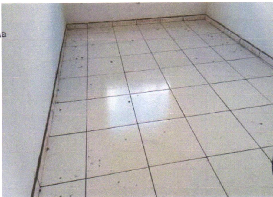
FOTO 20 - REVESTIMENTO CERÂMICO PARA PISO COM PLACAS TIPO ESMALTADA EXTRA DE DIMENSÕES 45X45 CM APLICADA EM AMBIENTES DE ÁREA ENTRE 5 M2 E 10 M2.
