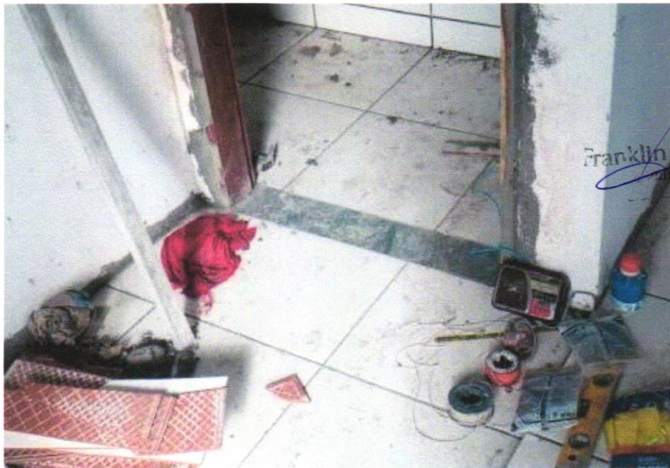
FOTO 24 - SOLEIRA EM GRANITO, LARGURA 15 CM, ESPESSURA 2,0 CM. AF_09/2020
