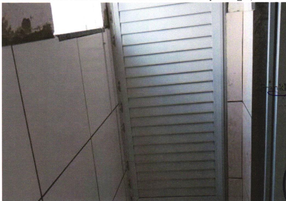
FOTO 26 - PORTA EM ALUMÍNIO DE ABRIR TIPO VENEZIANA COM GUARNIÇÃO, FIXAÇÃO COM PARAFUSOS
