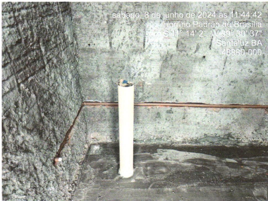
Foto 08 - CONEXÕES PARA ÁGUA FRIA
