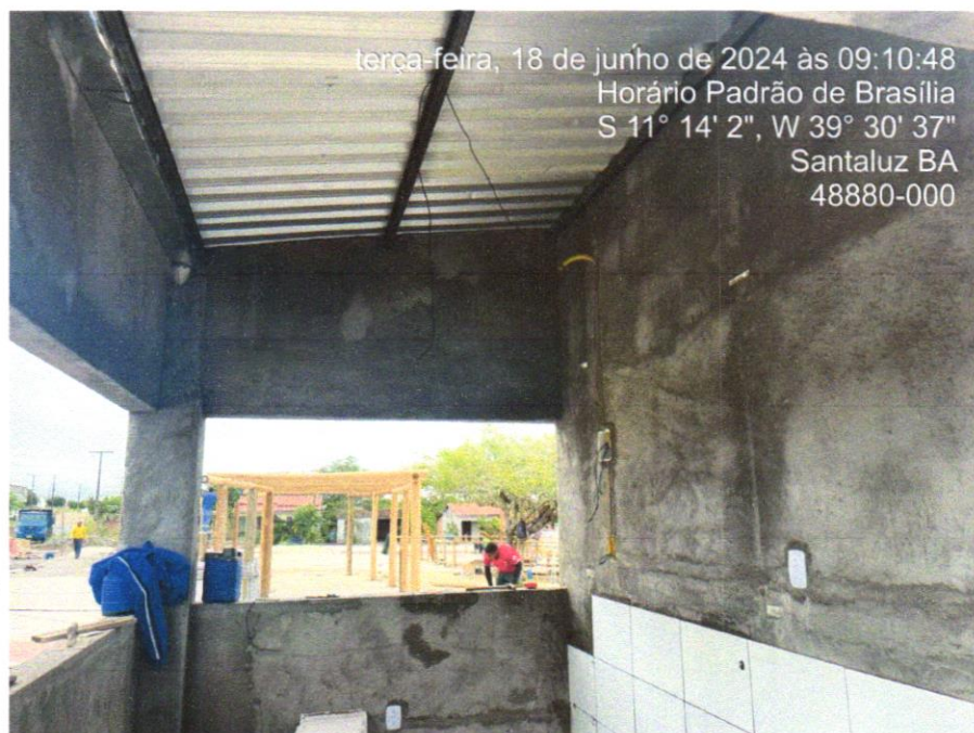
Foto 14 - Estrutura Metálica p/ Cobertura c/Vigas-Treliça Pratt UDC75 e terças em UDC 127, 2 águas, sem lanternim, vãos 6,0 a 10,0m, pintado 1 d oxido ferro + 2 d esmalte epóxi branco, exceto forn. Telhas - Executada
