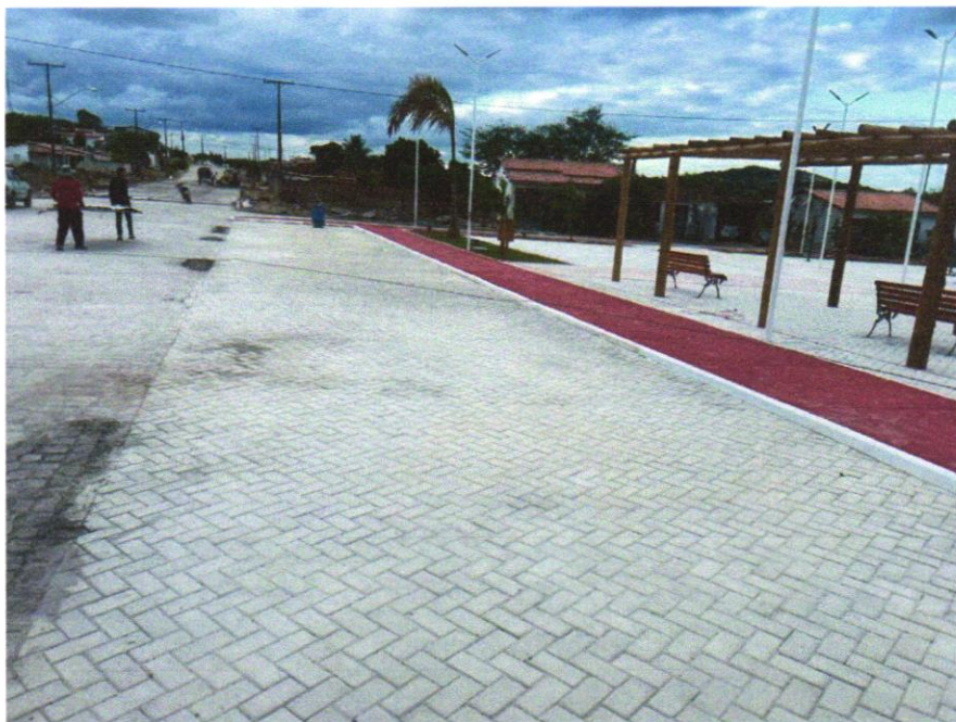
Foto 22 - Pintura p/ piso c/ aplicação de 2 demãos tinta novacor, cores cerâmica, concreto, verde ou azul - aplicação c/ rôlo - R1
