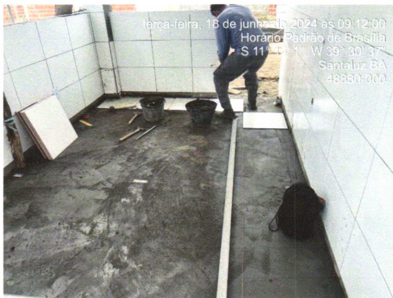
Foto 04 - REVESTIMENTO CERÂMICO PARA PISO COM PLACAS TIPO ESMALTADA EXTRA DE DIMENSÕES 35X35 CM APLICADA EM AMBIENTES DE ÁREA ENTRE 5 M2 E 10 M2. AF_06/2014
