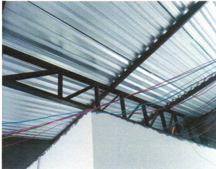
Foto 15 CABO DE COBRE FLEXÍVEL ISOLADO, 4 MM 2 , ANTI-CHAMA 450/750 V, PARA CIRCUITOS TERMINAIS - FORNECIMENTO E INSTALAÇÃO. AF_12/2015
