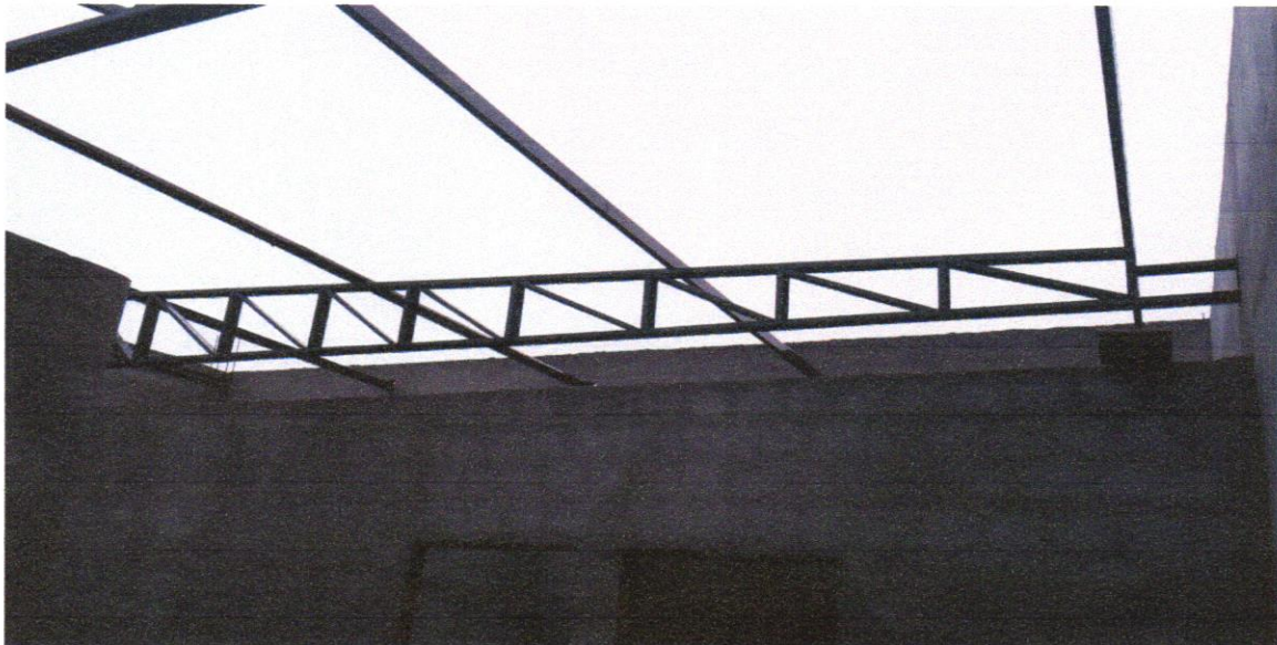
FOTO 06 – TRAMA DE AÇO COMPOSTA POR TERÇAS PARA TELHADOS DE ATÉ 2 ÁGUAS PARA TELHA ONDULADA DE FIBROCIMENTO, METÁLICA, PLÁSTICA OU TERMOACÚSTICA, INCLUSO TRANSPORTE VERTICAL. AF_07/2019
