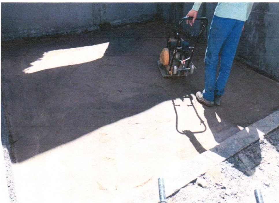
FOTO 26 - Regularização mecanizada de áreas
