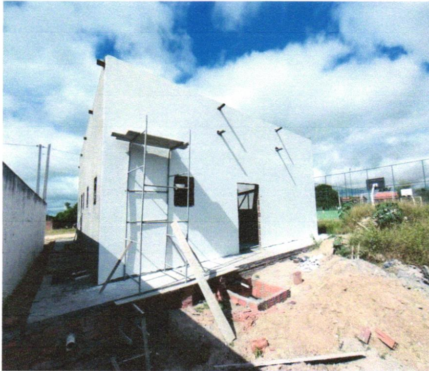
Foto 23 - APLICAÇÃO E LIXAMENTO DE MASSA LÁTEX EM PAREDES, UMA DEMÃO. AF_06/2014
