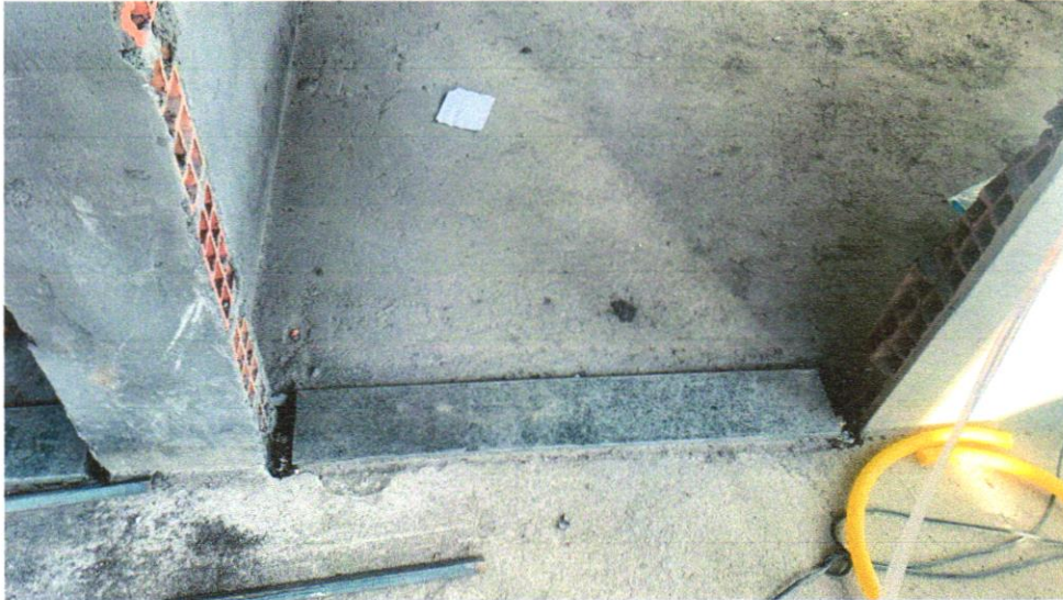
FOTO 01 – SOLEIRA EM GRANITO, LARGURA 15 CM, ESPESSURA 2,0 CM. AF_09/2020
