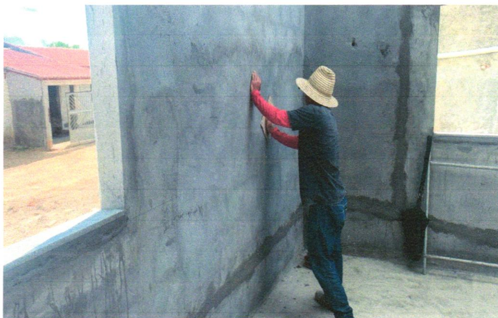
Foto 12 - Preparo de superfície com lixamento de paredes e tetos
