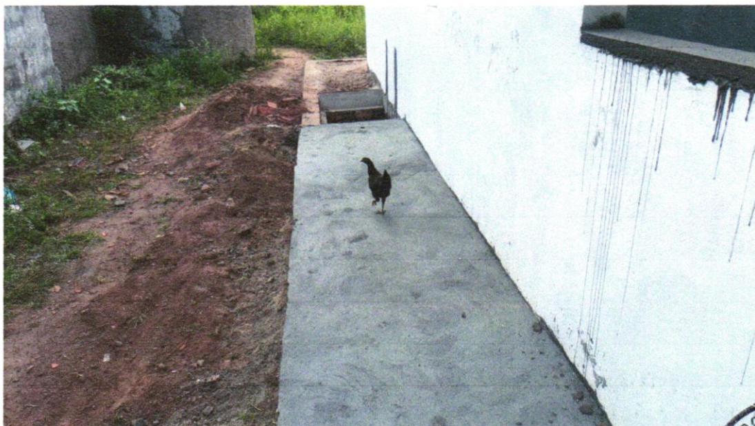
FOTO 04 - EXECUÇÃO DE PASSEIO (CALÇADA) OU PISO DE CONCRETO COM CONCRETO MOLDADO IN LOCO, USINADO, ACABAMENTO CONVENCIONAL,
