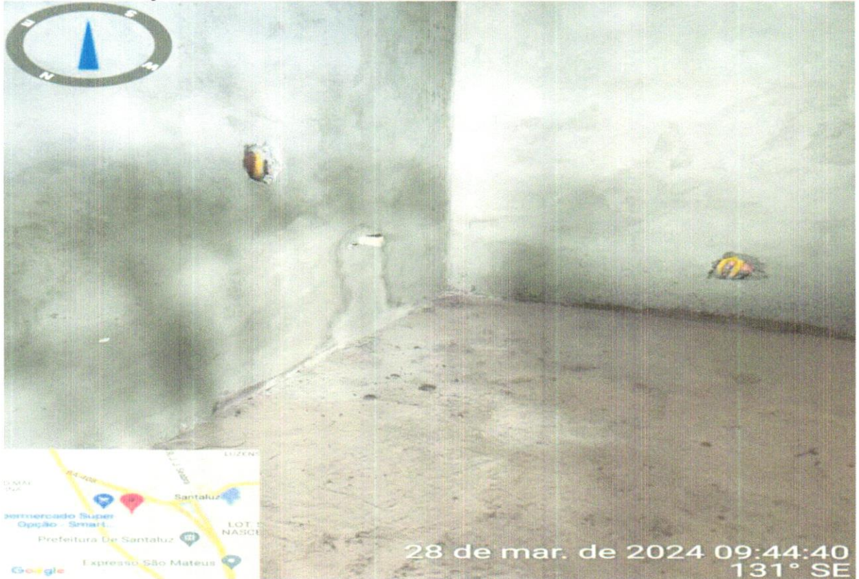
FOTO 07 – EXECUÇÃO DE CONTRAPISO E PASSAGEM DE ELETRODUTO E REDE HIDROSSANITÁRIA
