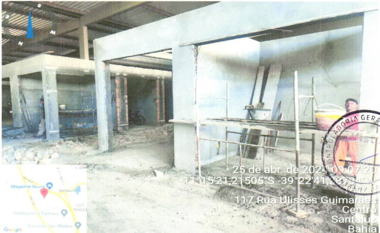
FOTO 22 – ACABAMENTO DO REBOCO DAS PORTAS
