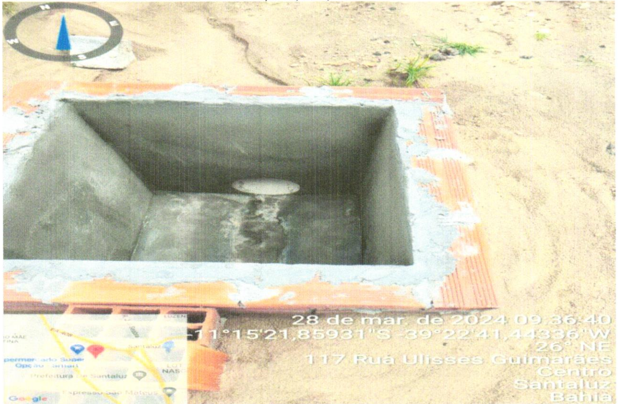
FOTO 20 - EXECUÇÃO DA ALVENARIA DO BANCO
