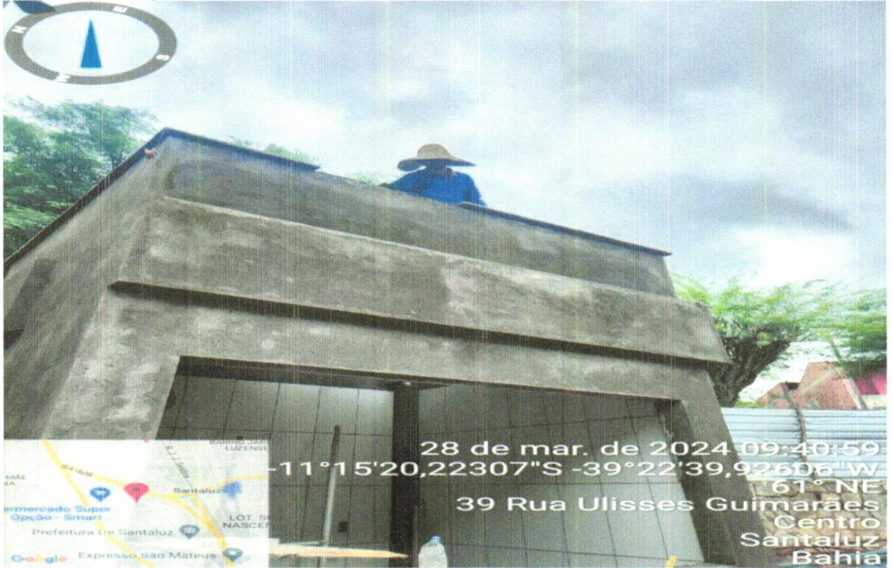
FOTO 16 - EXECUÇÃO DE CAIXA DE GORDURA
