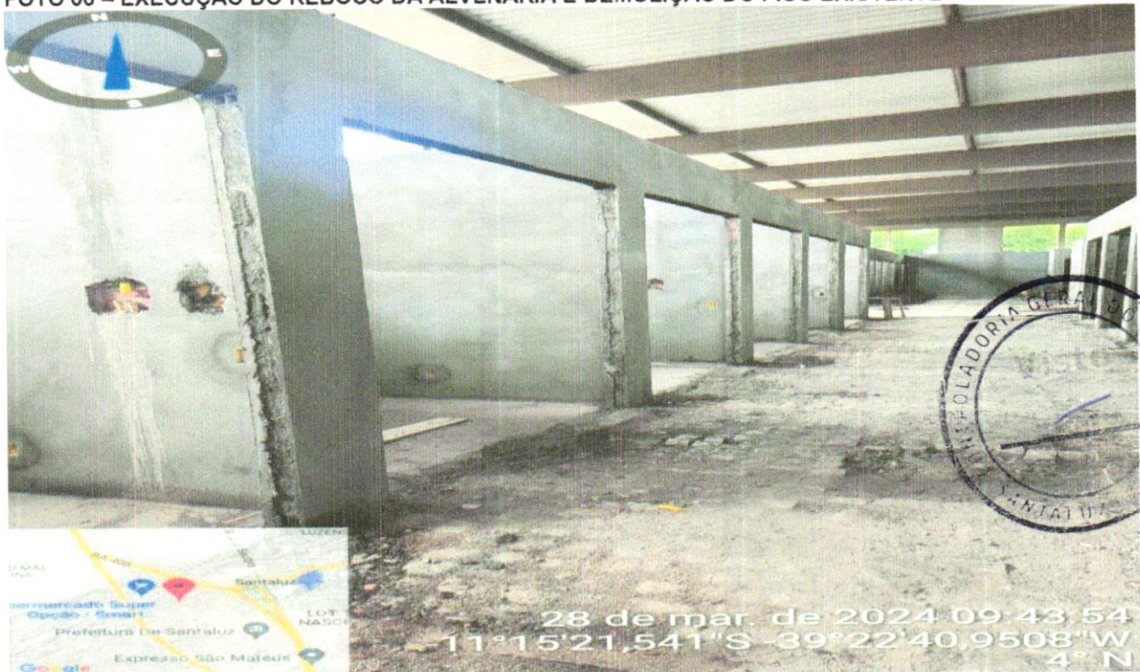
FOTO 06 – EXECUÇÃO DO REBOCO DA ALVENARIA E DEMOLIÇÃO DO PISO EXISTENTE
