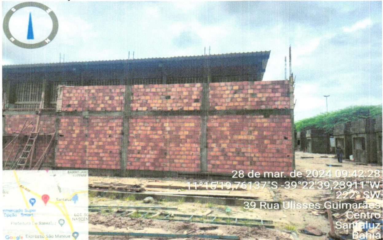
FOTO 02 – EXECUÇÃO DE CHAPISCO E RESTAURAÇÃO DE VIGAS
