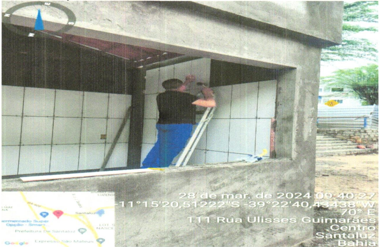
FOTO 14 – EXECUÇÃO DO REVESTIMENTO
