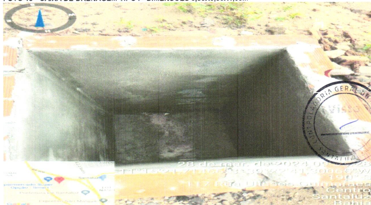
FOTO 18 - CAIXA DE DRENAGEM TIPO I - DIMENSÕES 0,80X0,80X1,00M
