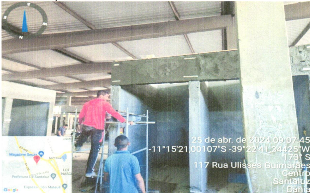
FOTO 24 – EXECUÇÃO DE REBOCO
