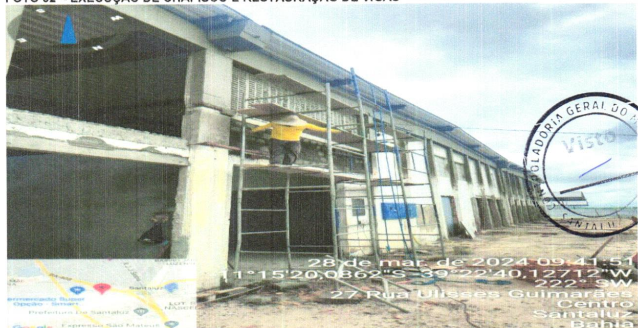
FOTO 02 – EXECUÇÃO DE CHAPISCO E RESTAURAÇÃO DE VIGAS
