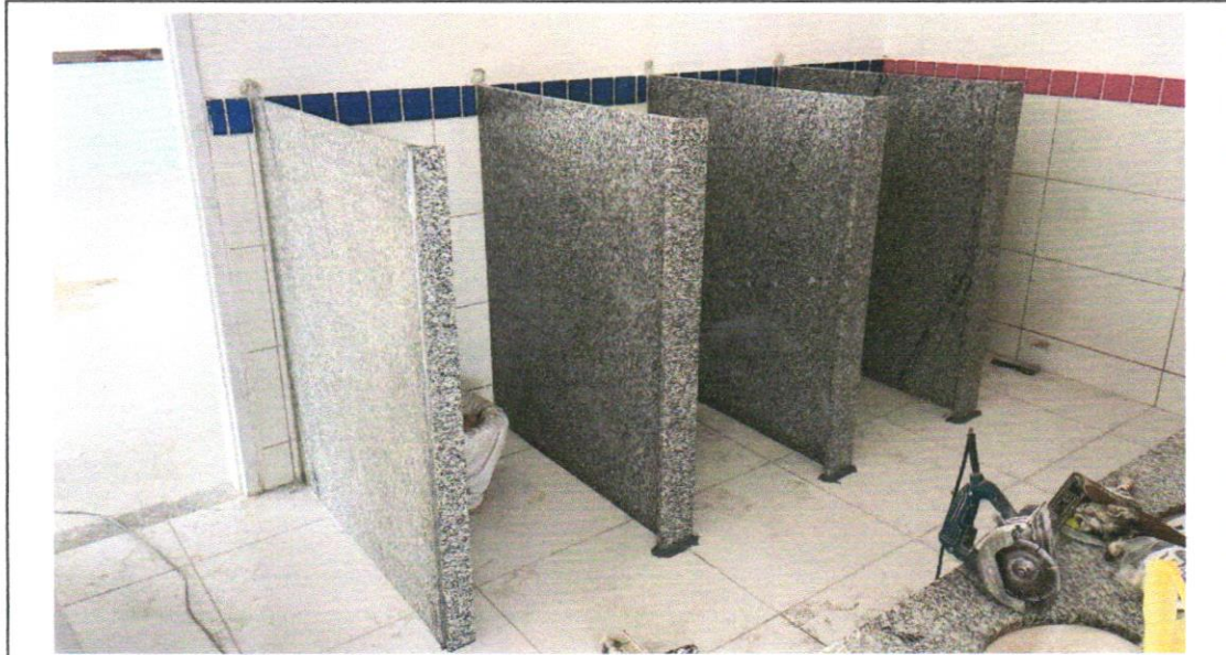
FOTO 248: DIVISÓRIAS DE GRANITO
