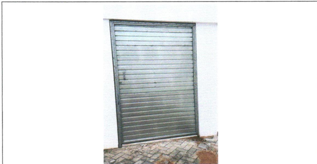
FOTO 249: PORTAS DE ALUMÍNIO
