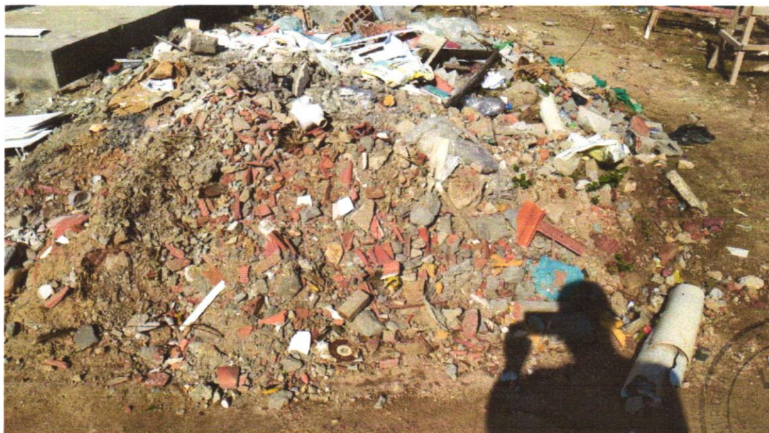
Foto 30 - DEMOLIÇÃO DE ALVENARIA DE BLOCO FURADO, DE FORMA MANUAL, SEM REAPROVEITAMENTO. AF_12/2017
