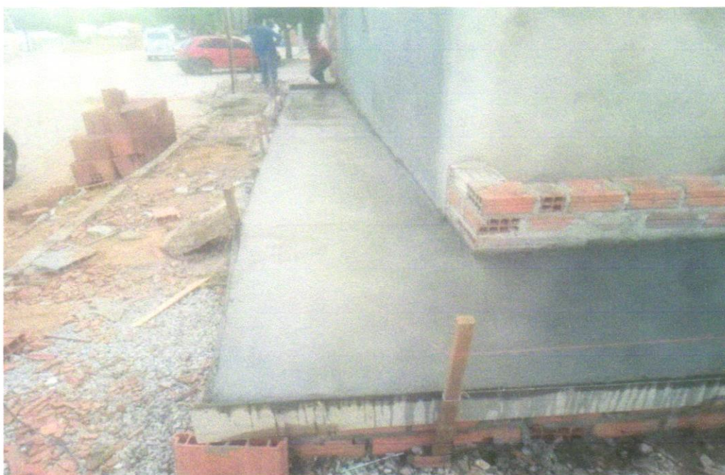
FOTO 21 – EXECUÇÃO DE PASSEIO (CALÇADA) OU PISO DE CONCRETO COM CONCRETO MOLDADO IN LOCO, FEITO EM OBRA, ACABAMENTO CONVENCIONAL, ESPESSURA 8 CM, ARMADO. AF_07/2016
