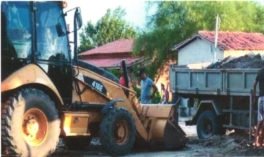
FOTO 27 - transporte com caminhão basculante
