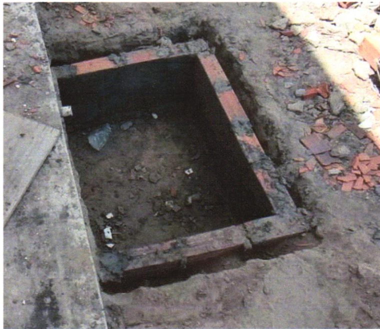
FOTO 9 - Sumidouro paredes com blocos cerâmicos 6 furos e dimensões internas de 1,00 x 1,00 x 0,60 m
