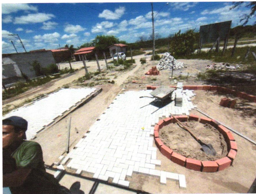
FOTO 06-EXECUÇÃO DE PASSEIO EM PISOINTERTRAVADO
