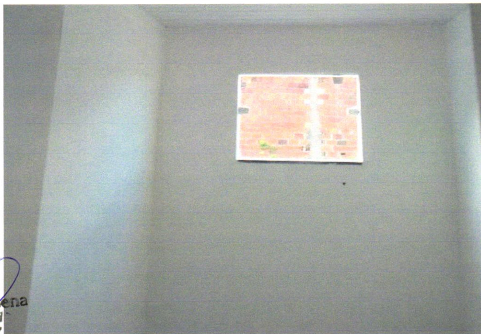
FOTO 24 - JANELA DE ALUMÍNIO TIPO MAXIM-AR, COM VIDROS, BATENTE E FERRAGENS. EXCLUSIVE ALIZAR, ACABAMENTO E CONTRAMARCO. FORNECIMENTO E INSTALAÇÃO. AF_12/2019
