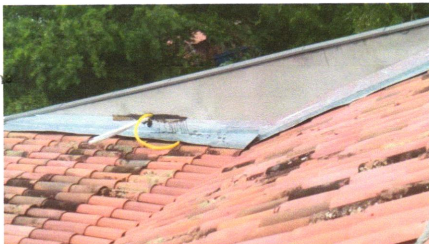
FOTO 12 – FIO COBRE FLEXÍVEL, DN 3/8, COM ISOLAMENTO, INSTALADO EM RAMAL DE ALIMENTAÇÃO DE AR CONDICIONADO COM CONDENSADORA INDIVIDUAL FORNECIMENTO E INSTALAÇÃO. AF_12/2014.
