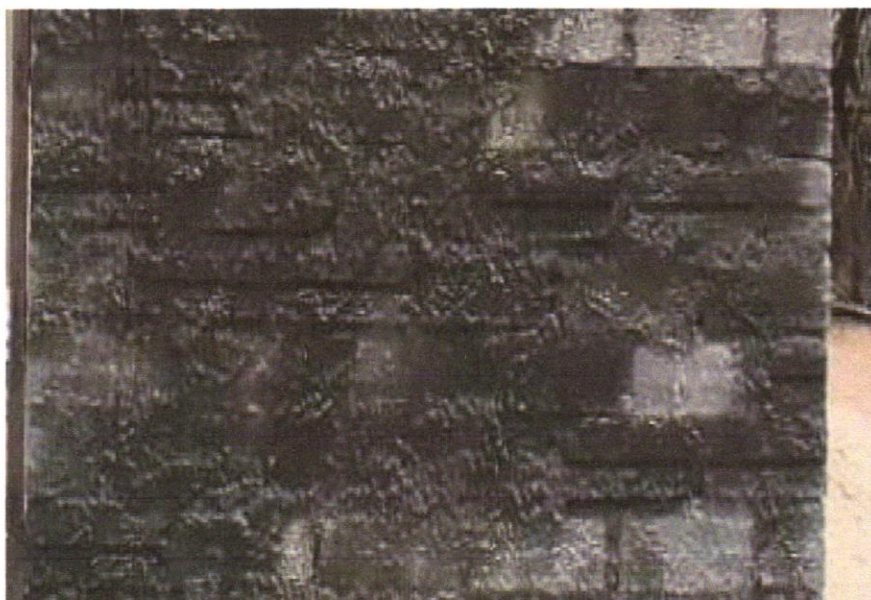
FOTO 28 - CHAPISCO APLICADO EM ALVENARIAS E ESTRUTURAS DE CONCRETO INTERNAS, COM COLHER DE PEDREIRO. ARGAMASSA TRAÇO 1:3 COM PREPARO EM BETONEIRA 400L. AF_06/2014
