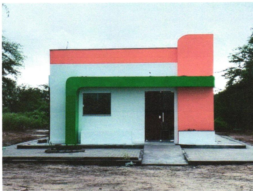
FOTO 02– APLICAÇÃO MANUAL DE PINTURA COM TINTA LÁTEX ACRÍLICA EM PAREDES, DUAS DEMÃOS. AF_06/2014
