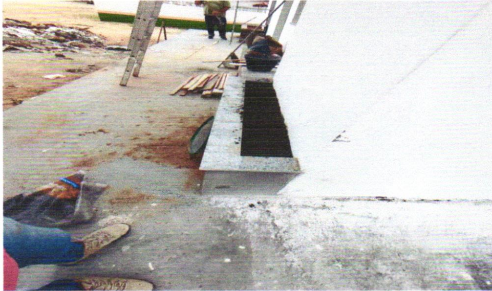
FOTO 05 – PEITORIL LINEAR EM GRANITO OU MÁRMORE, L = 15CM, COMPRIMENTO DE ATÉ 2M, ASSENTADO COM ARGAMASSA 1:6 COM ADITIVO. AF_11/2020
