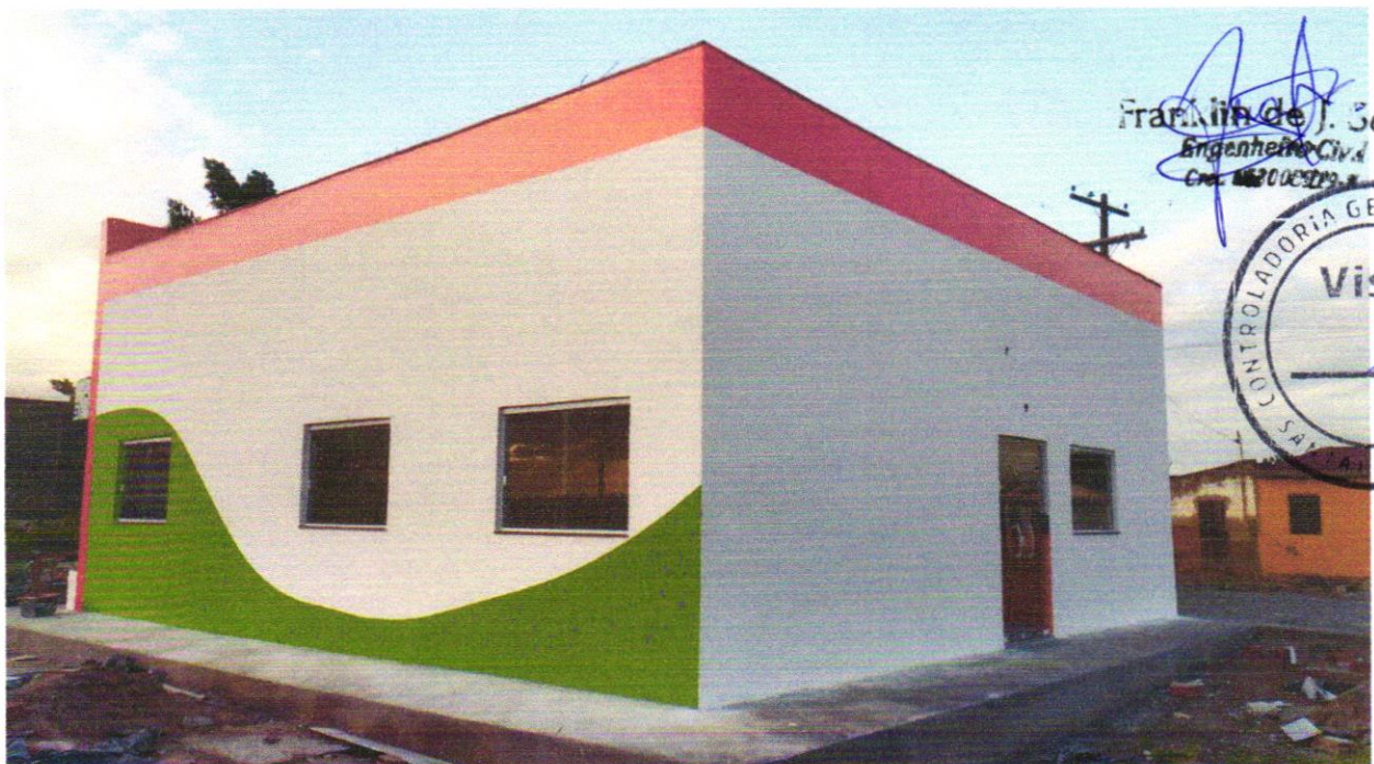
FOTO 04 - APLICAÇÃO MANUAL DE PINTURA COM TINTA LÁTEX ACRÍLICA EM PAREDES, DUAS DEMÃOS. AF_06/2014
