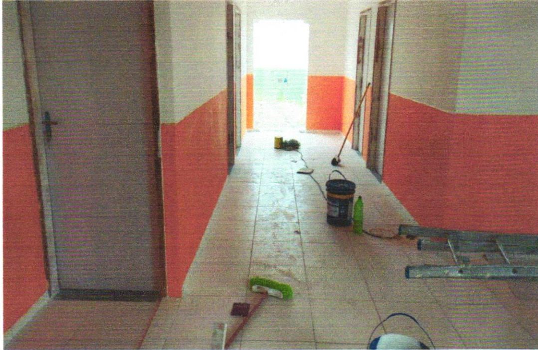
FOTO 9 - APLICAÇÃO MANUAL DE PINTURA COM TINTA LÁTEX ACRÍLICA EM PAREDES, DUAS DEMÃOS. AF_06/2014
