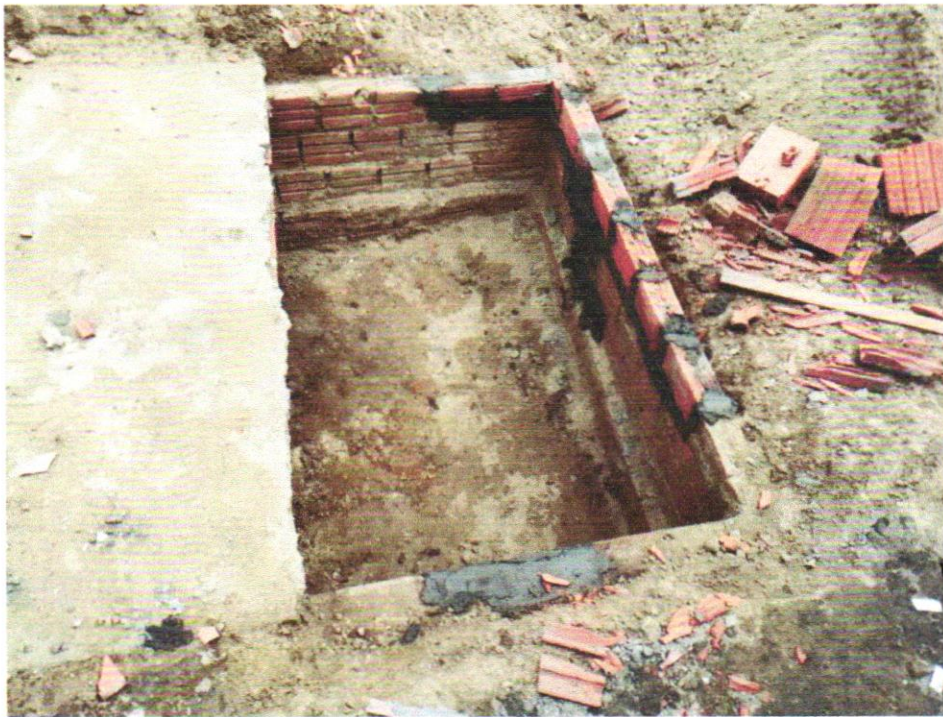
Foto 19 – Fossa séptica pré-moldada, tipo oms, capacidade 15 pessoas (v=900 litros)
