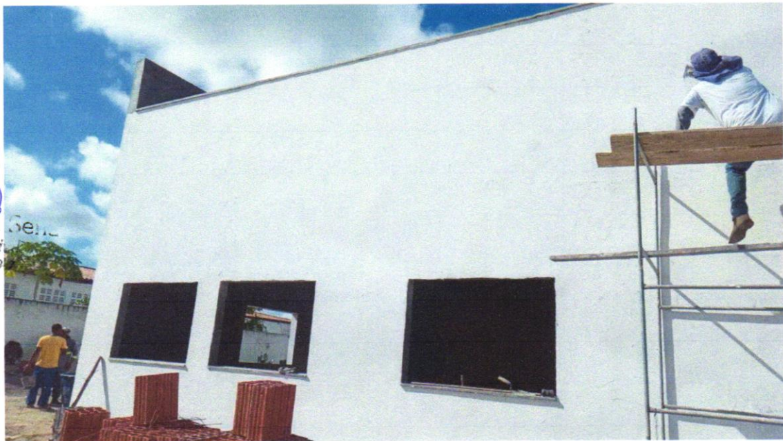
Foto 04 – APLICAÇÃO E LIXAMENTO DE MASSA LÁTEX EM PAREDES, UMA DEMÃO. AF 06/2014
