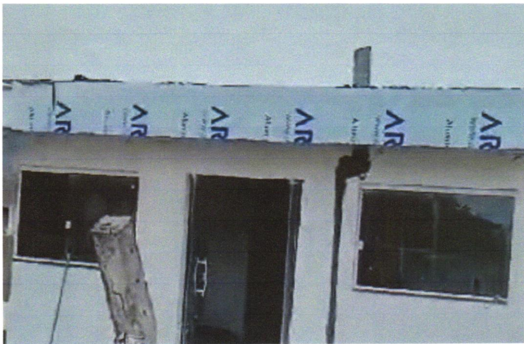
FOTO 29 - Revestimento metálico em alumínio composto (Alucobond), e=0,3mm, pintura Kaynar 500 composta por seis camadas, inclusive estrutura metálica auxiliar em perfil de viga "U" de 2" - fornecimento e montagem
