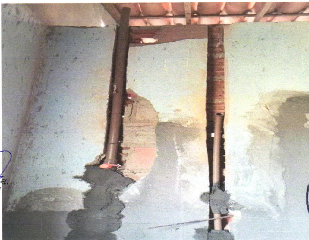
FOTO 14 – TUBO, PVC, SOLDÁVEL, DN 25MM, INSTALADO EM RAMAL OU SUB-RAMAL DE ÁGUA - FORNECIMENTO E INSTALAÇÃO. AF_06/2022
