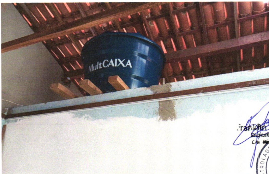
Foto 20 - CAIXA D'ÁGUA EM POLIÉSTER REFORÇADO COM FIBRA DE VIDRO, 500 LITROS - FORNECIMENTO E INSTALAÇÃO. AF_06/2021
