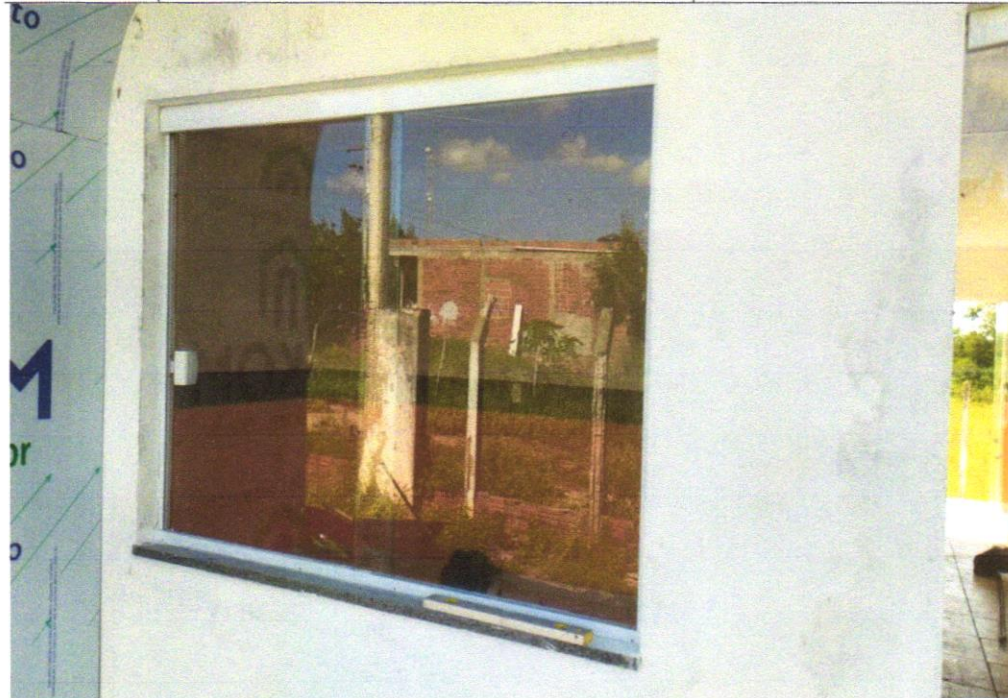
Foto 27- PEITORIL LINEAR EM GRANITO OU MÁRMORE, L = 15CM, COMPRIMENTO DE ATÉ 2M, ASSENTADO COM ARGAMASSA 1:6 COM ADITIVO. AF_11/2020
