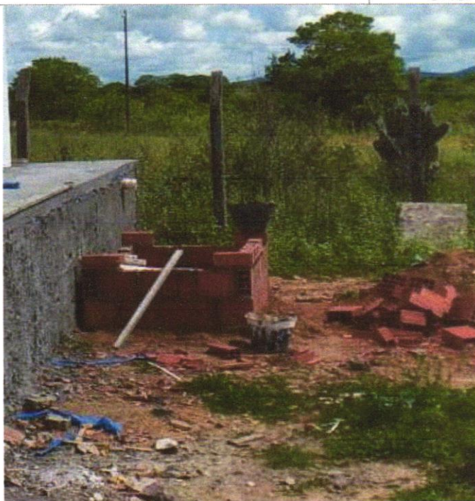
Foto 23 – FILTRO ANAERÓBIO
