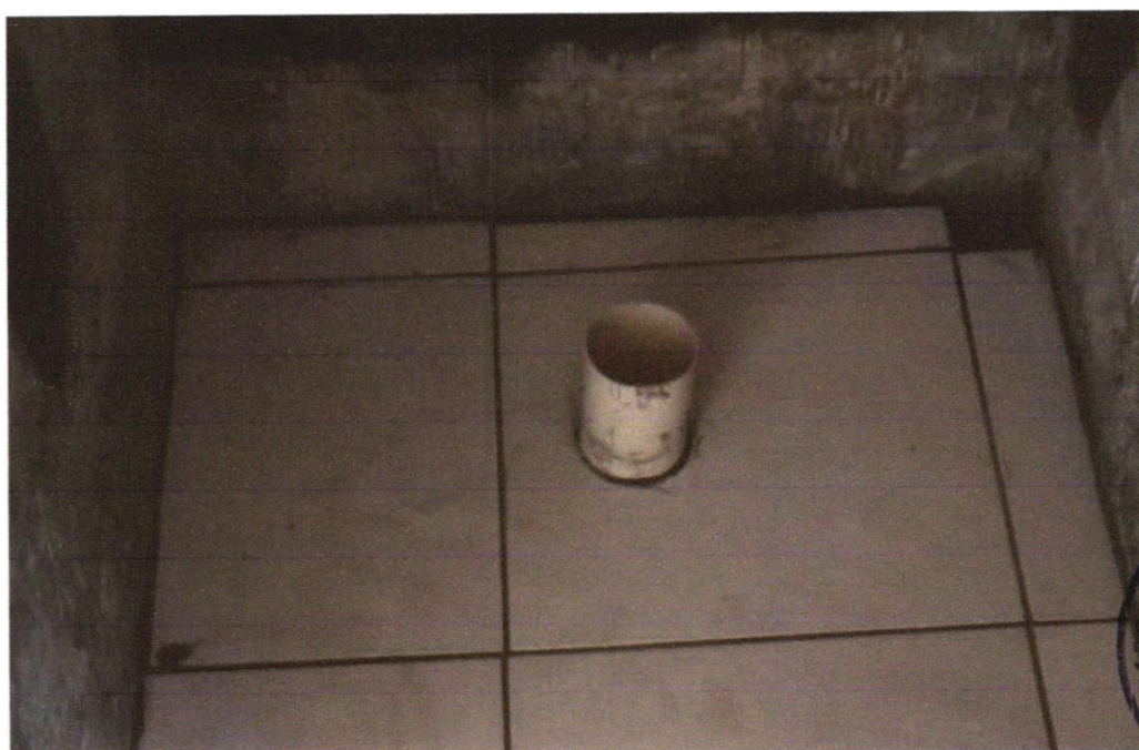
FOTO 18 – TUBO DE PVC BRANCO PARA REDE COLETORA DE ESGOTO CONDOMINIAL DE PAREDE MACIÇA, DN 100 MM, JUNTA ELÁSTICA - FORNECIMENTO E ASSENTAMENTO. AF 01/2021
