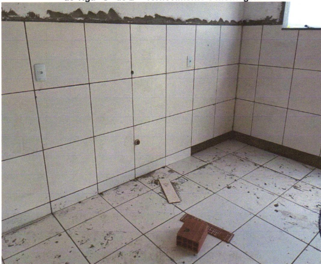
Foto 26 – REVESTIMENTO CERÂMICO PARA PISO COM PLACAS TIPO ESMALTADA EXTRA DE DIMENSÕES 45X45 CM APLICADA EM AMBIENTES DE ÁREA MAIOR QUE 10 M2. AF_06/2014
