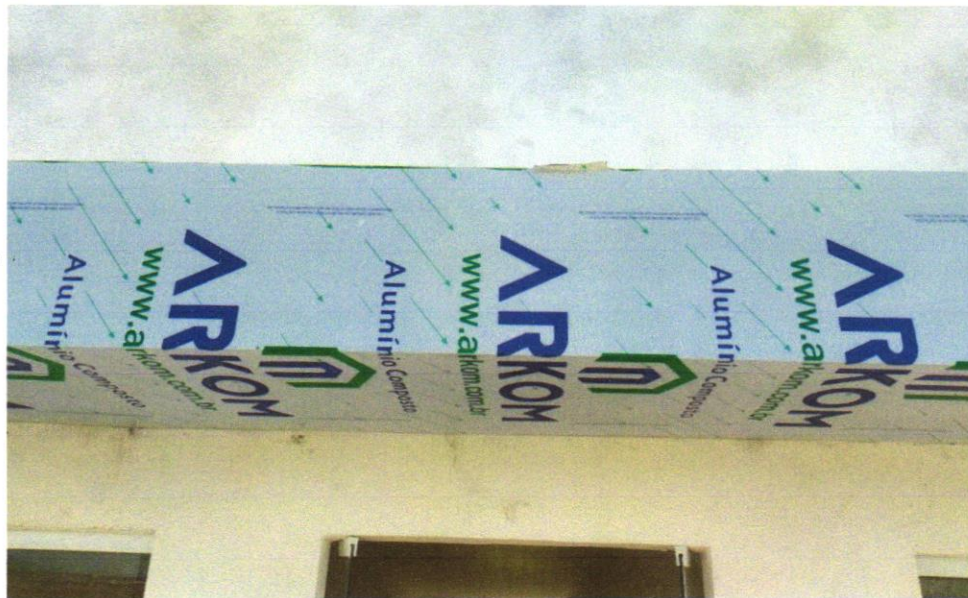
Foto 25 -Revestimento metálico em alumínio composto (Alucobond), e=0,3mm, pintura Kaynar 500 composta por seis camadas, inclusive estrutura metálica auxiliar em perfil de viga "U" de 2" - fornecimento e montagem
