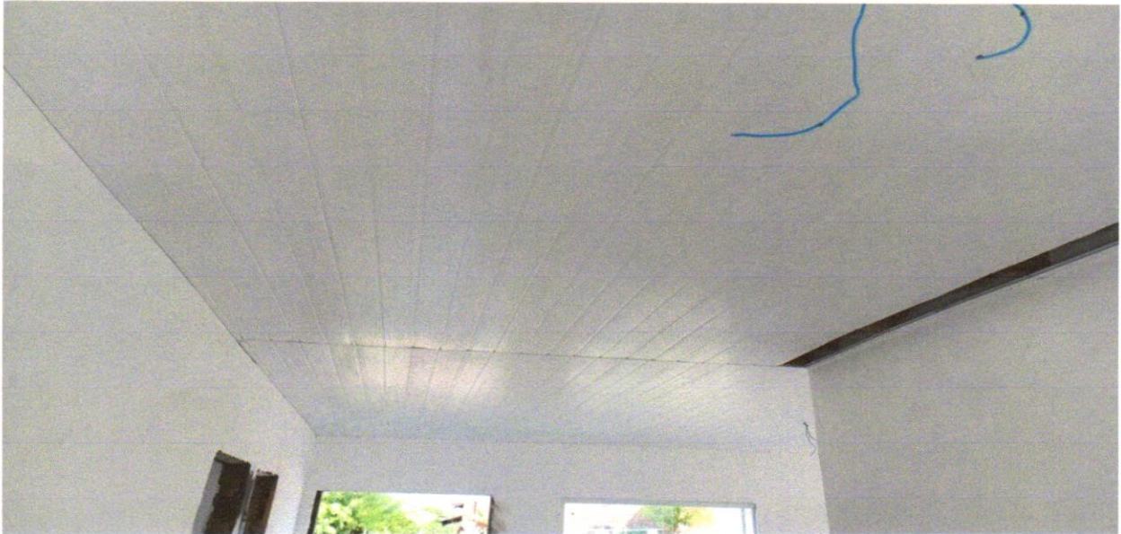
Foto 7 – Forro de pvc, em régua de 10 ou 20 cm, aplicado, inclusive estrutura para fixação (perfis em PVC) marca Araforros ou similar, instalado - Rev 06_10/2021
