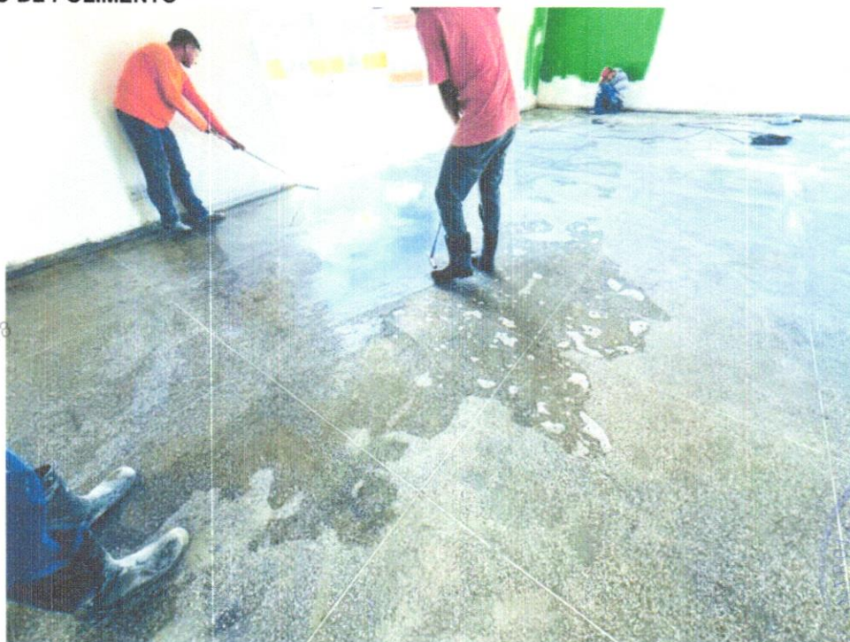
FOTO 28 – APLICAÇÃO DE PISO ALTA RESISTÊNCIA, COR CINZA, APLICADO COM JUNTAS E COM APLICAÇÃO DE POLIMENTO
