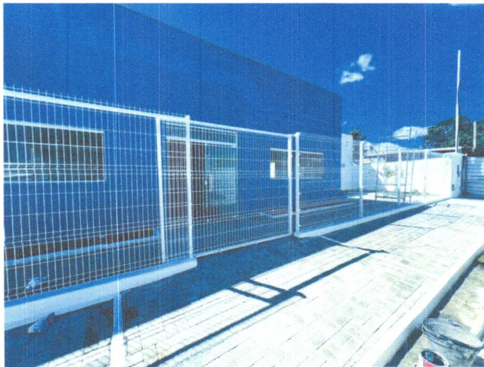
FOTO 12 – INSTALAÇÃO GRADIL TIPO MORLAN
