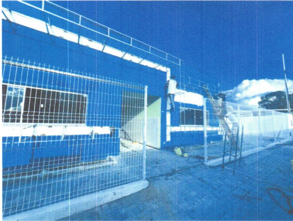
FOTO 16 – TELHAMENTO COM TELHA METÁLICA TERMOACÚSTICA
