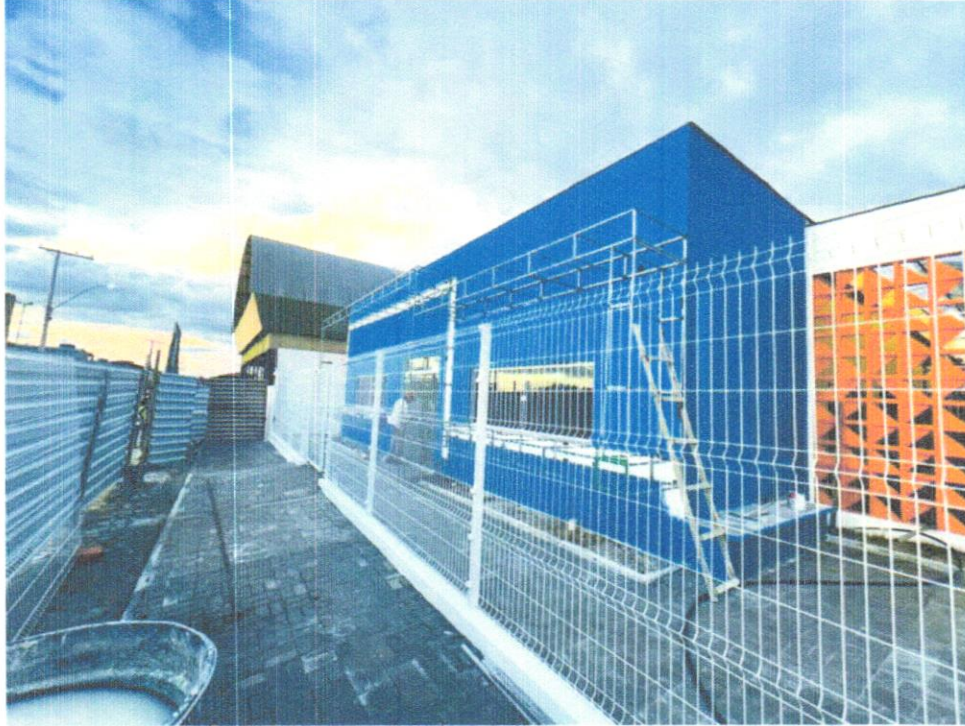
FOTO 13 – INSTALAÇÃO DE GRADIL TIPO MORLAN
