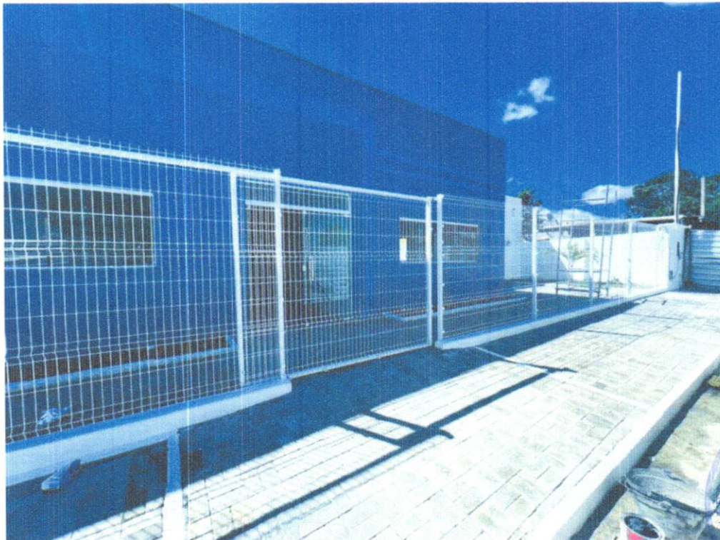
FOTO 14 – INSTALAÇÃO PORTÃO PARA GRADIL DO TIPO MORLAN
