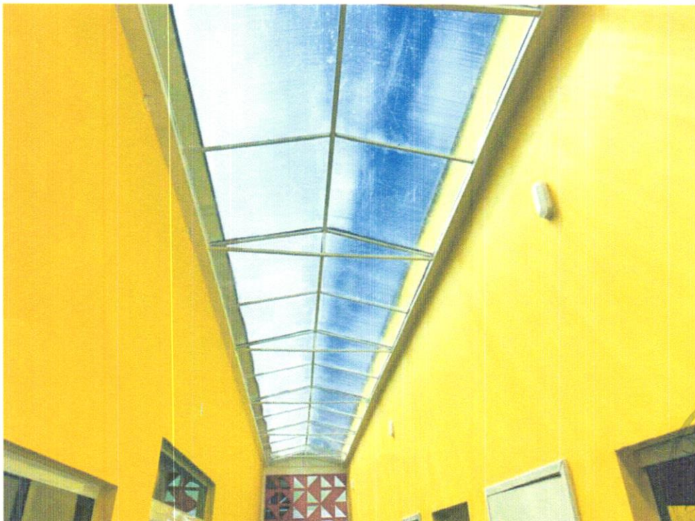
FOTO 22- INSTALAÇÃO DE CHAPAS DE POLICARBONATO
