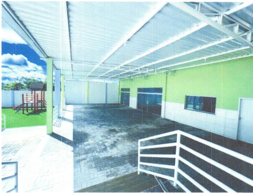
FOTO 18 – INSTALAÇÃO DE CHAPAS DE POLICARBONATO
