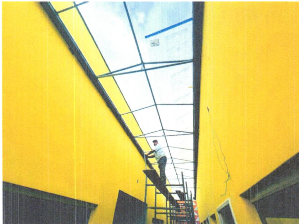
FOTO 18 – INSTALAÇÃO DE CHAPAS DE POLICARBONATO
