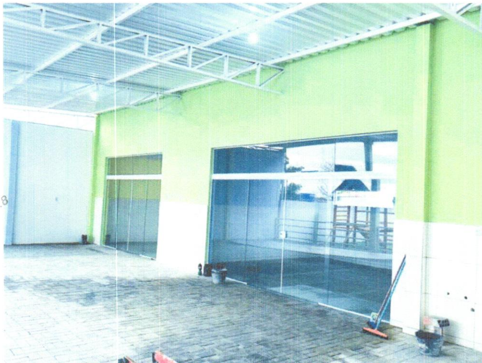
FOTO 16 – TELHAMENTO COM TELHA METÁLICA TERMOACÚSTICA
