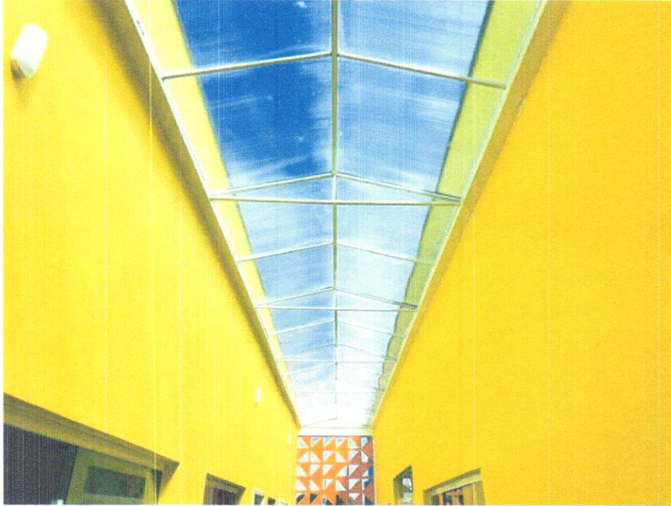
FOTO 22- INSTALAÇÃO DE CHAPAS DE POLICARBONATO
