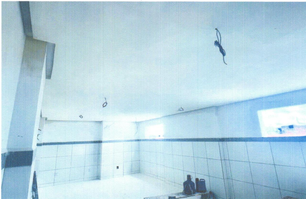
FOTO 25 - EMASSAMENTO COM MASSA A OLEO, DUAS DEMAOS
