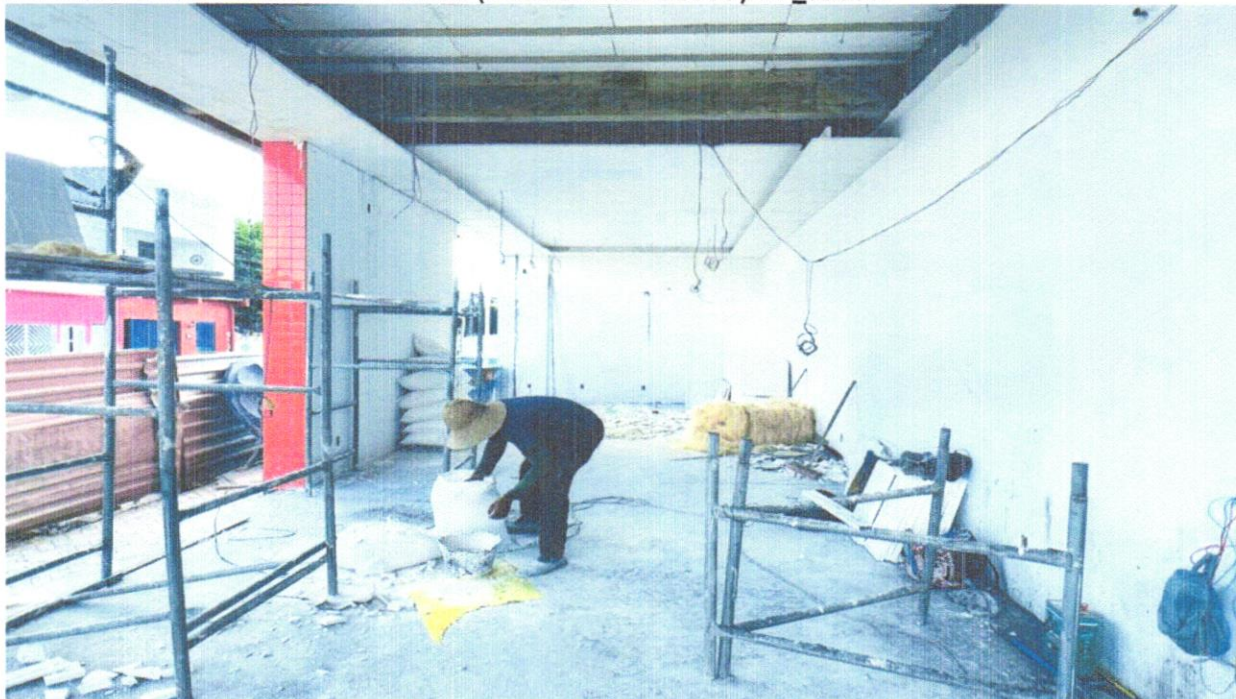
FOTO 16 - ACABAMENTOS PARA FORRO (MOLDURA DE GESSO). AF_05/2017
