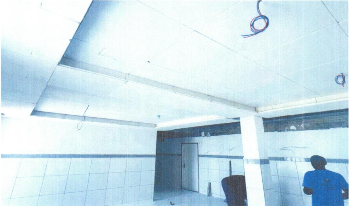
FOTO 18 - ACABAMENTOS PARA FORRO (MOLDURA DE GESSO). AF_05/2017
