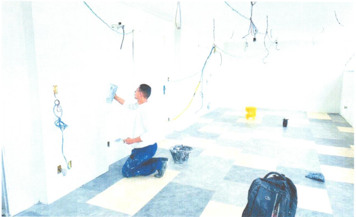
FOTO 24 - EMASSAMENTO COM MASSA A OLEO, DUAS DEMAS
