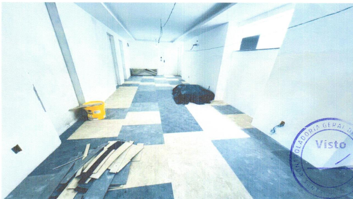
FOTO 26 - EMASSAMENTO COM MASSA A OLEO, DUAS DEMAOS
