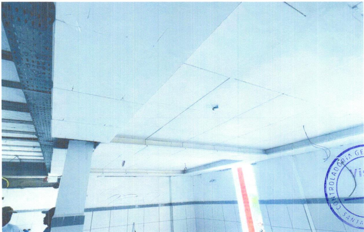
FOTO 18 - ACABAMENTOS PARA FORRO (MOLDURA DE GESSO). AF_05/2017
