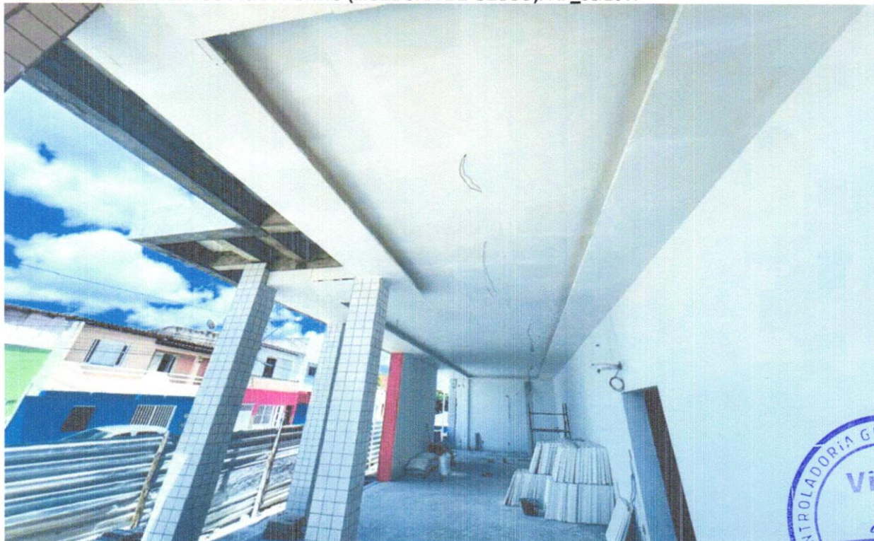
FOTO 16 - ACABAMENTOS PARA FORRO (MOLDURA DE GESSO). AF_05/2017
