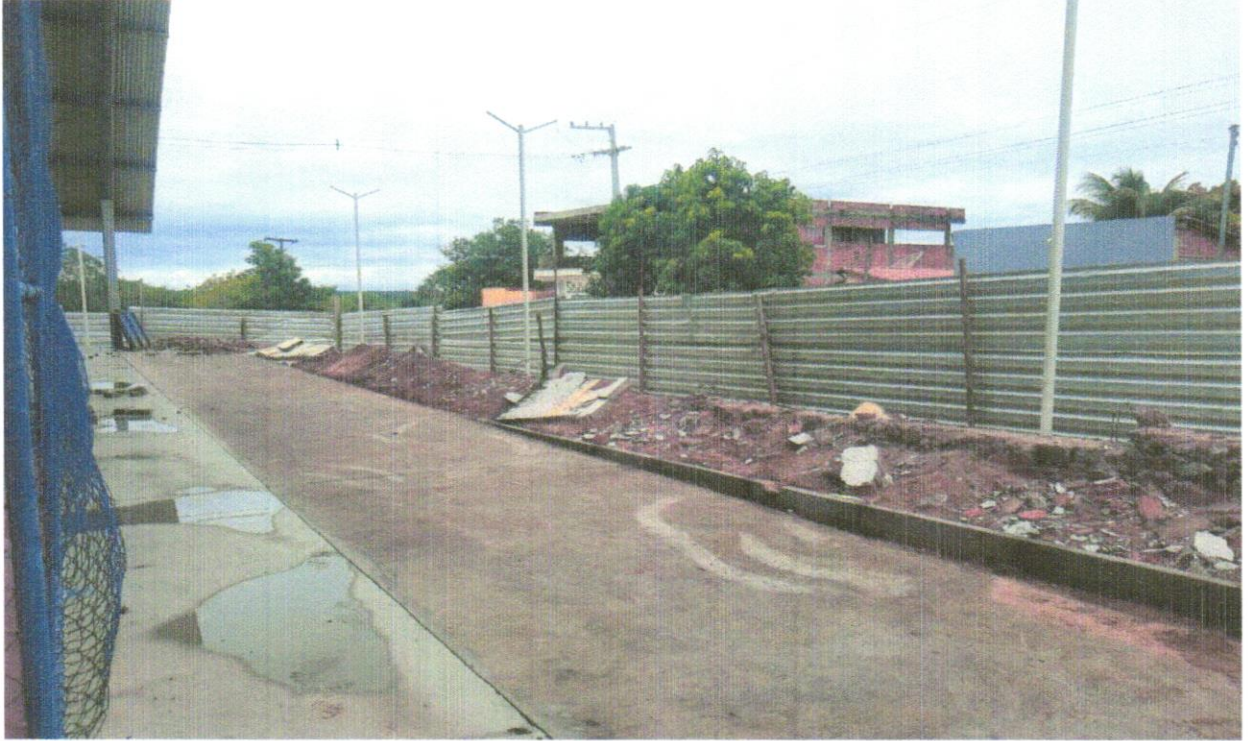
FOTO 04 - TAPUME COM TELHA METÁLICA. AF_05/2018
