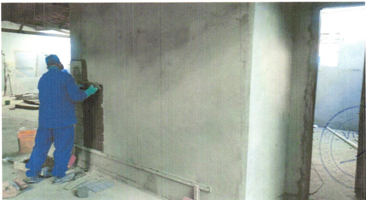
FOTO 18 - Revestimento cerâmico para parede, 10 x 10 cm, Tecnogres, linha Brilhante, ref. BR10060 ou similar, aplicado com argamassa industrializada ac-iii, rejuntado, exclusive regularização de base ou emboço - Rev 04
