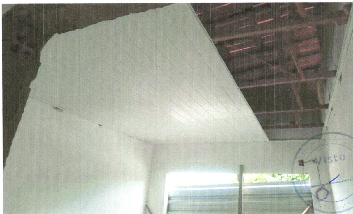
FOTO 12 - Forro de pvc, em régulas de 10 ou 20 cm, aplicado, inclusive estrutura para fixação (perfis em PVC) marca Araforros ou similar, instalado - Rev 06_10/2021 AF_06/2016_P
