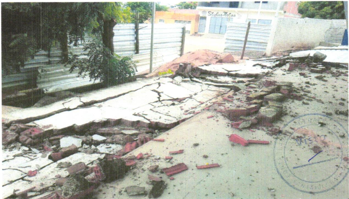
FOTO 02 - DEMOLIÇÃO DE ALVENARIA DE BLOCO FURADO, DE FORMA MANUAL, SEM REAPROVEITAMENTO. AF_12/2017
