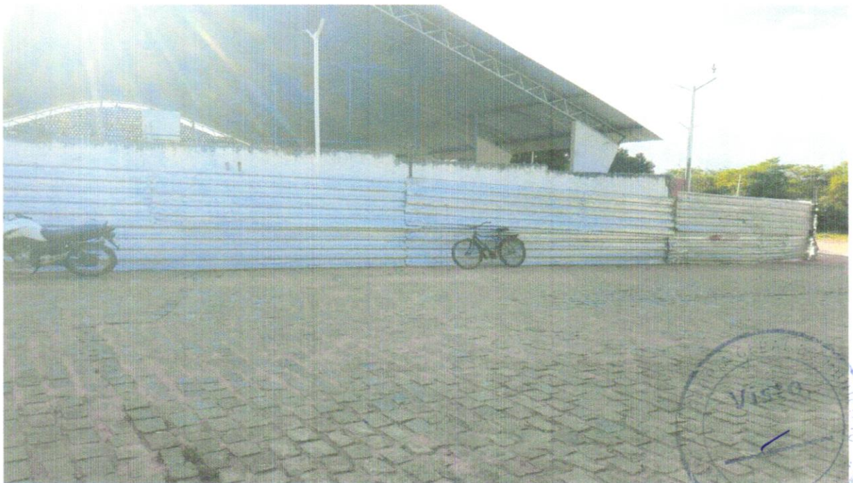
FOTO 04 - TAPUME COM TELHA METÁLICA. AF_05/2018
