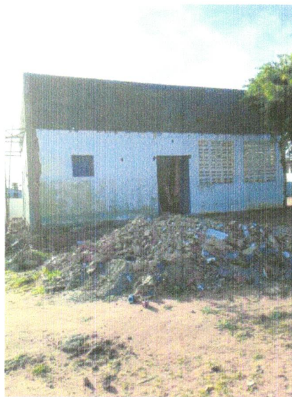
FOTO 01 – CHAPISCO APLICADO EM ALVENARIA (COM PRESENÇA DE VÃOS) E ESTRUTURAS DE CONCRETO DE FACHADA, COM EQUIPAMENTO DE PROJEÇÃO. ARGAMASSA TRAÇO 1:3 COM PREPARO EM BETONEIRA 400 L. AF_06/2014
