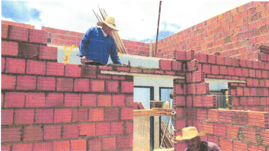
FOTO 09 – VERGA PRÉ-MOLDADA PARA JANELAS COM ATÉ 1,5 DE VÃO. AF_03/2016
