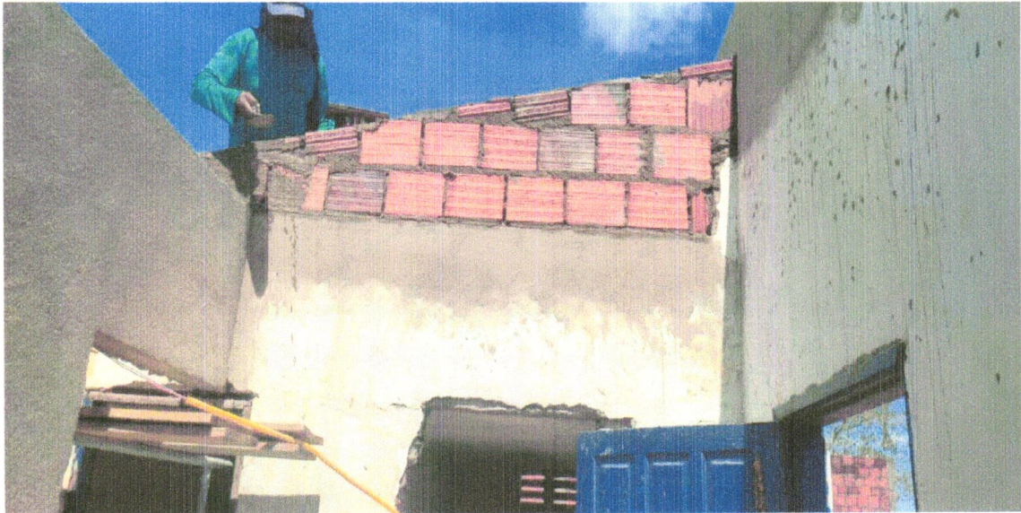
FOTO 03 -ALVENARIA DE VEDAÇÃO DE BLOCOS CERÂMICOS FURADOS NA HORIZONTAL DE 9X19X29 CM (ESPESSURA 9 CM) E ARGAMASSA DE ASSENTAMENTO COM PREPARO EM BETONEIRA. AF_12/2021
