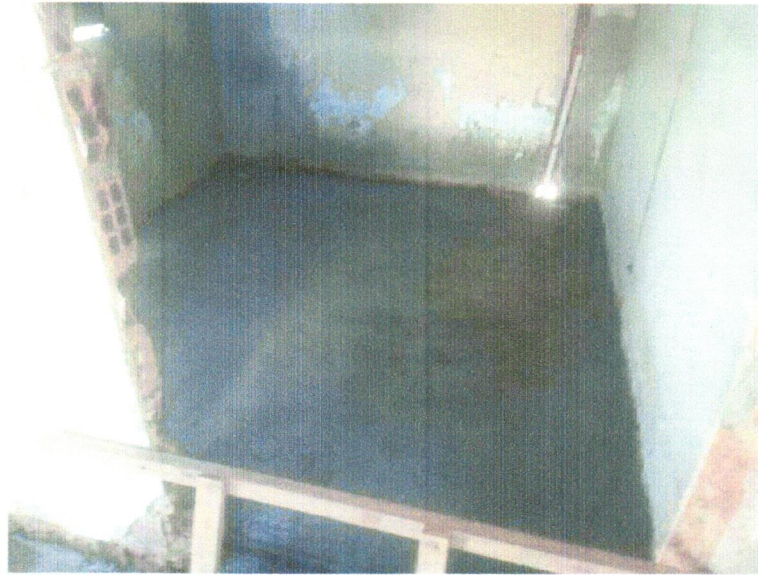
Foto 15 - contrapiso em argamassa traço 1:4 (cimento e areia), preparo mecânico com betoneira 400l, aplicado em áreas secas sobre laje, não aderido, acabamento não reforçado, espessura 5cm. Af_07/2021
