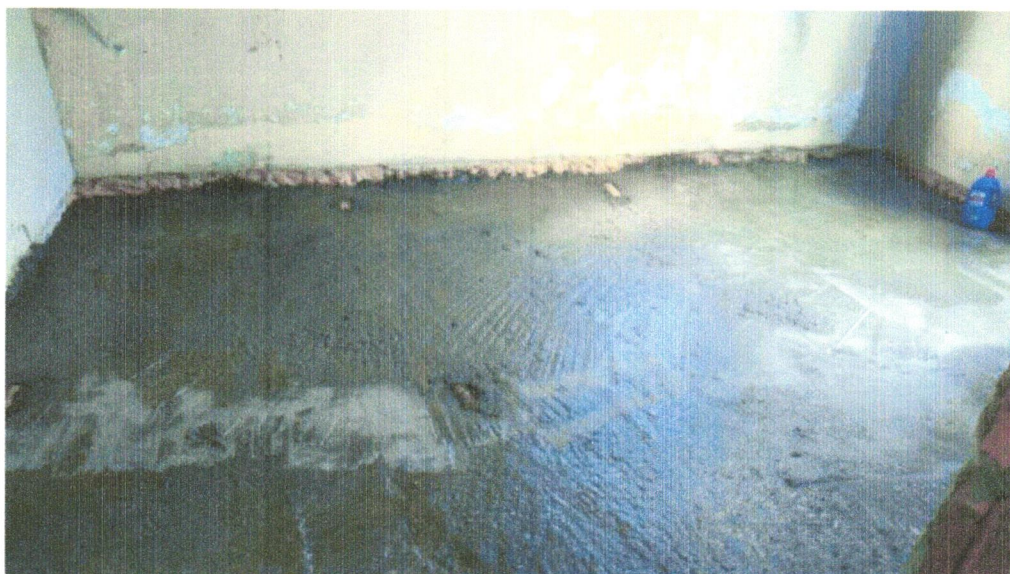
FOTO 12- PISO EM CONCRETO 20 MPA PREPARO MECÂNICO, ESPESSURA 7CM. AF_09/2020
