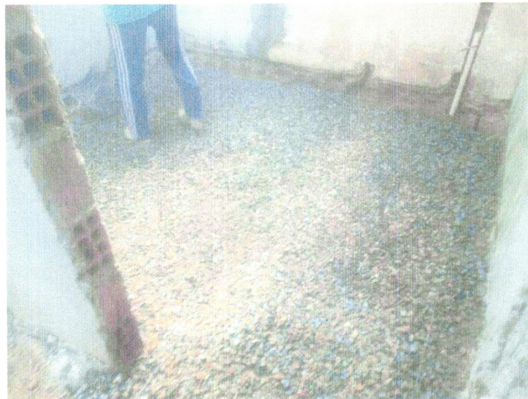
FOTO 04 - Lastro de brita graduada apiloada e=10cm
