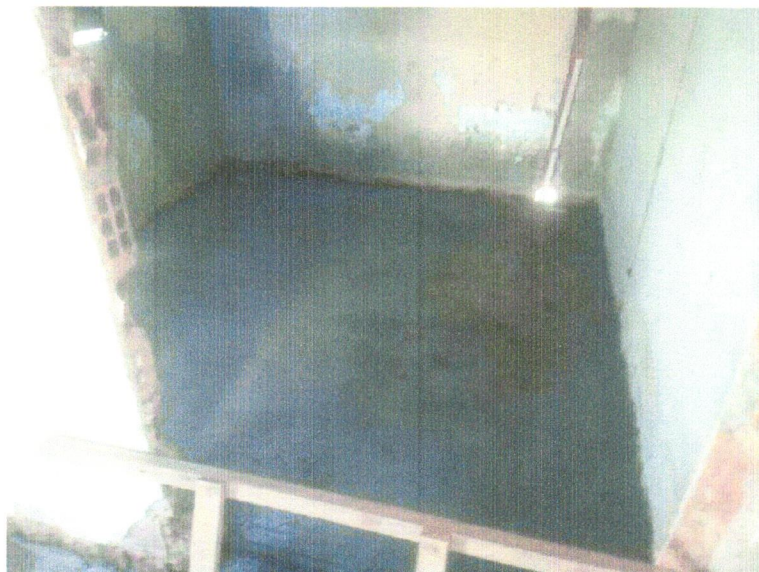
FOTO 13- PISO EM CONCRETO 20 MPA PREPARO MECÂNICO, ESPESSURA 7CM. AF_09/2020
