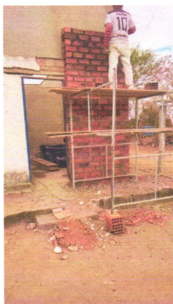
FOTO 02 – Alvenaria tijolo cerâmico maciço (5x9x19), esp = 0,05m (facão), com argamassa traço t5 - 1:2:8 (cimento / cal / areia) c/ junta de 2,0cm - R1
