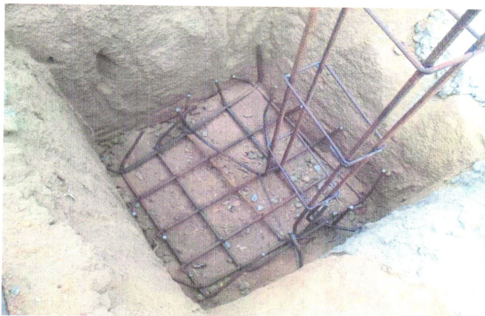
FOTO 02 - - ESCAVAÇÃO MANUAL PARA SAPATA AF_06/2017
