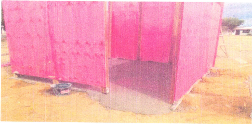
FOTO 09 – Barracão para Obras de Médio Porte Reaproveitamento
