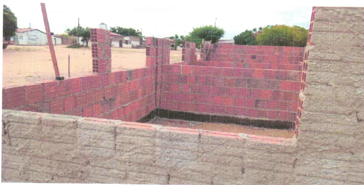
Foto 06– ALVENARIA DE VEDAÇÃO DE BLOCOS CERÂMICOS FURADOS NA VERTICAL DE 9X19X39CM (ESPESSURA 9CM) DE PAREDES
