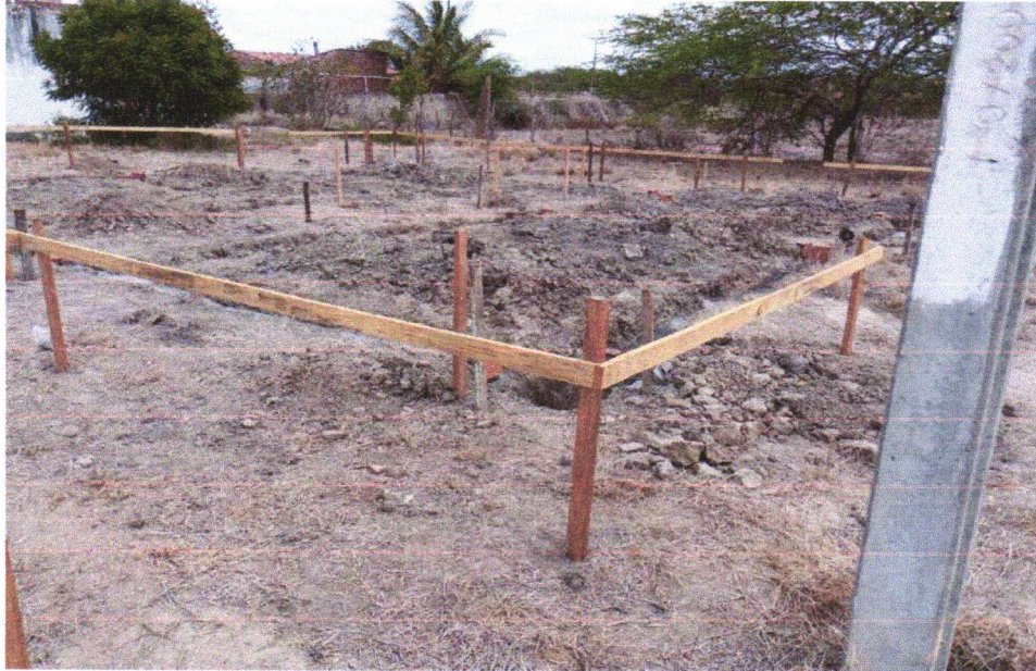
FOTO 03 - ESCAVAÇÃO MANUAL DE VALA PARA VIGA BALDRAME (INCLUINDO ESCAVAÇÃO PARA COLOCAÇÃO DE FÔRMAS). AF_06/2017
