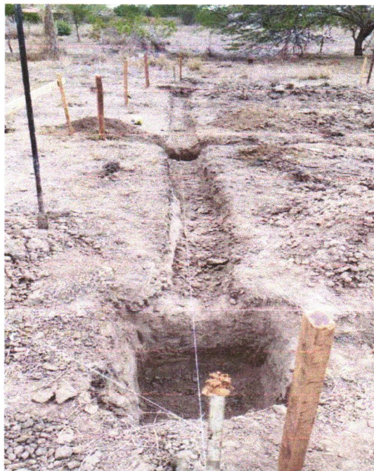
Foto 06 – ESCAVAÇÃO MANUAL DE VALA PARA VIGA BALDRAME (INCLUINDO ESCAVAÇÃO PARA COLOCAÇÃO DE FÔRMAS). AF_06/2017
