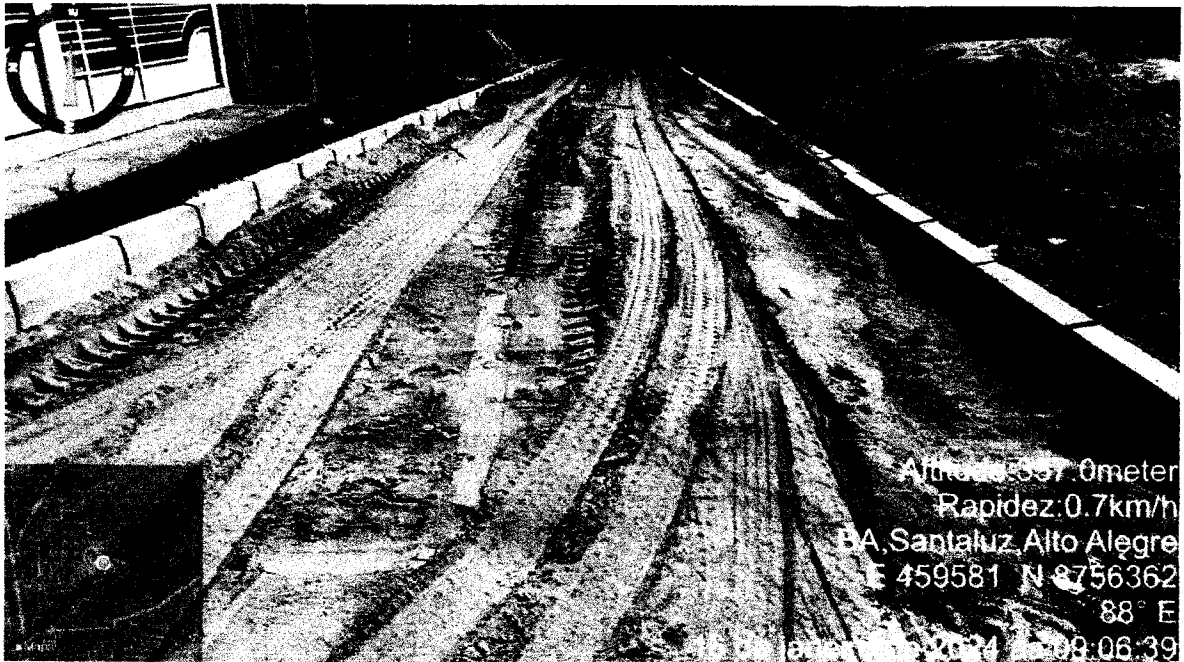
Execução de pavimentação caminho da saúde rua 09
