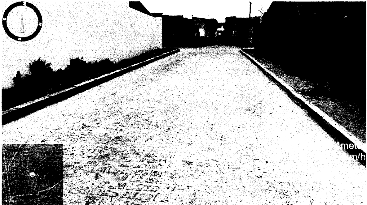
Execução de pavimentação caminho da saúde rua 08
