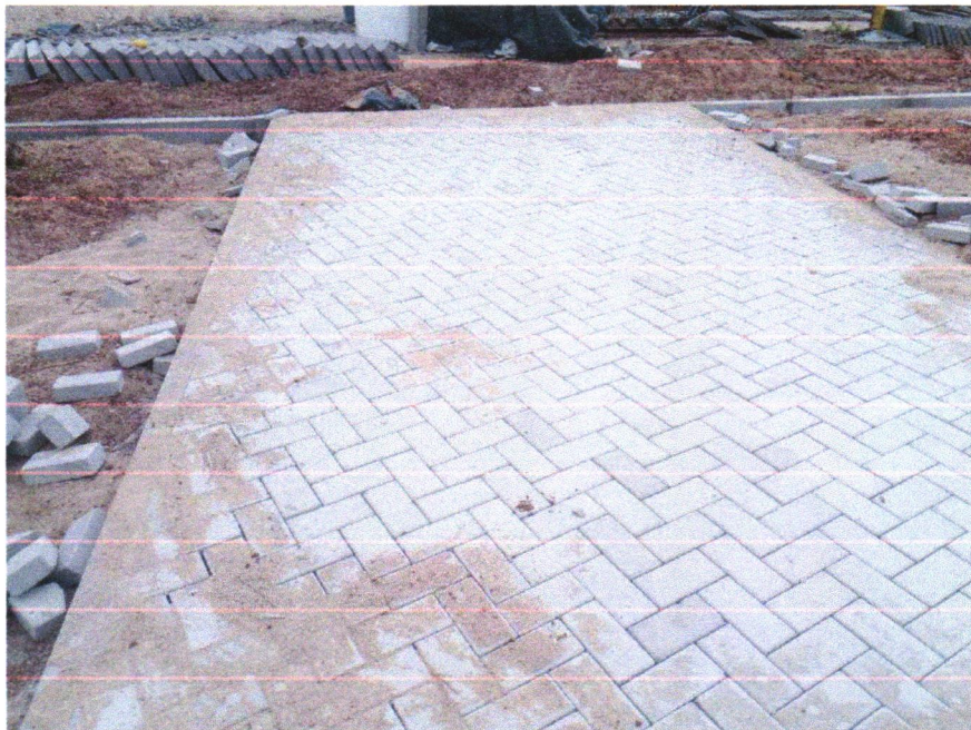
Foto 10 - Pavimentação em bloco de concreto vibroprensado, intertravado, cor natural, 10x20cm, e=6cm, 46un/m 2 , NBR9781, Fck(min)=35MPa, sob coxim areia grossa compactada c/ placa vibratória, e(comp.)=6cm,
