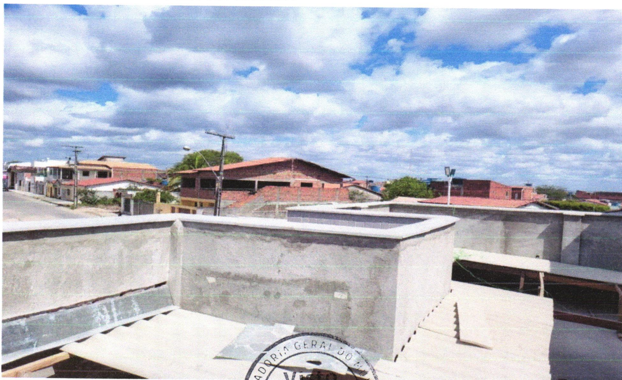
FOTO 08 - CHAPIM DE CONCRETO PRÉ-MOLDADO
