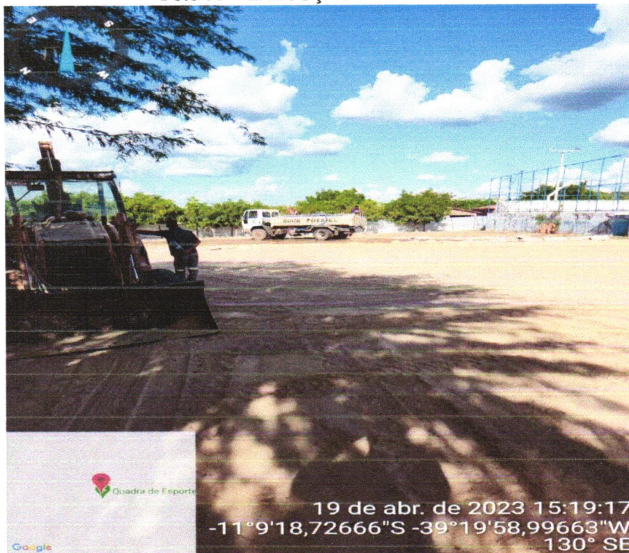
Foto 03 – EXECUÇÃO DO ATERRO.
