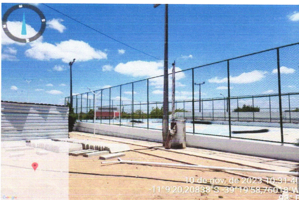
Foto 10- EXECUÇÃO DOS POSTES E ALAMBRADO
