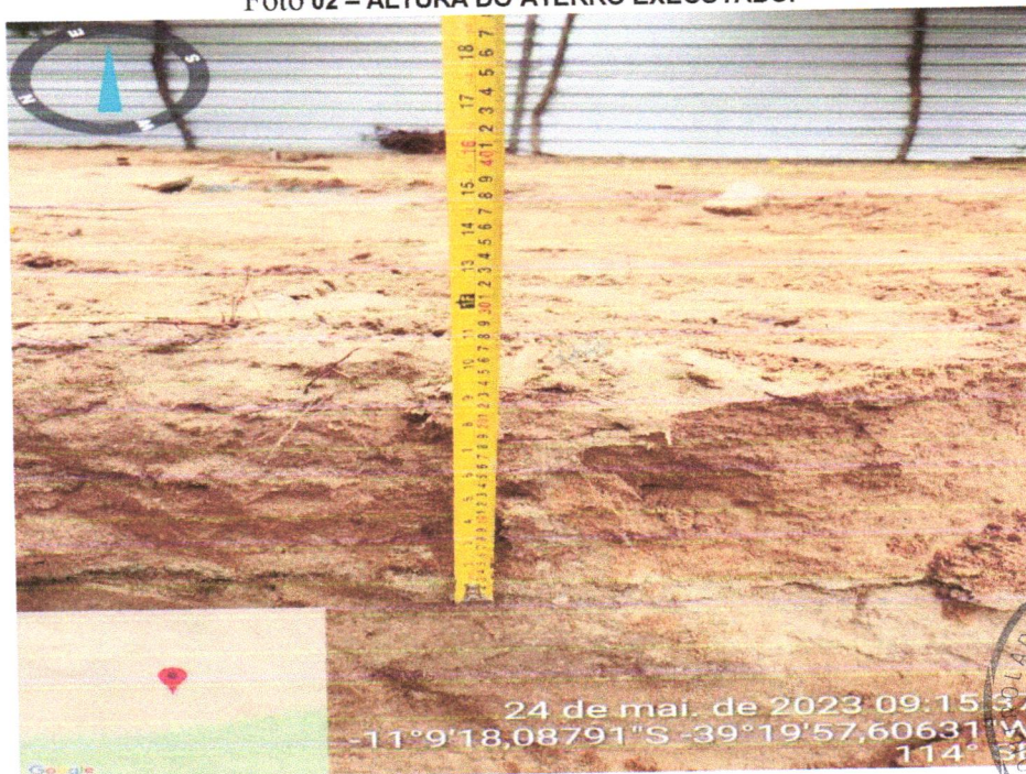
Foto 02 – ALTURA DO ATERRO EXECUTADO.
