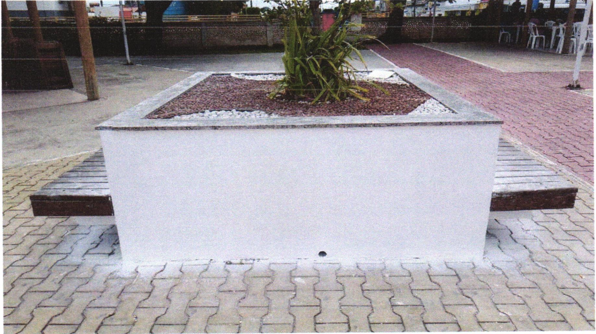
FOTO 07 - EMASSAMENTO DE PAREDES DO CANTEIRO.
