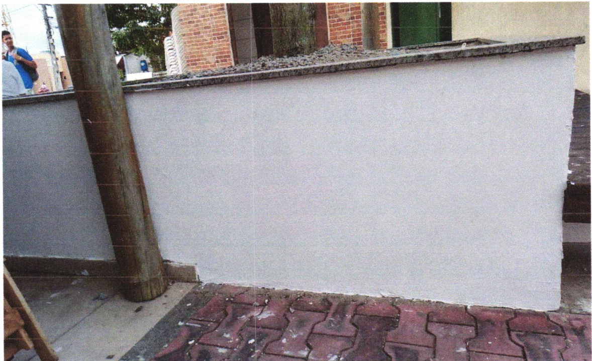
FOTO 06 - EMASSAMENTO DE PAREDES DO CANTEIRO.
