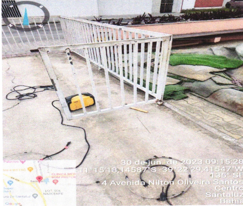
FOTO 03 – REMOÇÃO DE GRAMA SINTÉTICA E CONSERTO DE PORTÃO METÁLICO
