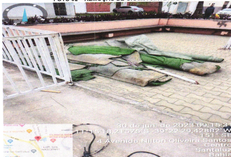
FOTO 02 – REMOÇÃO DE GRAMA SINTÉTICA
