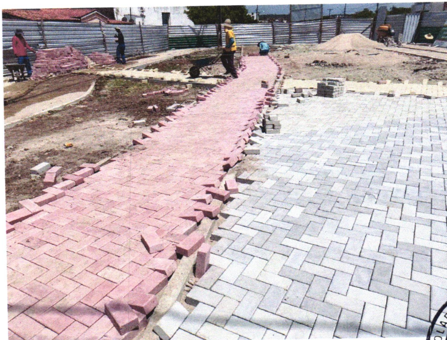
Foto 10 - EXECUÇÃO DE PASSEIO EM PISO INTERTRAVADO, COM BLOCO RETANGULAR COLORIDO DE 20 X 10 CM, ESPESSURA 6 CM. AF_12/2015
