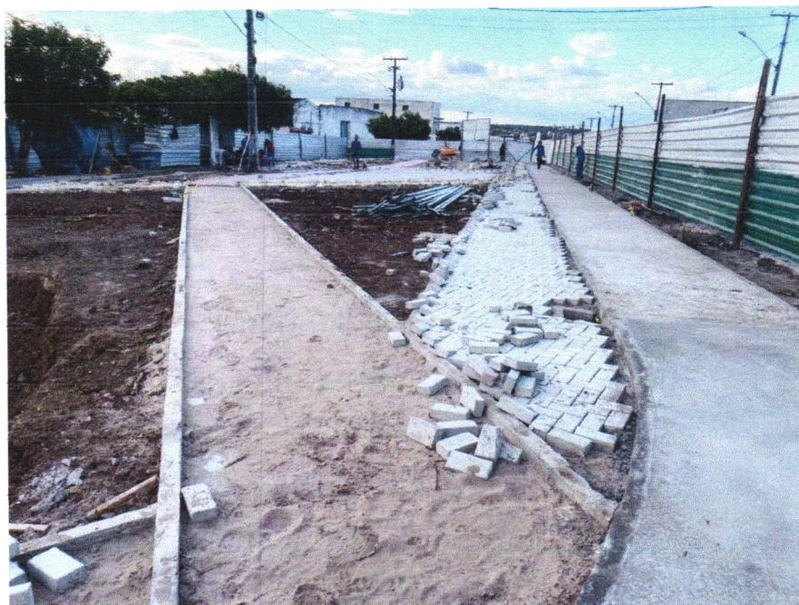
Foto 07 - EXECUÇÃO DE PASSEIO (CALÇADA) OU PISO DE CONCRETO COM CONCRETO MOLDADO IN LOCO, FEITO EM OBRA, ACABAMENTO CONVENCIONAL, ESPESSURA 6 CM, ARMADO. AF_07/2016
