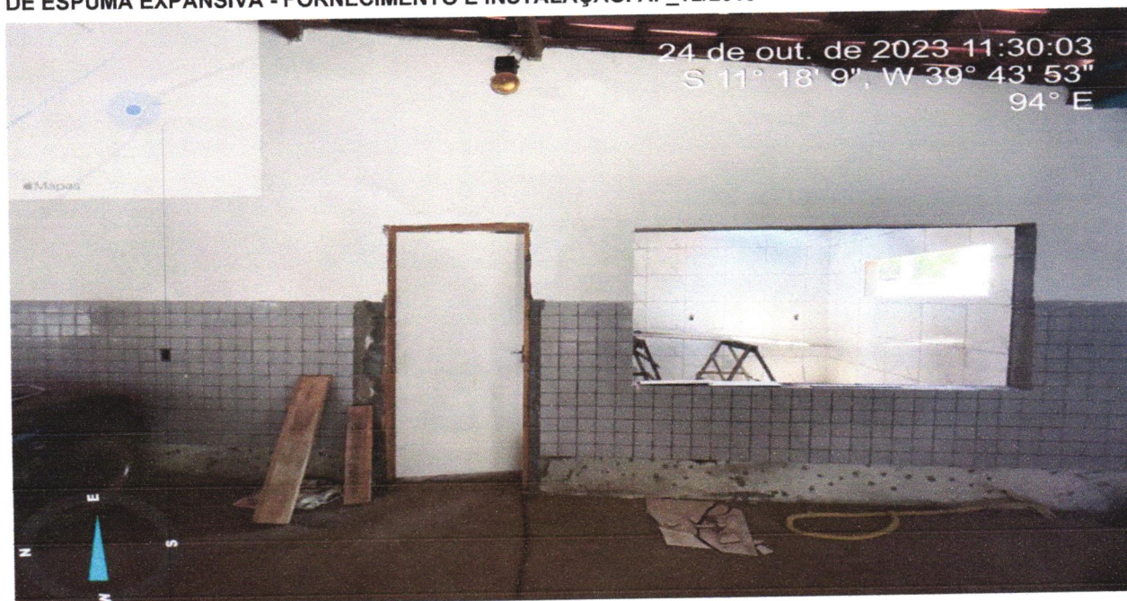
FOTO 02 - KIT DE PORTA-PRONTA DE MADEIRA EM ACABAMENTO MELAMÍNICO BRANCO, FOLHA LEVE OU MÉDIA, 80X210CM, EXCLUSIVE FECHADURA, FIXAÇÃO COM PREENCHIMENTO PARCIAL DE ESPUMA EXPANSIVA - FORNECIMENTO E INSTALAÇÃO. AF_12/2019
