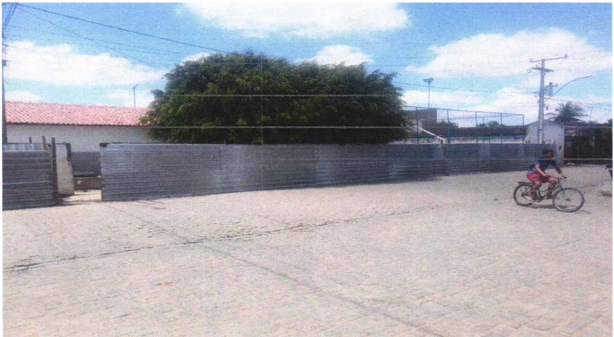
FOTO 02 - TAPUME COM TELHA METÁLICA. AF_05/2018
