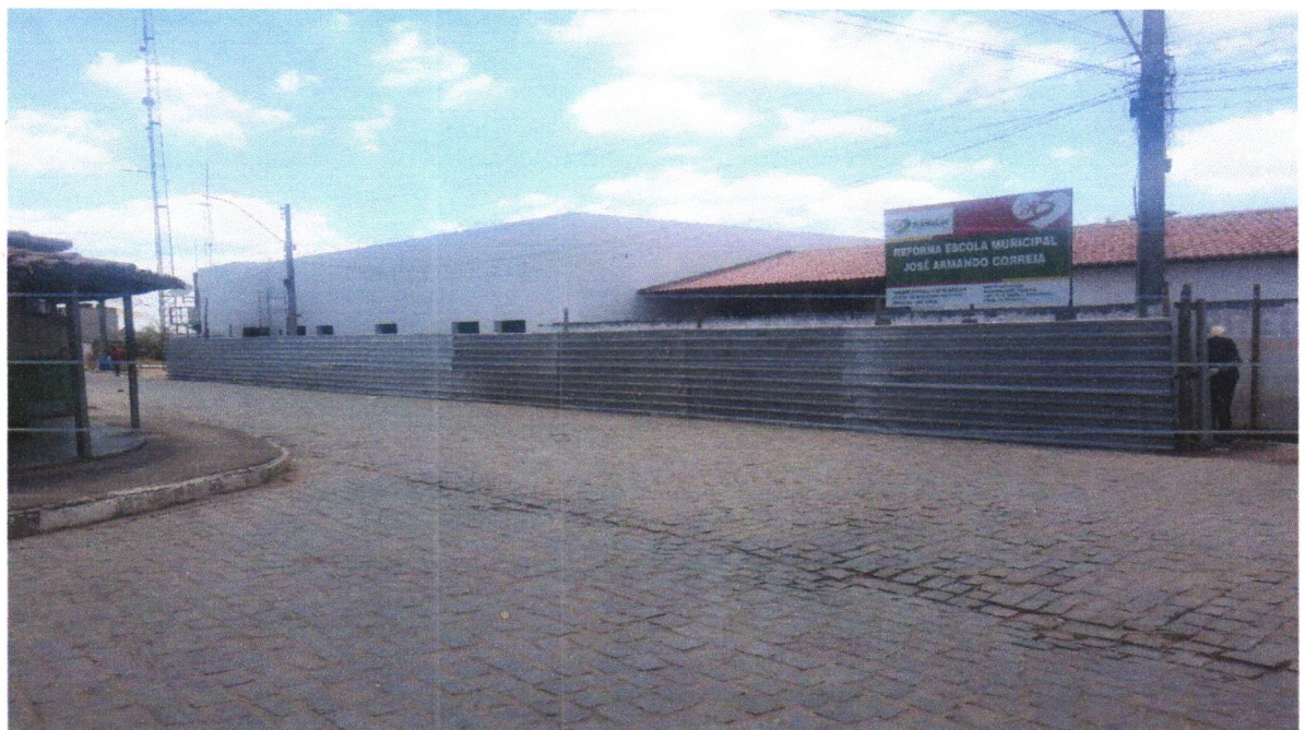
FOTO 02 - TAPUME COM TELHA METÁLICA. AF_05/2018
