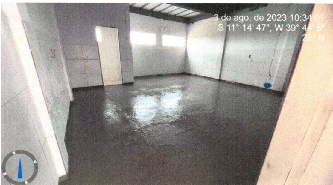
Foto 12 – Piso alta resistencia, cor cinza, e=10mm, aplicado com juntas, polido até o esmeril 400 e encerado, exclusive argamassa de regularização
