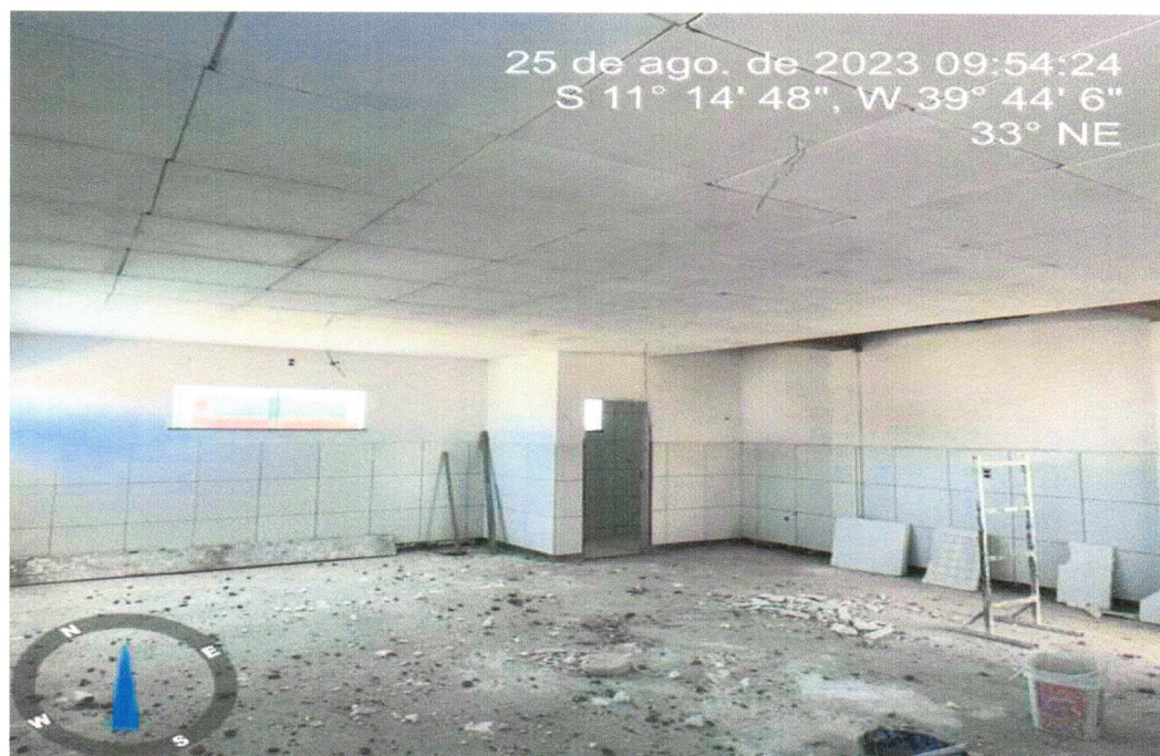
Foto 08 - FORRO EM PLACAS DE GESSO, PARA AMBIENTES COMERCIAIS. AF_05/2017_P
