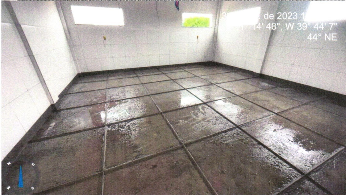
Foto 09 – Piso alta resistencia, cor cinza, e=10mm, aplicado com juntas, polido até o esmeril 400 e encerado, exclusive argamassa de regularização
