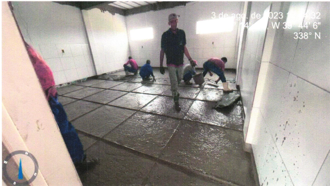
Foto 10 – Piso alta resistencia, cor cinza, e=10mm, aplicado com juntas, polido até o esmeril 400 e encerado, exclusive argamassa de regularização
