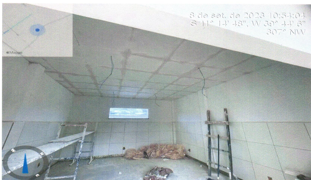
Foto 07 - FORRO EM PLACAS DE GESSO, PARA AMBIENTES COMERCIAIS. AF_05/2017_P
