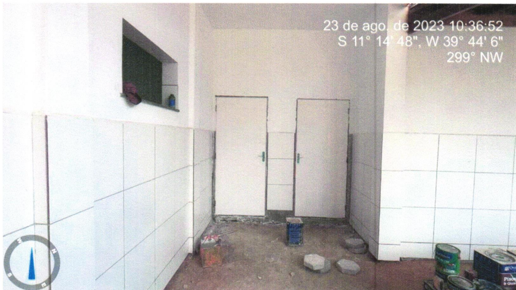
Foto 04 - KIT DE PORTA-PRONTA DE MADEIRA EM ACABAMENTO MELAMÍNICO BRANCO, FOLHA LEVE OU MÉDIA, 80X210CM, EXCLUSIVE FECHADURA, FIXAÇÃO COM PREENCHIMENTO PARCIAL DE ESPUMA EXPANSIVA - FORNECIMENTO E INSTALAÇÃO. AF_12/2019
