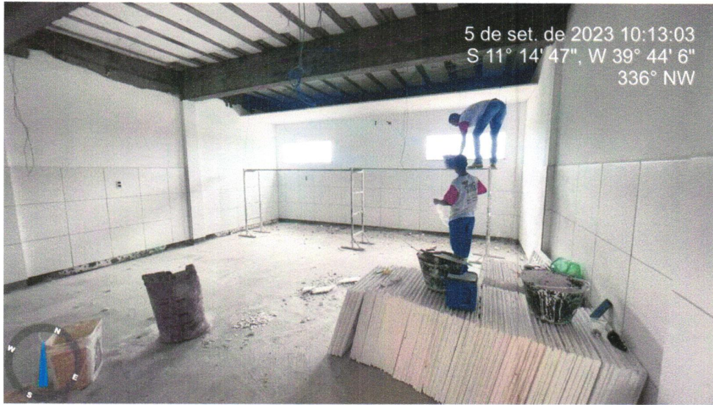
Foto 05 - FORRO EM PLACAS DE GESSO, PARA AMBIENTES COMERCIAIS. AF_05/2017_P
