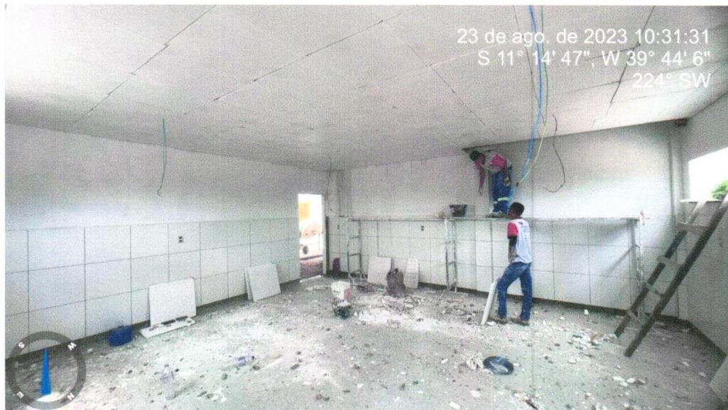
Foto 06 - FORRO EM PLACAS DE GESSO, PARA AMBIENTES COMERCIAIS. AF_05/2017_P
