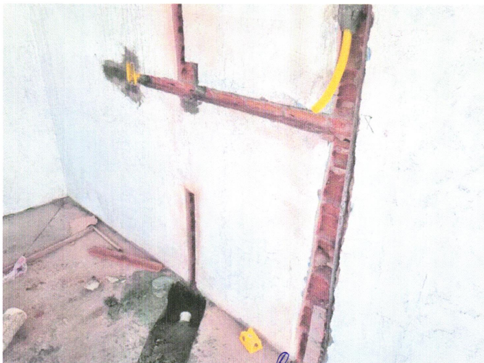
FOTO 10 – INSTALAÇÃO ELÉTRICA E HIDRÁULICA PARA LAVANDERIA
