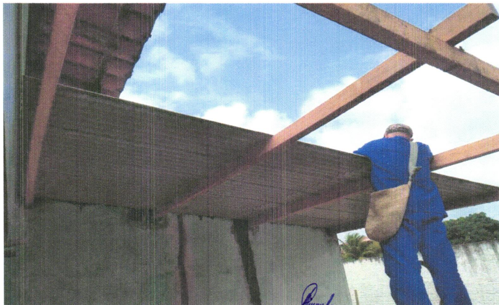
FOTO 08 - EXECUÇÃO DE COBERTURA DE FIBROCIMENTO
