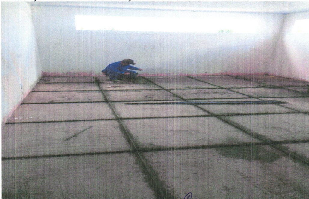
FOTO 02 – EXECUÇÃO DE JUNTA DE DILATAÇÃO PARA PISO DE ALTA RESISTÊNCIA
