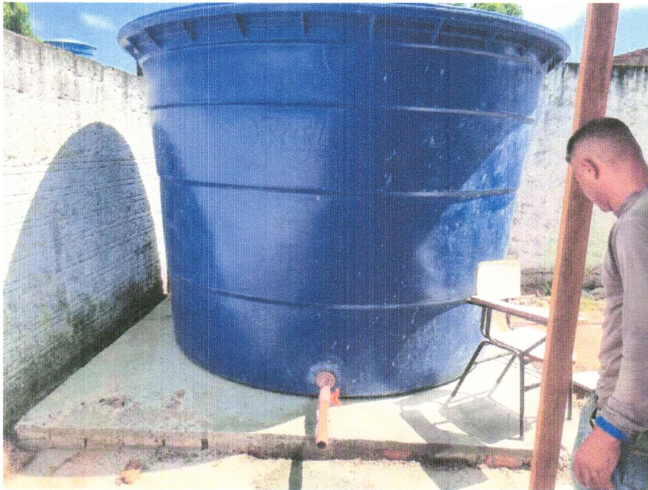
FOTO 09 – INSTALAÇÃO DO RESERVATÓRIO
