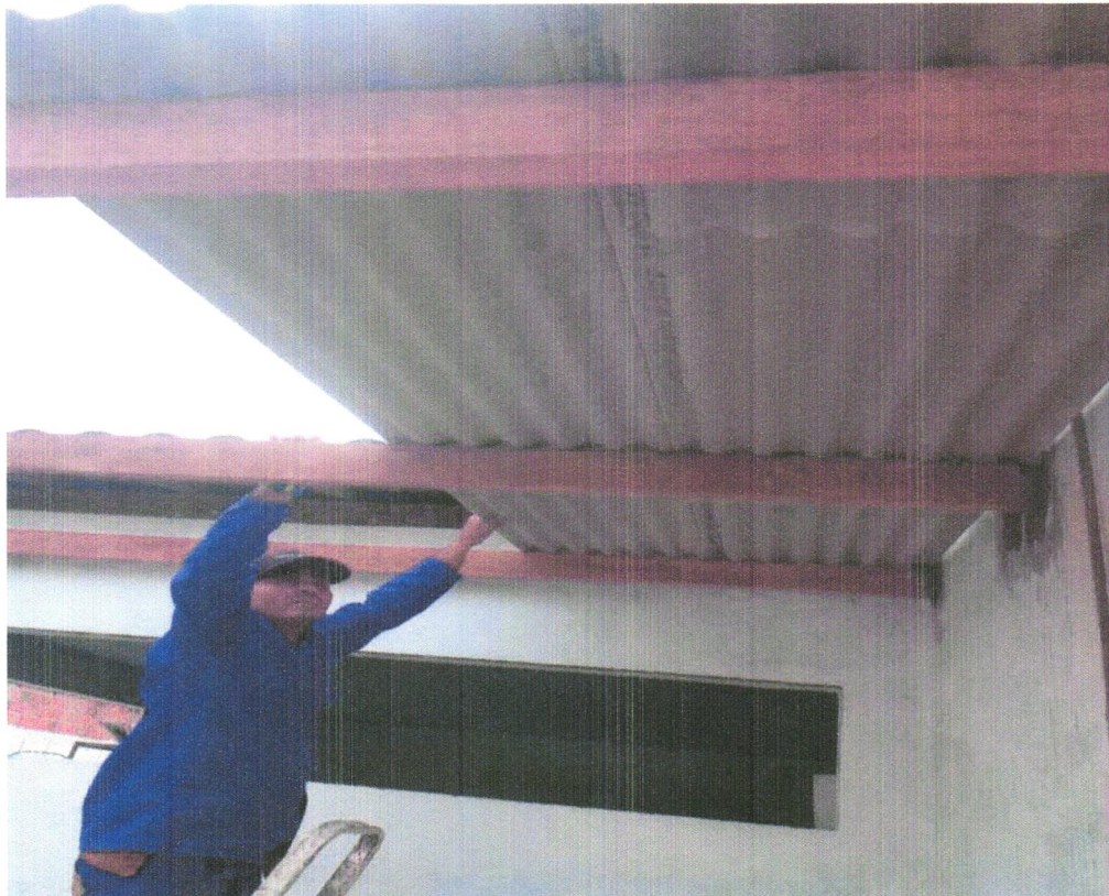
FOTO 08 - EXECUÇÃO DE COBERTURA DE FIBROCIMENTO
