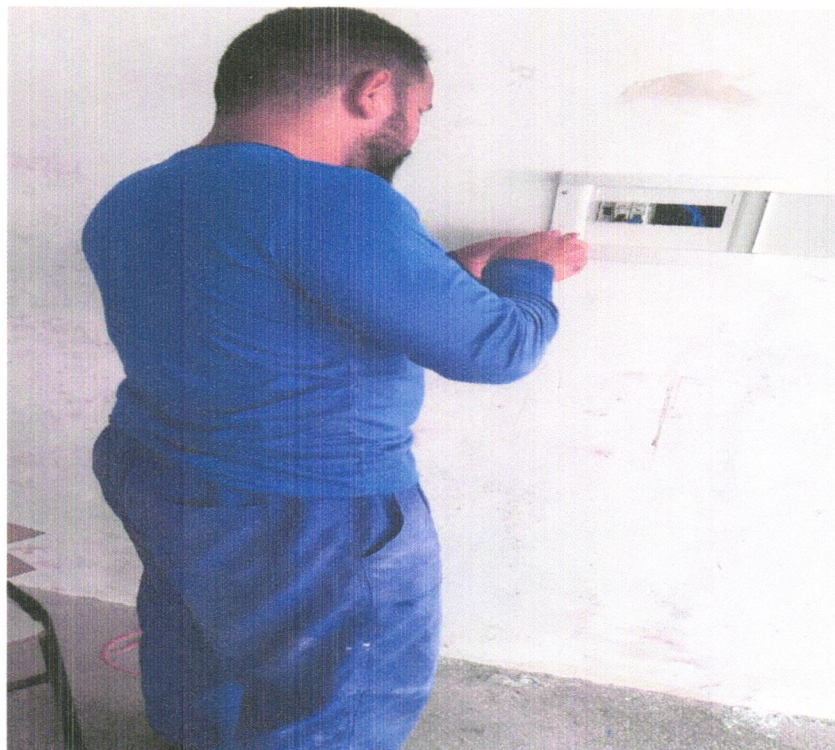
FOTO 06 - INSTALAÇÃO DO QUADRO DE DISTRIBUIÇÃO
