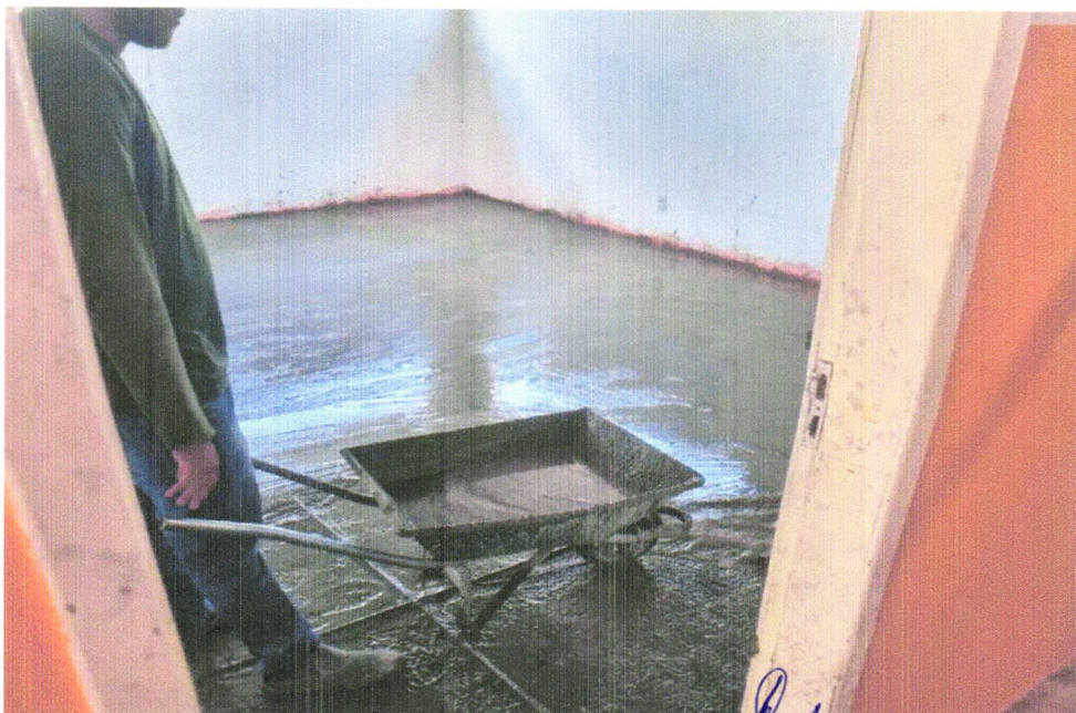
FOTO 04 - DEMOLIÇÃO DE PISO DE ALTA RESISTÊNCIA
