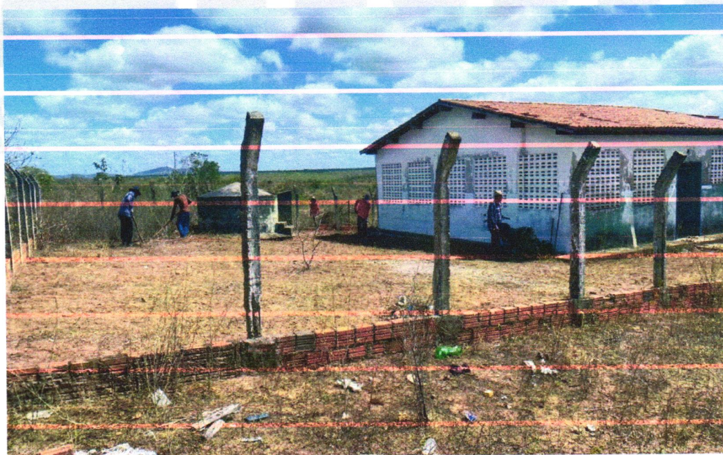
Limpeza manual de terreno com enxada
