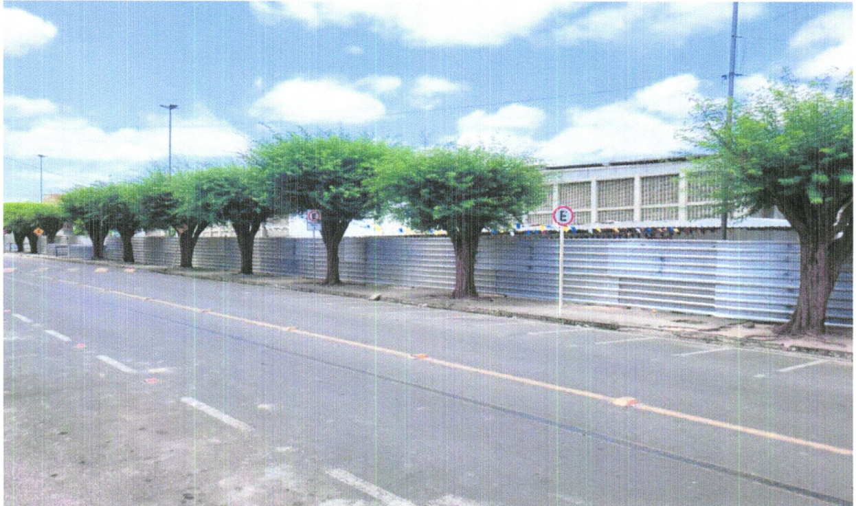
FOTO 04 - TAPUME COM TELHA METÁLICA. AF_05/2018
