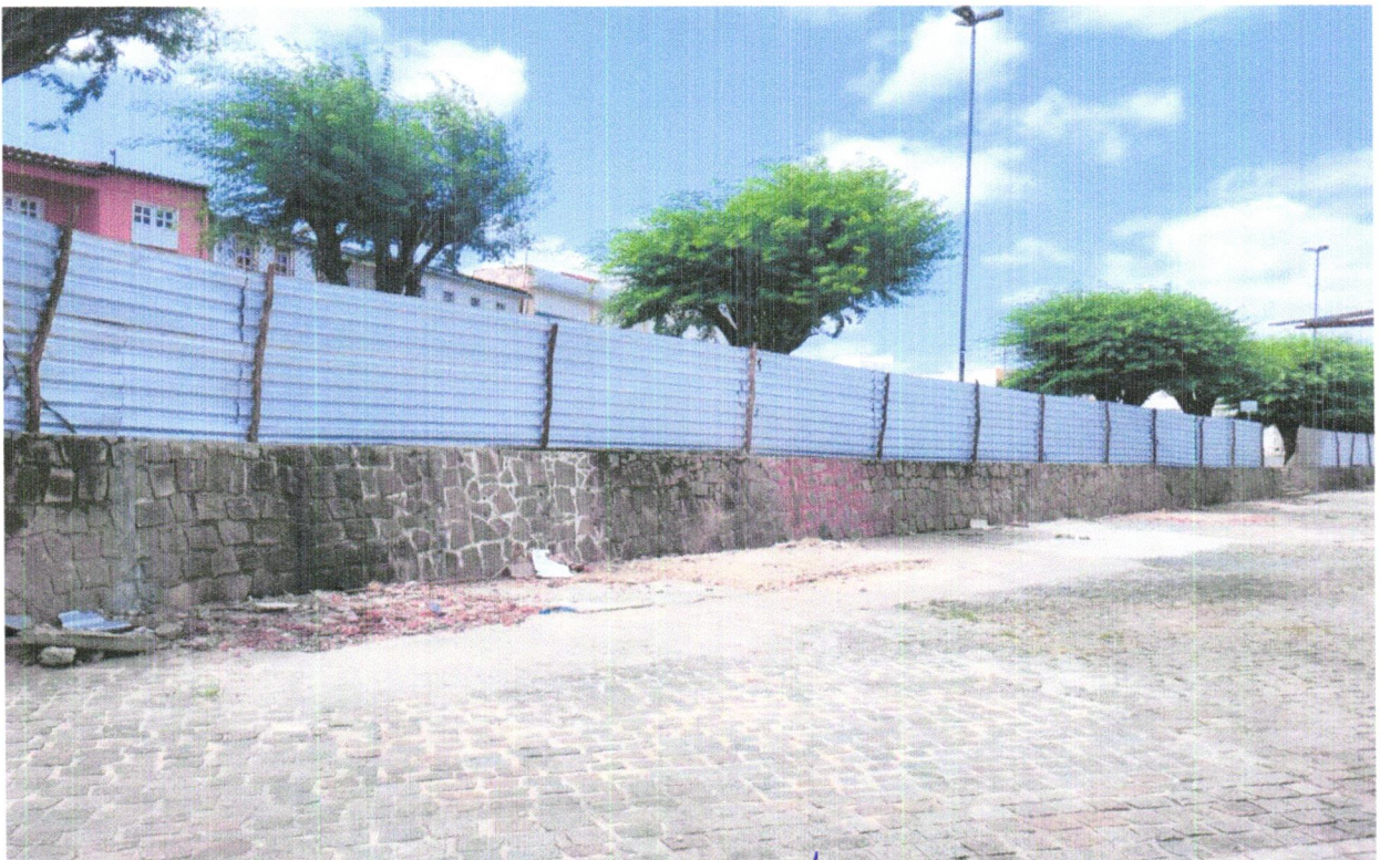
FOTO 04 - TAPUME COM TELHA METÁLICA. AF_05/2018
