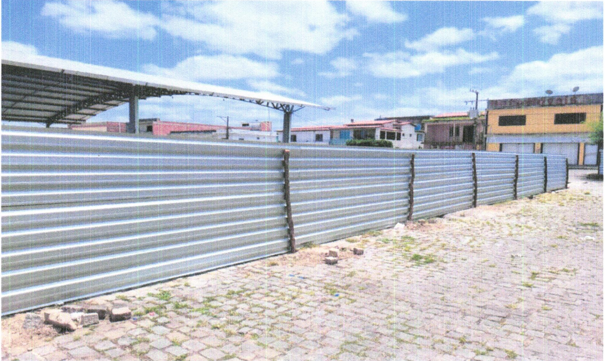
FOTO 08 - TAPUME COM TELHA METÁLICA. AF_05/2018
