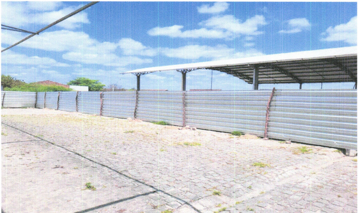
FOTO 06 - TAPUME COM TELHA METÁLICA. AF_05/2018
