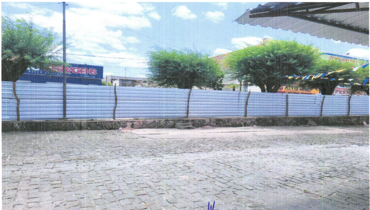
FOTO 08 - TAPUME COM TELHA METÁLICA. AF_05/2018
