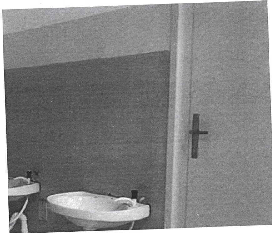
Foto 07- Colocação de Fechaduras
